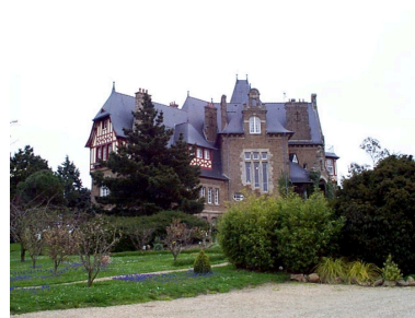
Vue générale sud-ouest Phot. Claude Quillivic IVR53_19993507457NUCA
