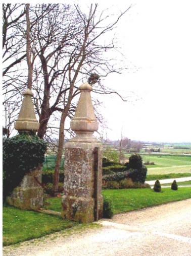
Les piliers d'entrée Phot. Claude Quillivic IVR53_19993507456NUCA
