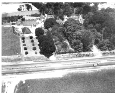
Vue aérienne vers le nord Phot. G.A.L.A.T. IVR53_19843500586V
