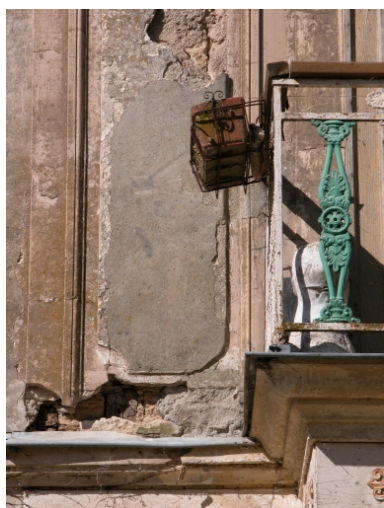
Détail sur l'enduit. Phot. Claude Quillivic IVR53_20043504390NUCA
