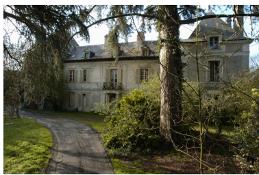
Vue générale nord Phot. Norbert Lambart IVR53_20043500395NUCA
