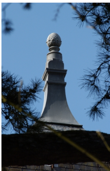
Epi de faîtage Phot. Norbert Lambart IVR53_20043500396NUCA
