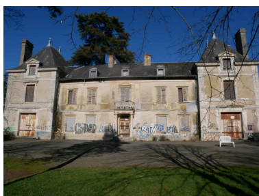
Façade arrière Phot. Tiphaine Berger IVR53_20193505440NUCA
