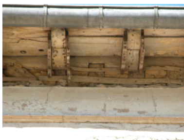
Détail de la corniche. Phot. Claude Quillivic IVR53_20043504391NUCA
