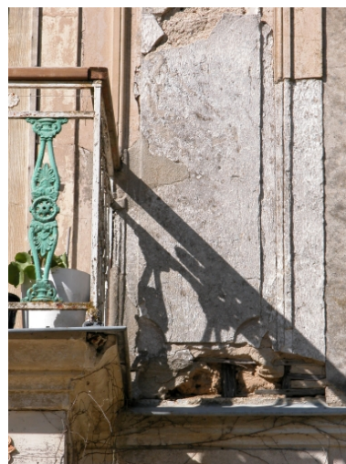
Détail sur l'enduit. Phot. Claude Quillivic IVR53_20043504389NUCA
