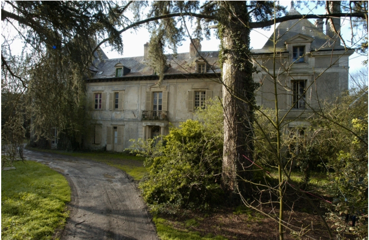
Vue générale nord
