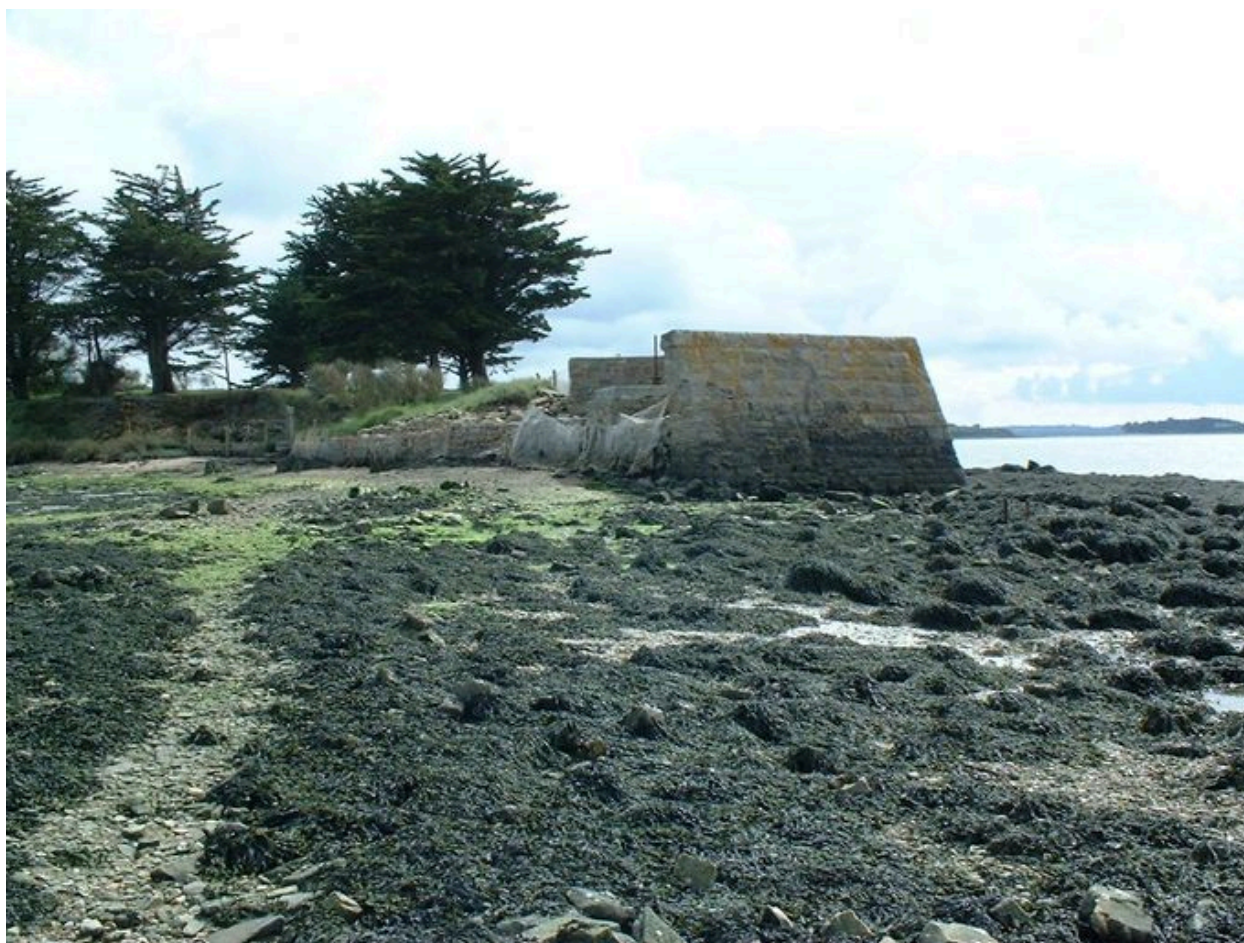
Vestiges de la vanne du Grand Pont (îlot Bechit)
