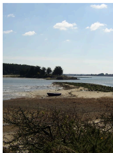
Vue générale du Grand Pont Phot. Johan Vincent IVR53_20065606573NUCA
