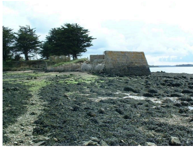
Vestiges de la vanne du Grand Pont (îlot Bechit) Phot. Julien Amghar IVR53_20085606101NUCA
