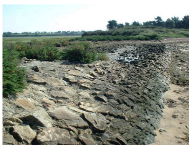
Petite digue entre l'îlot Bechit et la presqu'île de la Villeneuve Phot. Julien Amghar IVR53_20085606100NUCA
