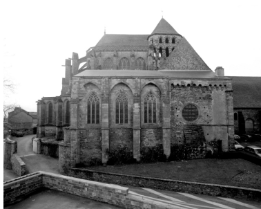
Elévation Nord du choeur. Phot. Guy Artur, Phot. Norbert Lambart IVR53_19953500187X
