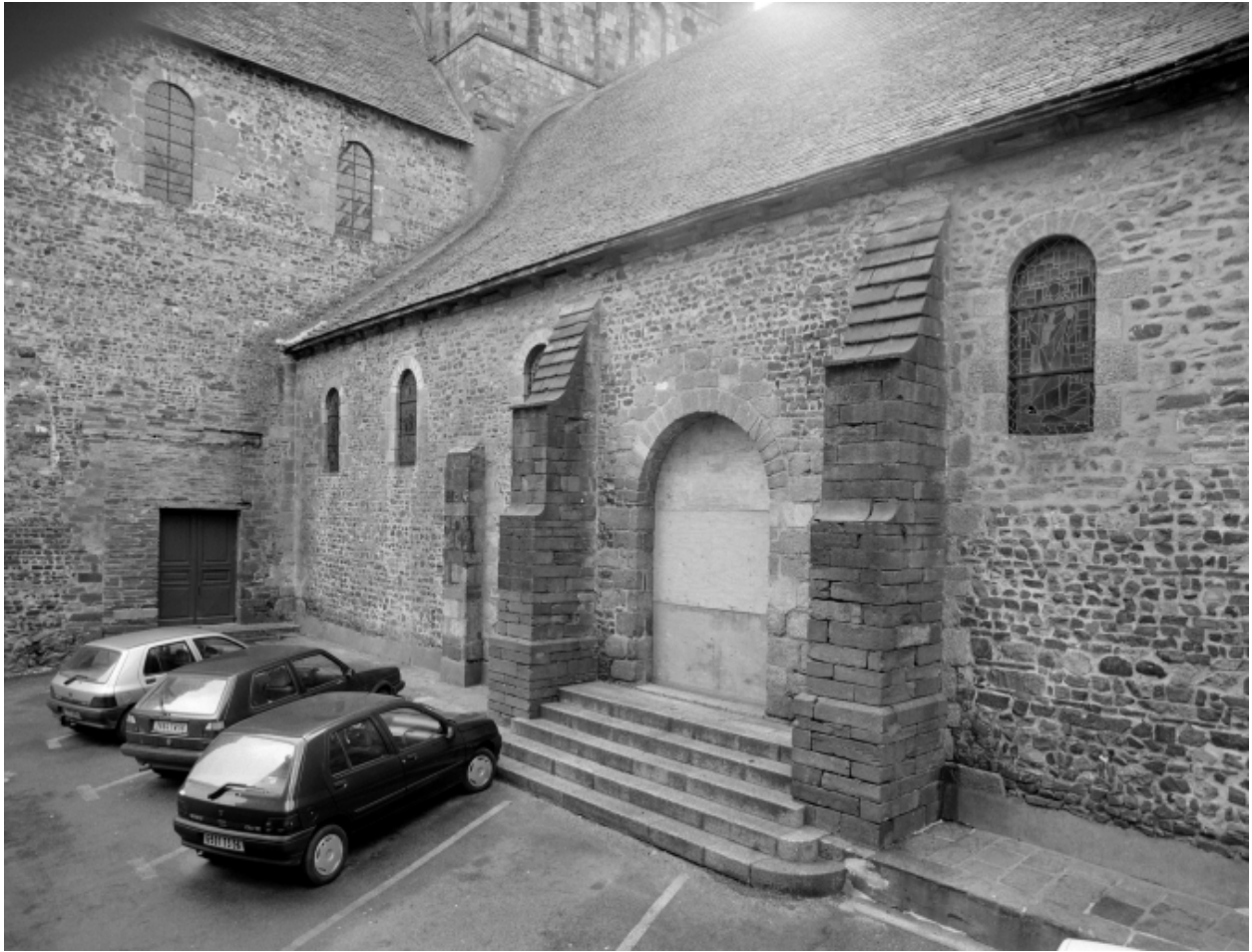
Vue partielle du collatéral nord de la nef et du bras nord
