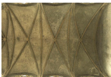
Choeur, vue rapprochée des voûtes Phot. Norbert Lambart IVR53_20073500849NUCA
