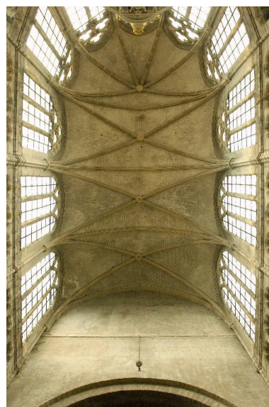
Choeur, vue en contre plongée sur les voûtes Phot. Norbert Lambart IVR53_20073500850NUCA
