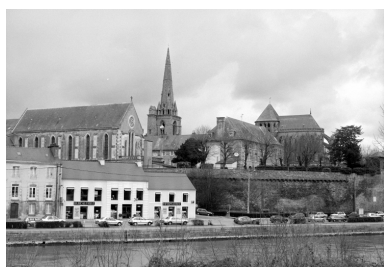
Elévation Sud-Ouest : vue de situation Phot. Guy Artur, Phot. Norbert Lambart IVR53_19953500184X
