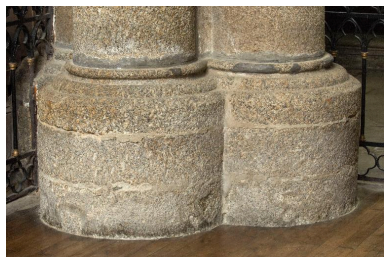
Bases des piles du choeur Phot. Norbert Lambart IVR53_20073500881NUCA
