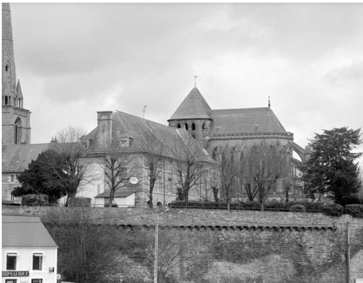
Elévation Sud-Ouest : vue générale
