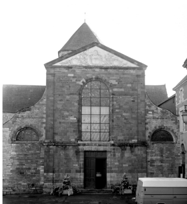
Elévation Ouest : vue générale Phot. Guy Artur, Phot. Norbert Lambart IVR53_19943502425X
