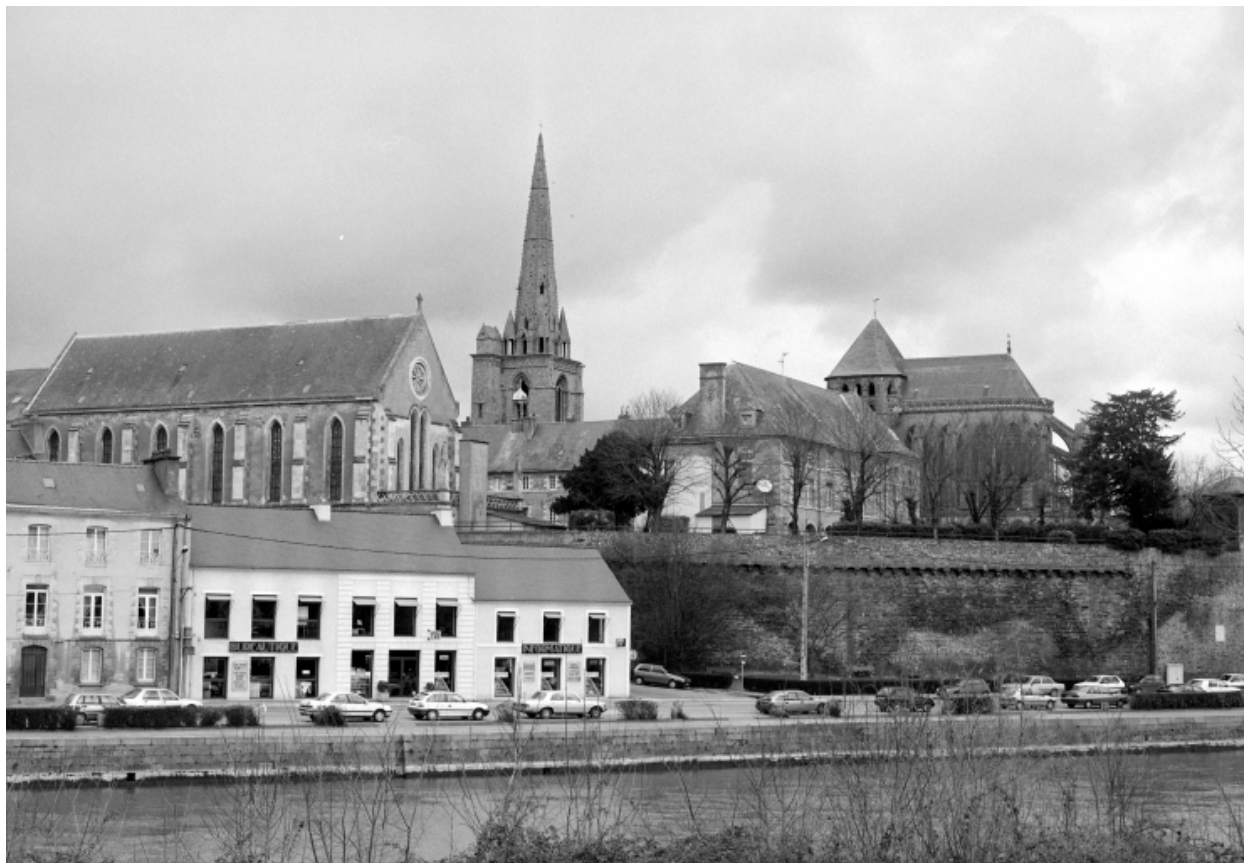
Elévation Sud-Ouest : vue de situation
