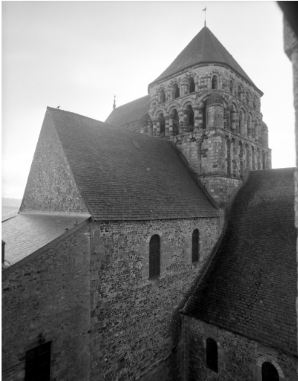
Tour de croisée et bras nord du transept.
