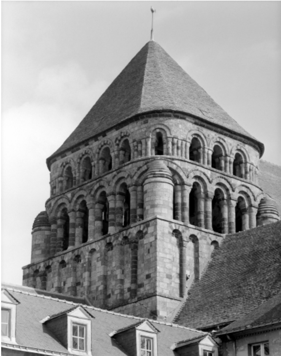
Tour de croisée, vue prise depuis le sud-ouest.
