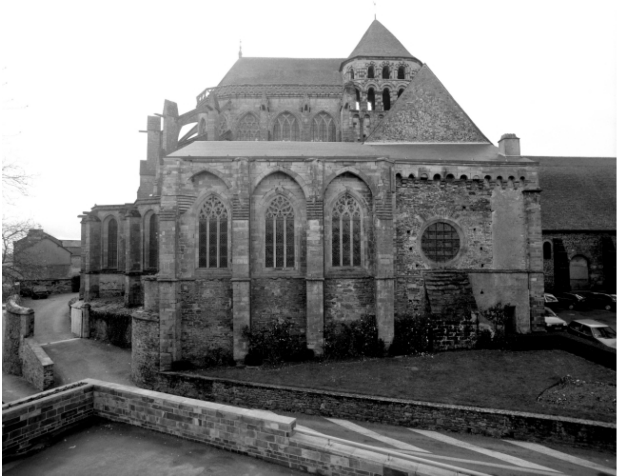
Elévation Nord du chœur.
