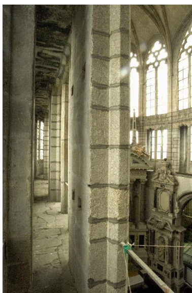
Choeur, vue oblique depuis le triforium. Phot. Norbert Lambart IVR53_20073500861NUCA
