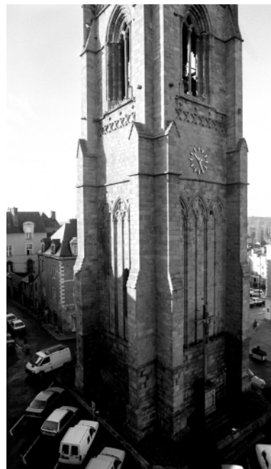
Elévation Nord-Est, clocher, partie basse : vue générale Phot. Guy Artur, Phot. Norbert Lambart IVR53_19943502424X
