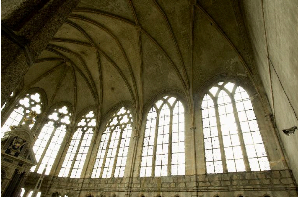
Choeur, vue oblique en contre plongée vers les voûtes.
