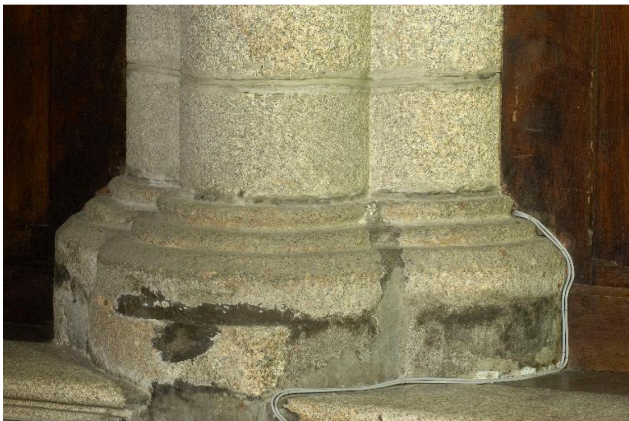
Bases des piles du choeur
