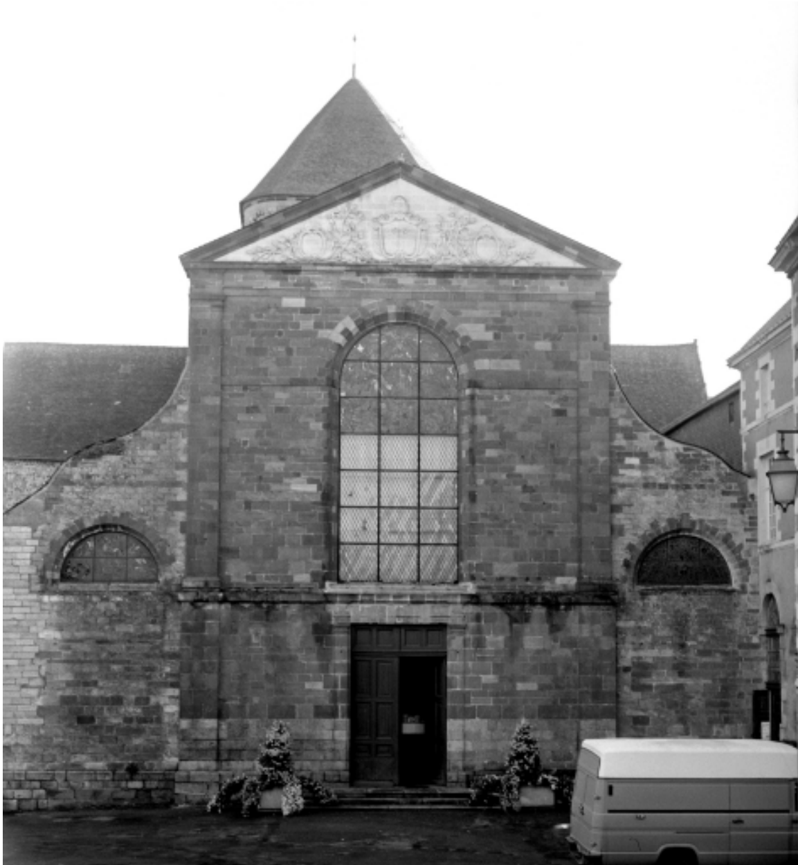
Elévation Ouest : vue générale
