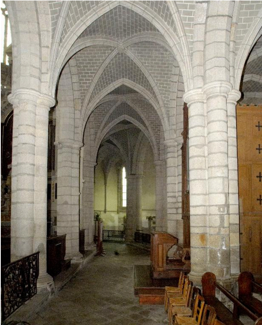
Vue du déambulatoire du choeur, côté sud
