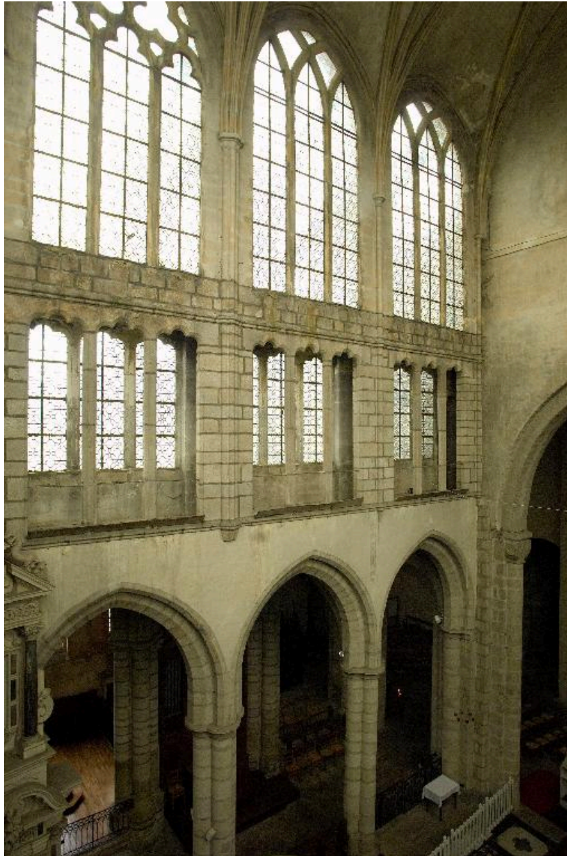
Choeur, intérieur, élévation du côté sud.
