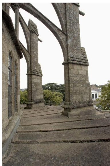
Vue des arcs boutants du chœur Phot. Norbert Lambart IVR53_20073500866NUCA
