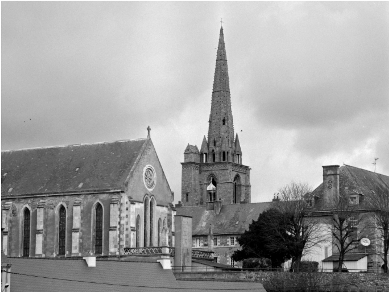
Elévation Sud-Ouest, clocher, flèche : vue générale
