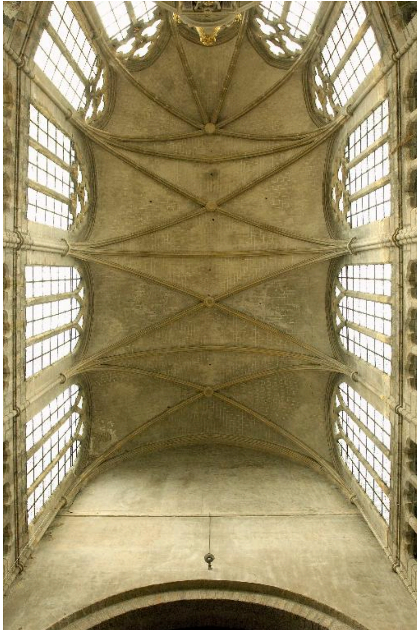
Choeur, vue en contre plongée sur les voûtes
