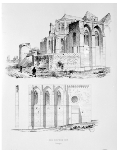
Vue du chevet et des trois chapelles au sud du chœur. Gravure milieu du 19 e siècle. Phot. Auteur inconnu IVR53_19923500016X
