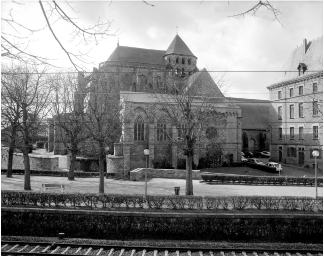
Elévation Nord, bras du transept : vue générale
