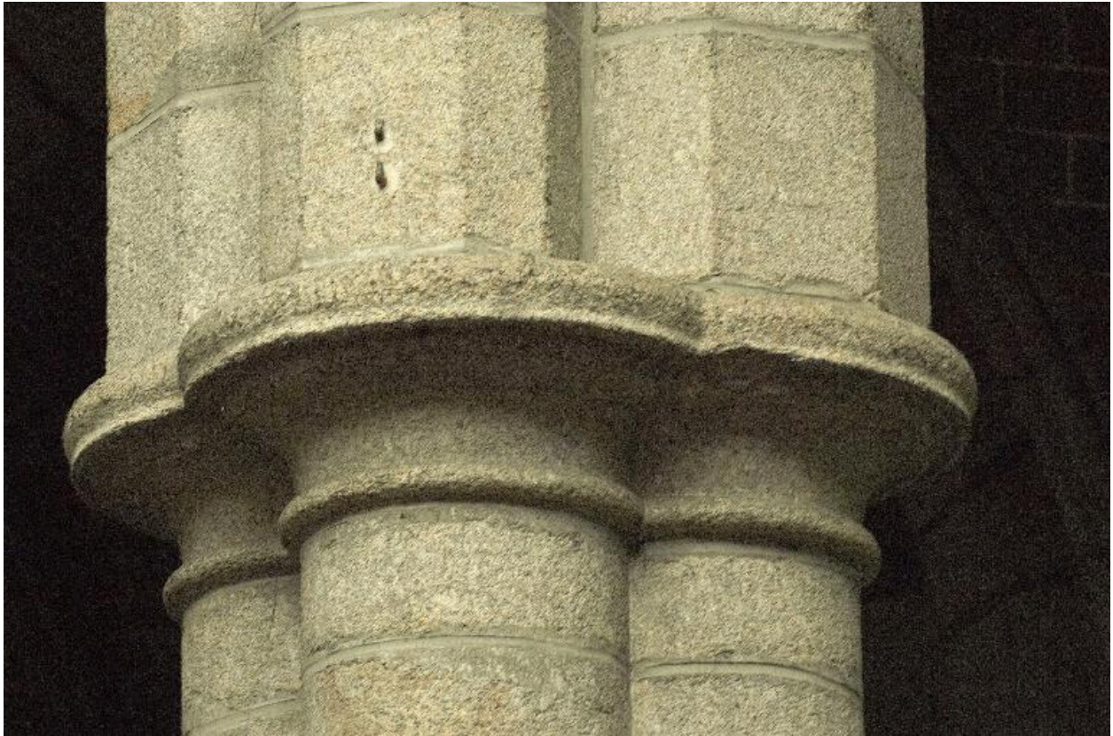
Détail des chapiteaux d'une pile du choeur
