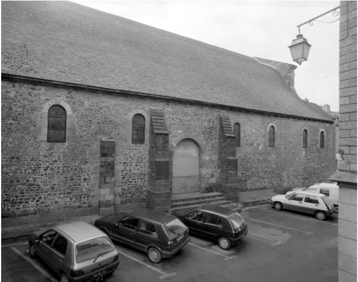
Elévation Nord de la nef
