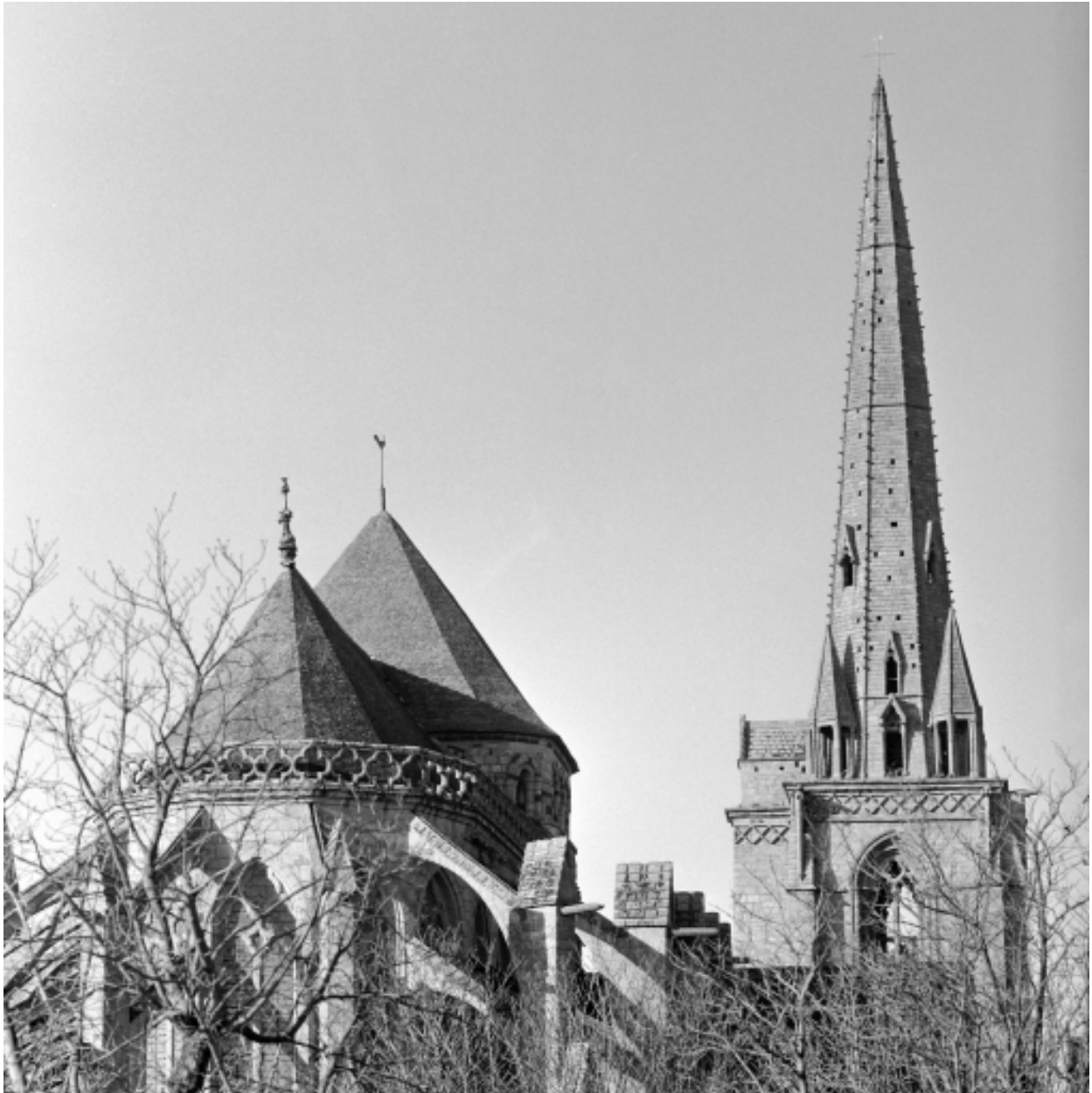
Elévation Est, clocher, flèche : vue générale
