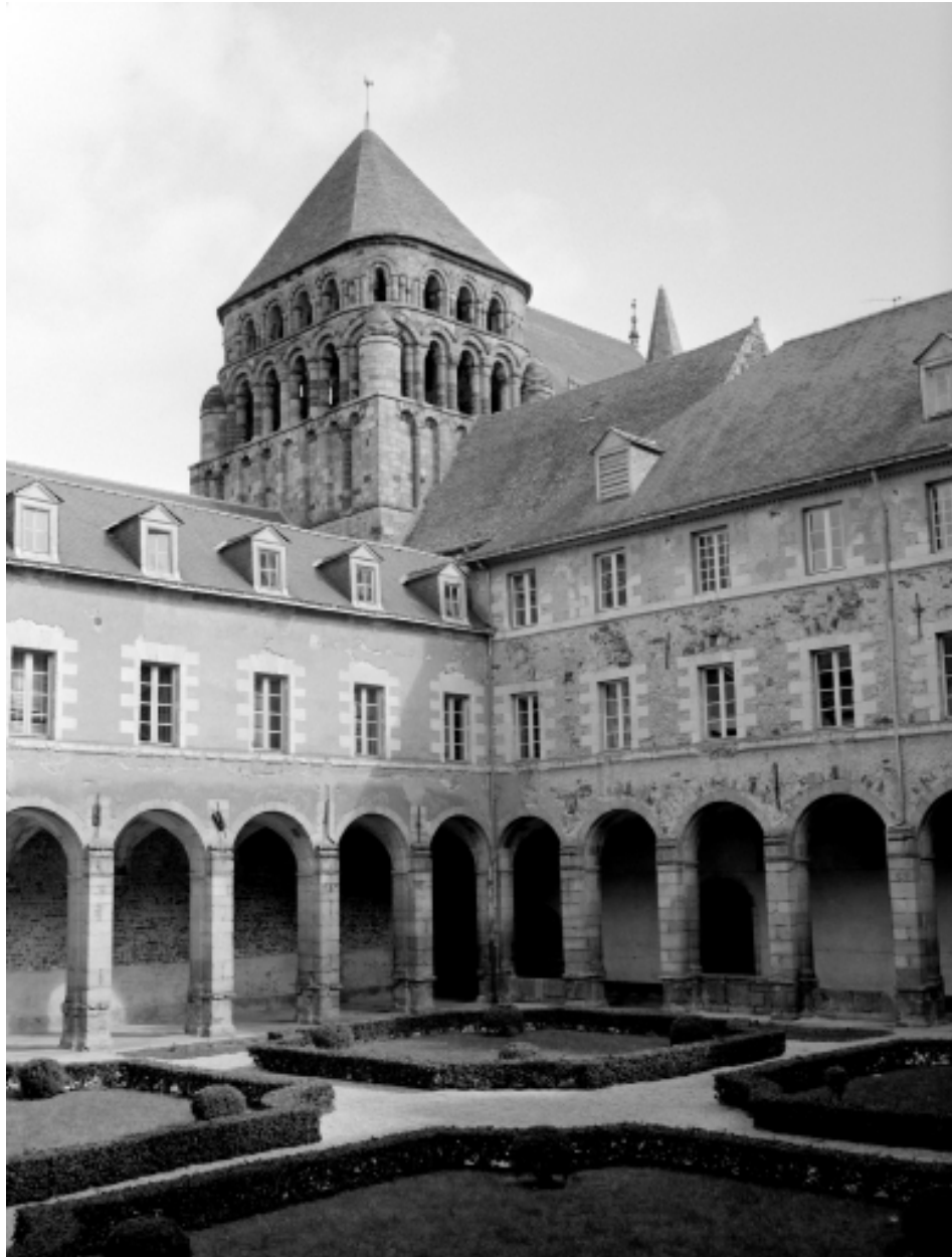
Cloître, angle Nord-Est : vue générale
