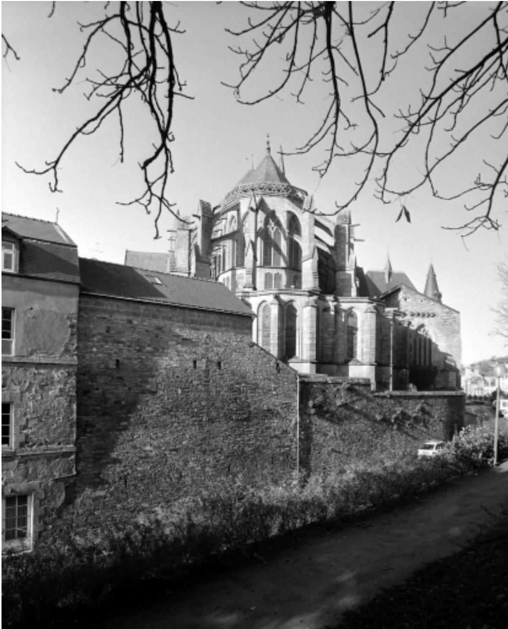
Elévation Est : vue générale
