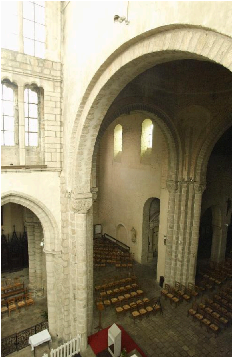
Raccord de l'élévation du choeur et de la croisée
