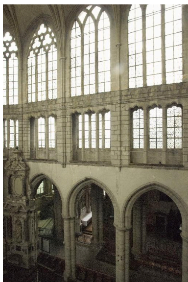
Choeur, intérieur, vue biaise de l'élévation sud. Phot. Norbert Lambart IVR53_20073500860NUCA
