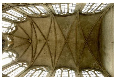
Choeur : vue en contre plongée vers les voûtes Phot. Norbert Lambart IVR53_20073500848NUCA
