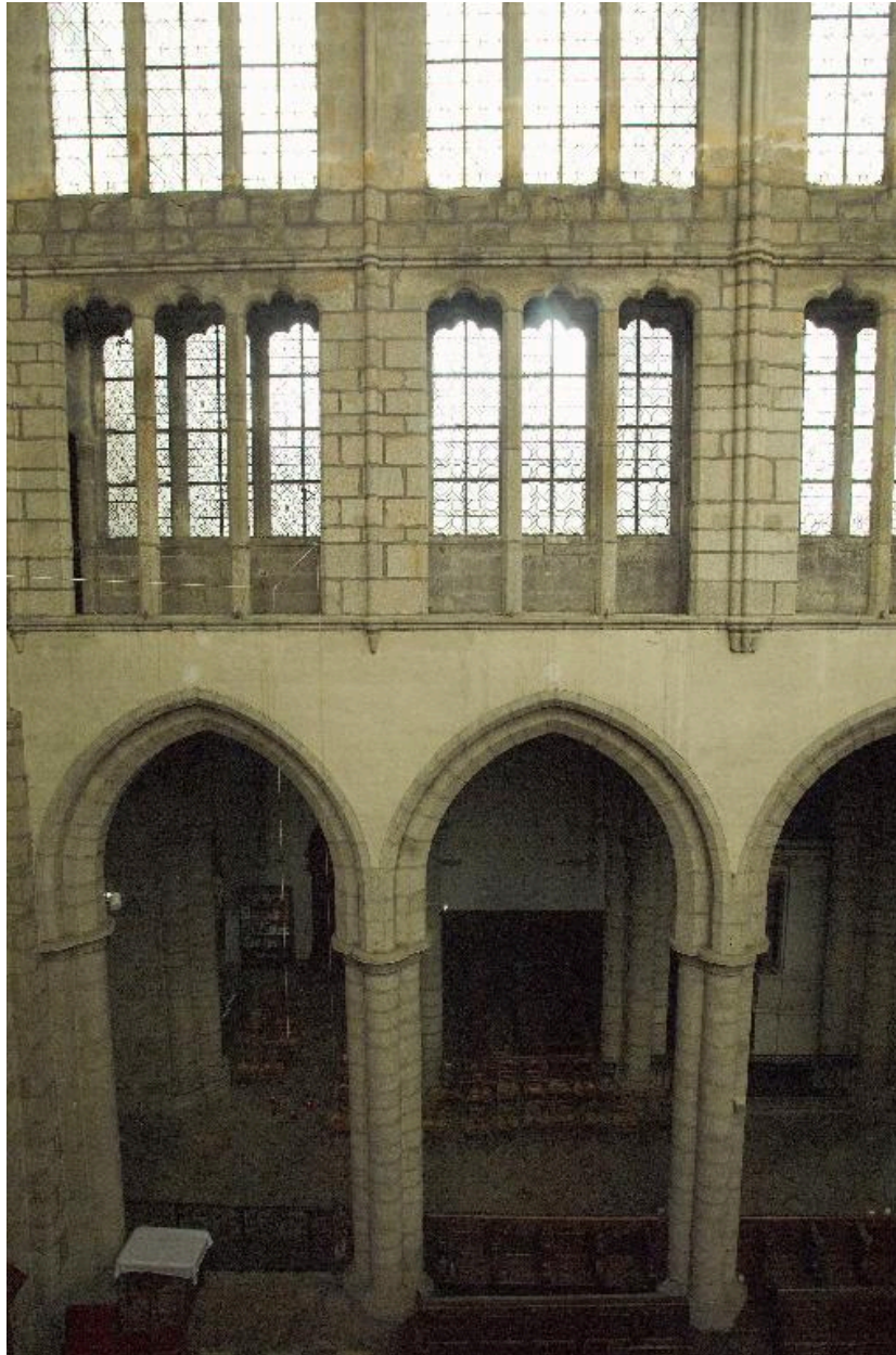
Choeur, intérieur, élévation nord, grandes arcades et triforium
