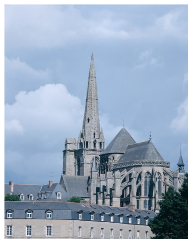
Vue du chevet prise du sud-ouest. Phot. Auteur inconnu IVR53_19953500327XA
