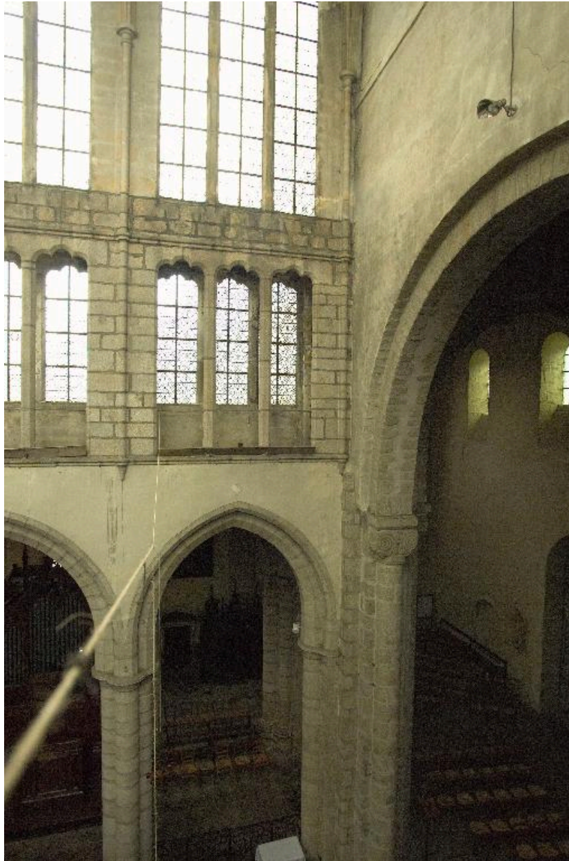
Choeur, vue du raccord avec la croisée
