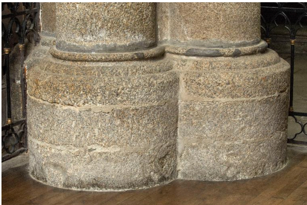
Bases des piles du choeur
