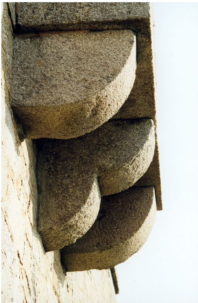
Vue de l'élévation Sud-est : bretèche à trois corbeaux (état en 2000)
