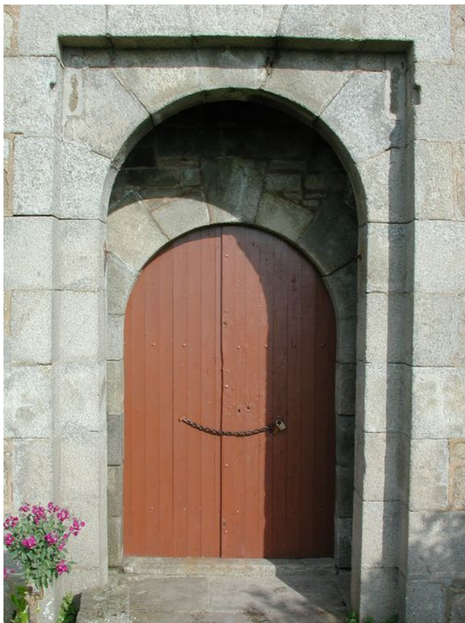
Vue de l'élévation Sud-est : porte d'entrée (état en 2000)
