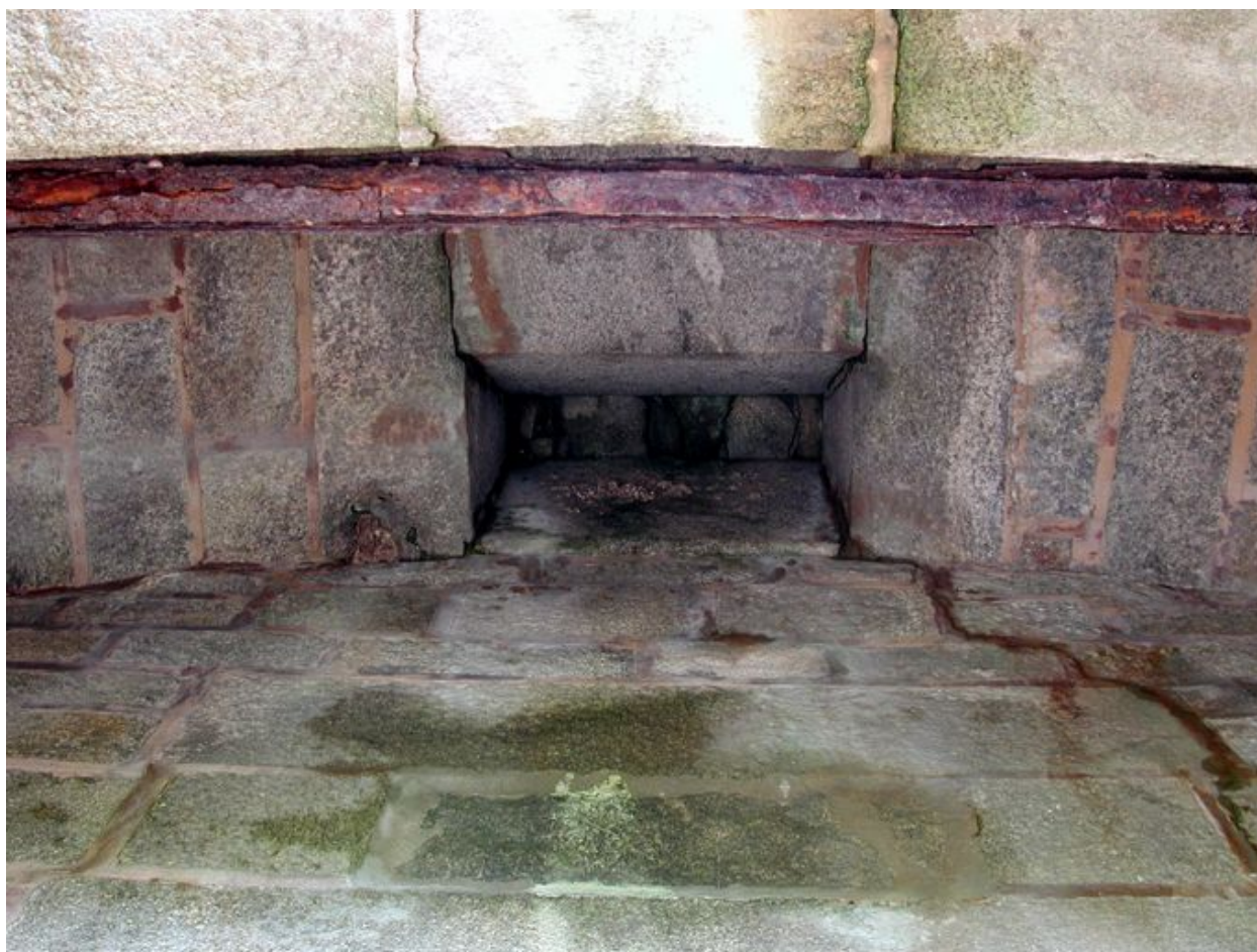
Vue de l'assommoir de la porte d'entrée (état en 2000)
