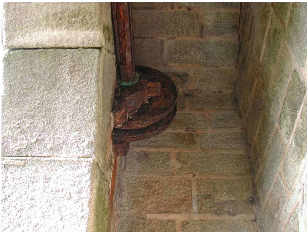
Vue de la poulie gauche du pont levé à chaîne et contre-poids (état en 2000)
