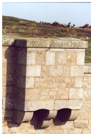
Vue de l'élévation Sud-est : bretèche à trois corbeaux (état en 2000) Phot. Guillaume Lécueillier IVR53_20022901642NUCA
