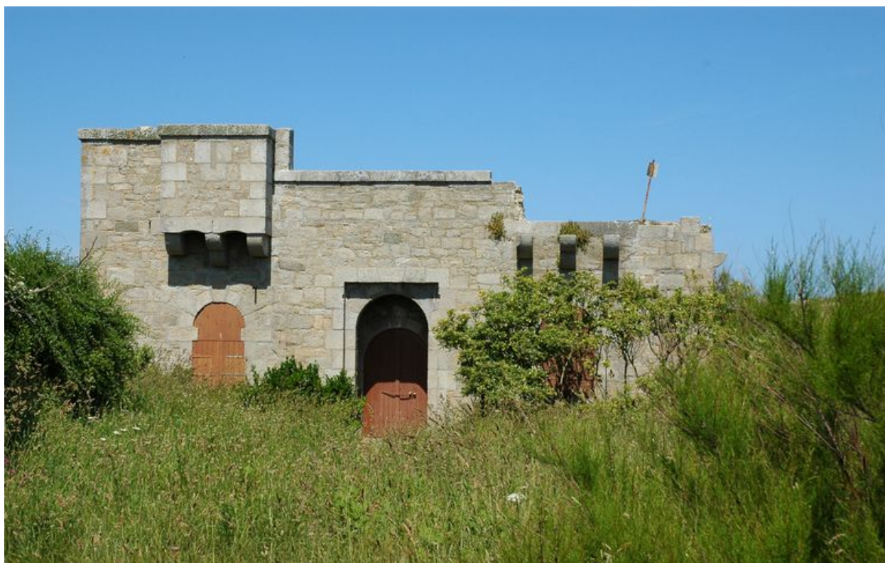
Vue générale : élévation Sud-est (état en 2004)
