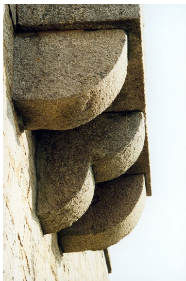
Vue de l'élévation Sud-est : bretèche à trois corbeaux (état en 2000) Phot. Guillaume Lécueillier IVR53_20022901848NUCA
