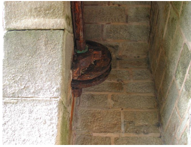
Vue de la poulie gauche du pont levis à chaîne et contre-poids (état en 2000) Phot. Guillaume Lécueillier IVR53_20022901645NUCA
