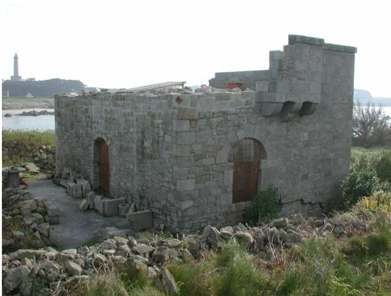
Vue générale (état en 2002). L'édifice est en cours de restauration
