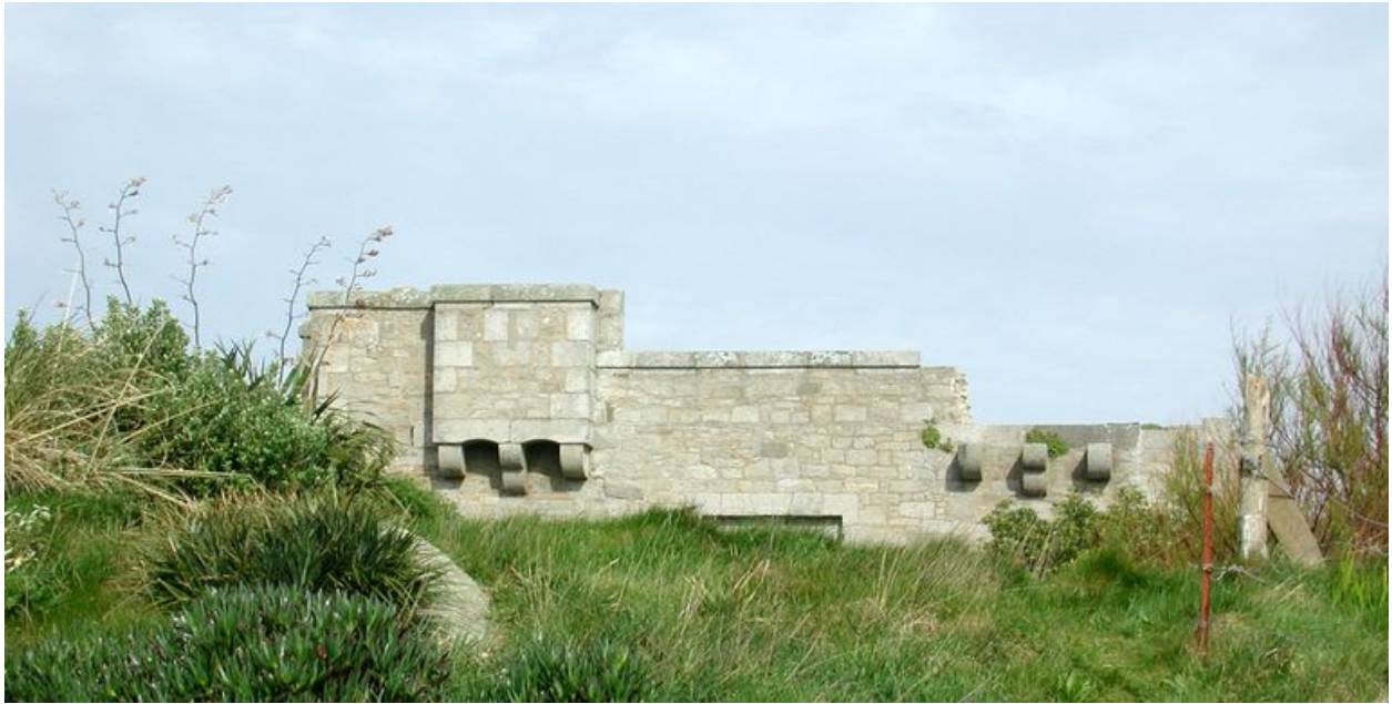
Vue du parapet (état en 2002)
