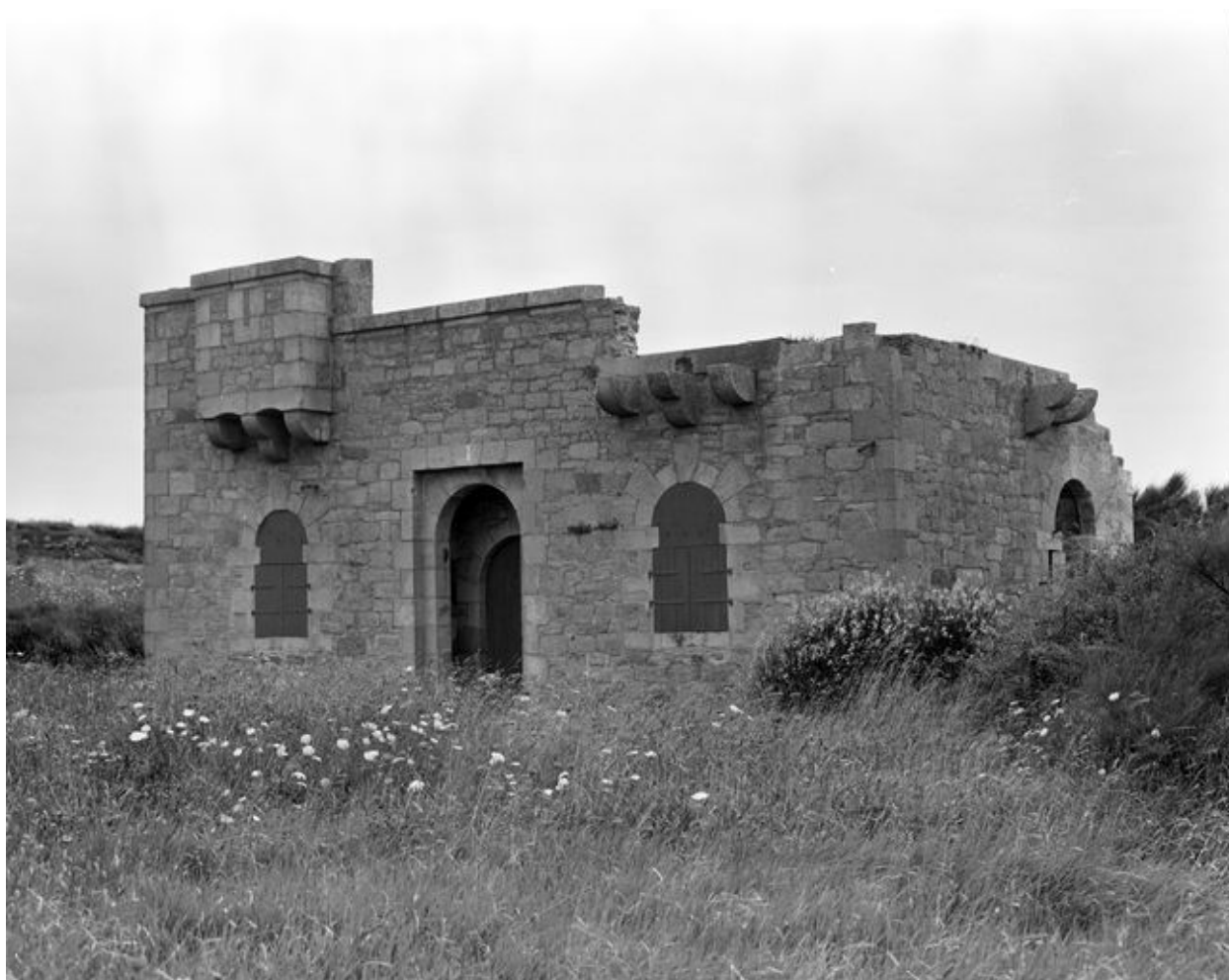
Vue générale : élévation Sud-est (état en 1986)
