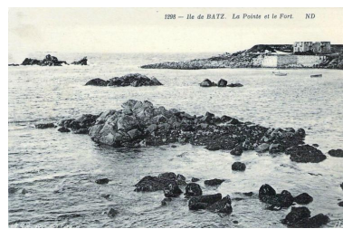
Vue de situation, carte postale (éditions ND ; n° 1298). On distingue, le corps de garde crénelé, la batterie de côte et le mur de soutènement Autr. Anonyme IVR53_20232905379NUCA
