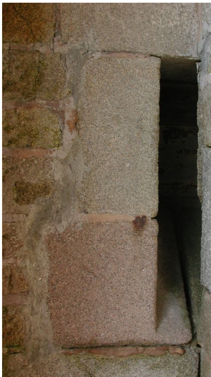
Vue du créneau de fusillade gauche de la porte d'entrée (état en 2000)
