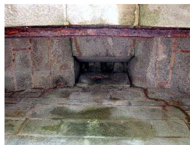
Vue de l'assommoir de la porte d'entrée (état en 2000) Phot. Guillaume Lécueillier IVR53_20022901643NUCA
