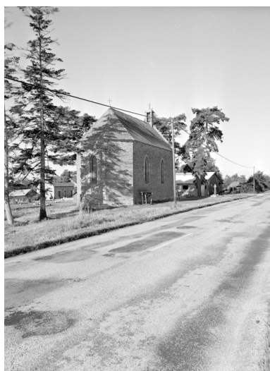
Vue générale nord-est. Phot. François Dagorn IVR53_19775600786X
