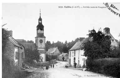
Carte postale ancienne - Elévation ouest : vue générale. IVR53_19933500931X
