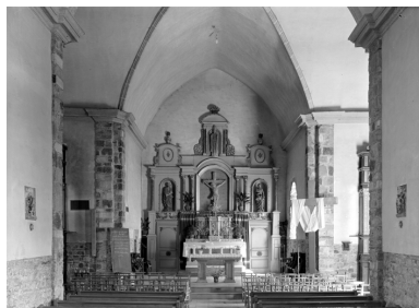
Choeur, vue générale prise de l'ouest. Phot. Guy Artur, Phot. Norbert Lambart IVR53_19843500399V
