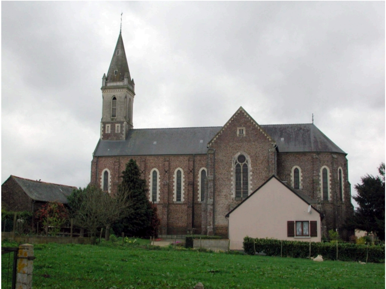
Vue générale est
