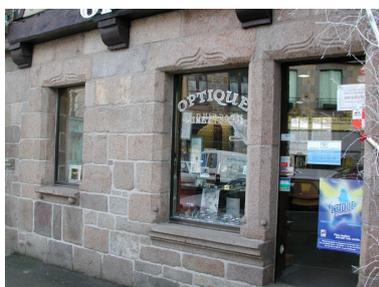
Vue partielle du rez-de-chaussée maçonné en granite avec ses encadrements d'ouvertures sculptés (2002).
