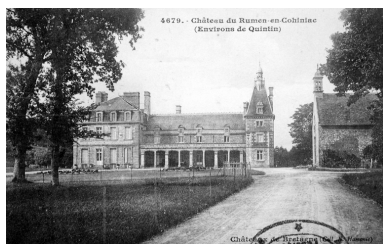
Vue générale Phot. Elise Lauranceau IVR53_20042209044NUCB
