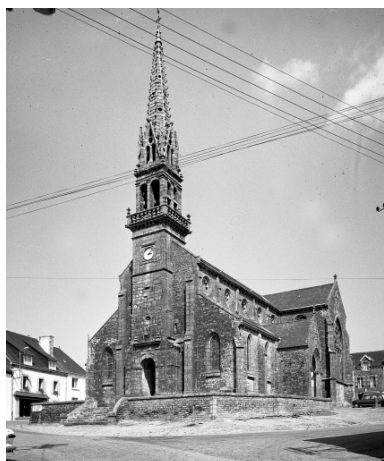
Vue générale sud-ouest Phot. François Dagorn IVR53_19662900529V
