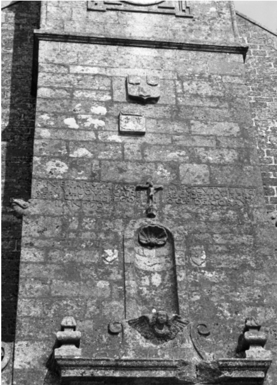
Façade ouest, détail de la niche
