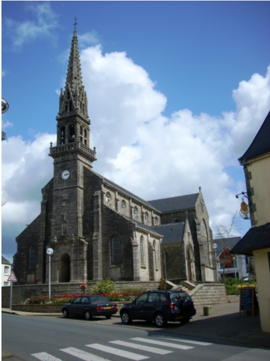
Vue générale sud-ouest, état en 2008.
