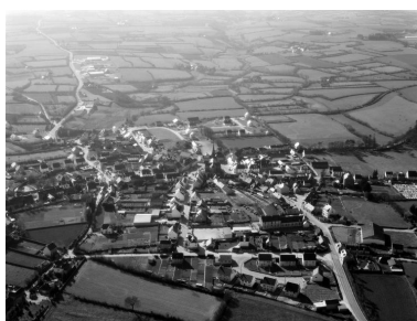
Vue aérienne prise de l'est Phot. G.A.L.A.T.
