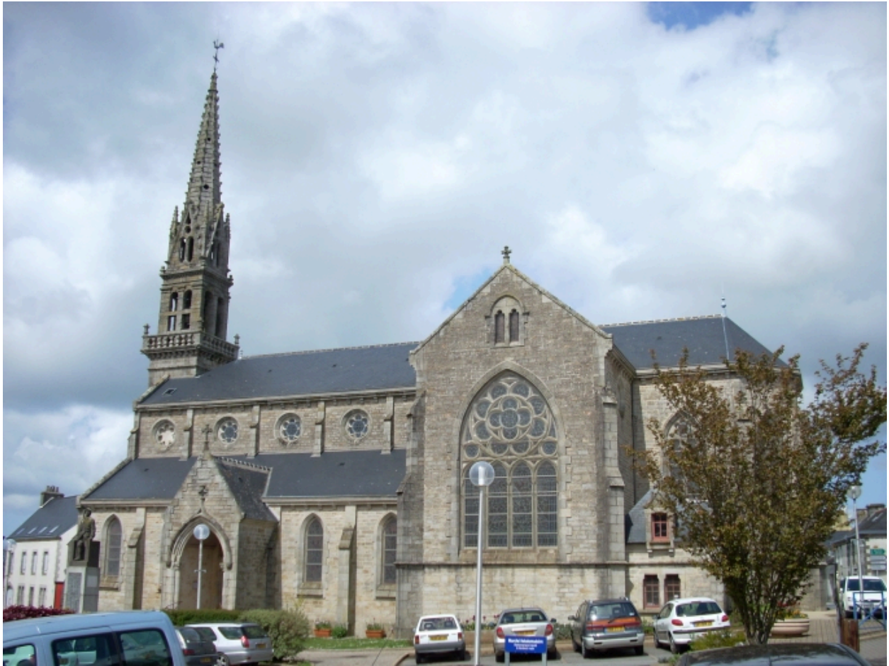
Vue générale sud, état en 2008.
