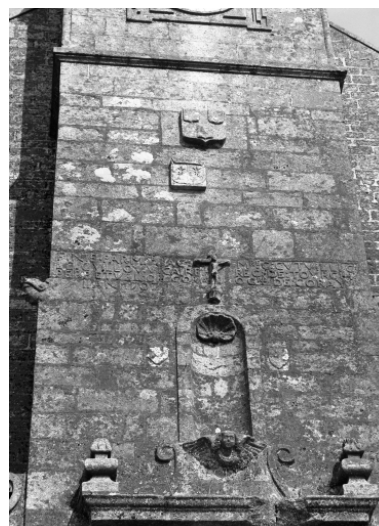
Façade ouest, détail de la niche Phot. François Dagorn IVR53_19662900531V
