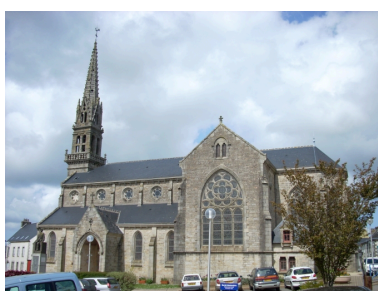
Vue générale sud, état en 2008. Phot. Gwénaél Fauchille IVR53_20082905534NUCA
