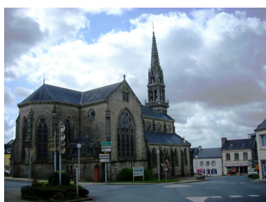
Vue générale nord-est, état en 2008. Phot. Gwénaél Fauchille IVR53_20082905533NUCA
