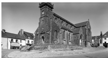
Vue générale sud-ouest Phot. François Dagorn IVR53_19662900530V
