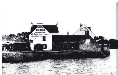
Café-hôtel de la Terrasse, Grand Hotel de Morgat, entrepôt de coquilles et cale du Fret au début du 20e siècle (?) Repro. Florence Despretz, Autr. Marie-Françoise Bonneau IVR53_20062908522NUC
