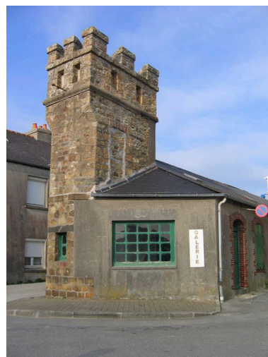
Tour du fret Phot. Françoise Péron IVR53_20062908598NUCA
