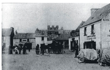
Front portuaire du Fret en 1904 ou 1906 Repro. Florence Despretz IVR53_20072908848NUC
