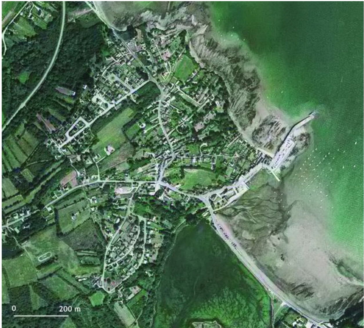
Vue générale du hameau du Fret
