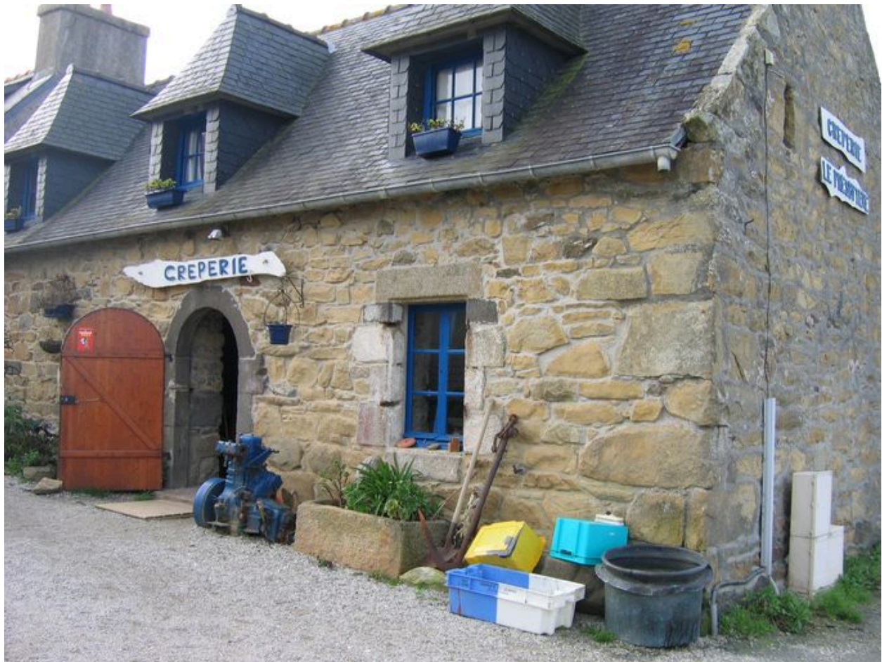
Maison ancienne du hameau du Fret (sensiblement remaniée)
