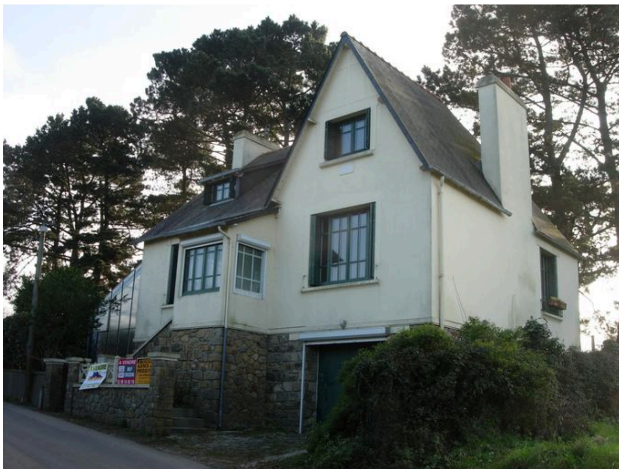
Maison de villégiature du hameau du Fret rue Tertu
