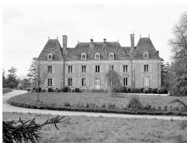
Vue générale est Phot. Jean-Pierre Ducouret IVR53_19835600457X
