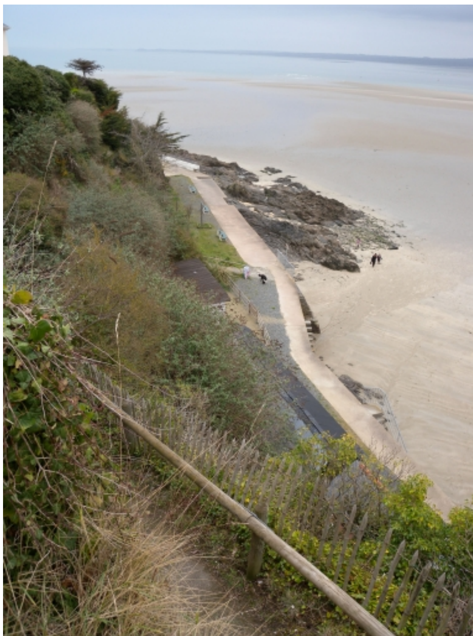
Vue de la digue promenade depuis le sentier ou chemin rural n° 2
