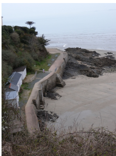
Vue du front de mer de l'anse des Moines, au niveau de la pointe
