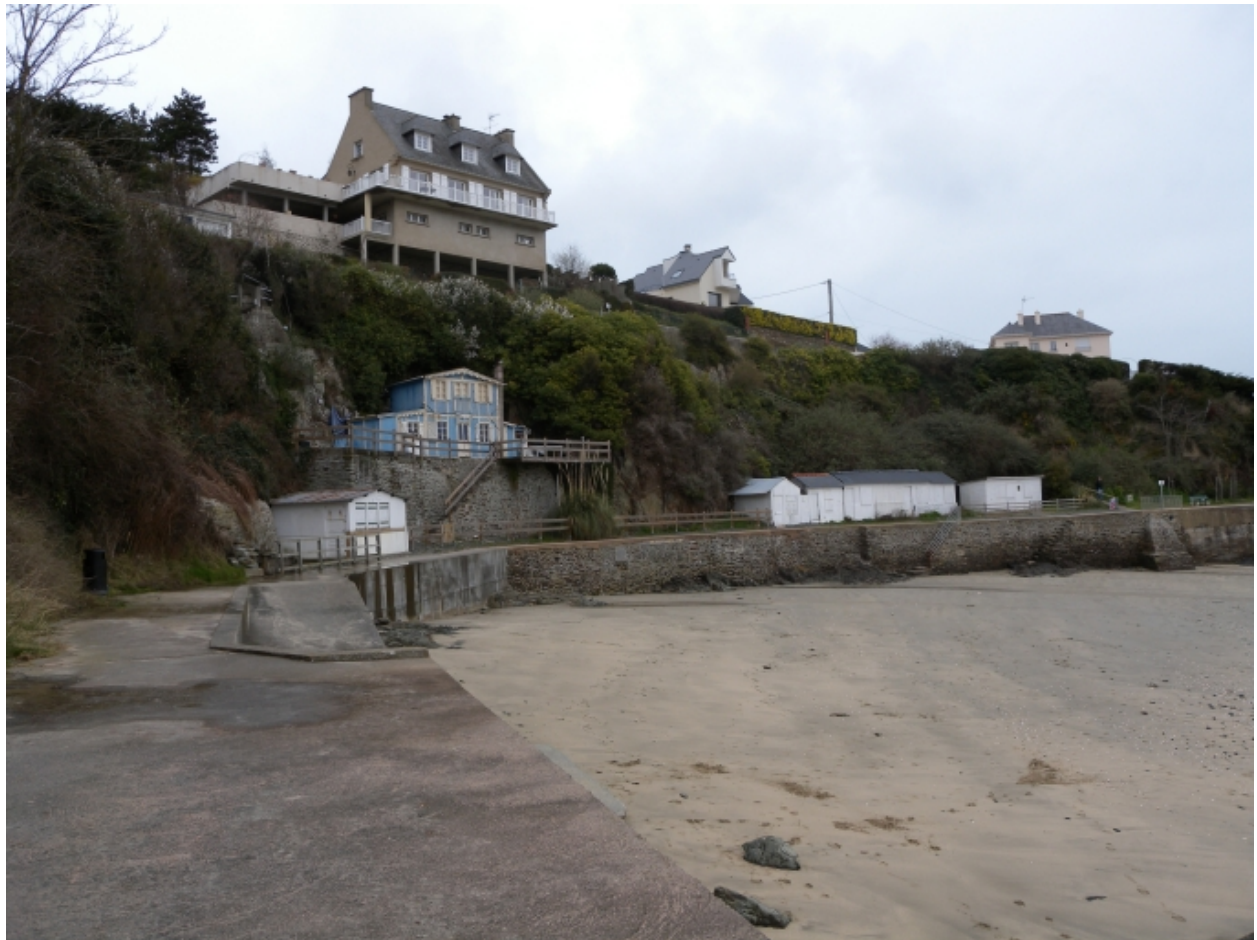
Vue des cabines de bains sur la digue et des villas en surplomb, sur la falaise
