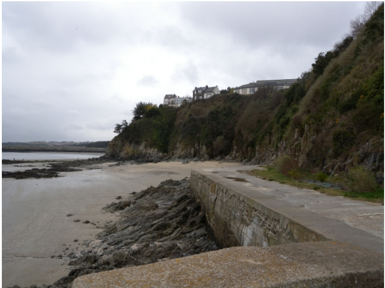
Vue de l'extrémité de la digue en face de la falaise de la Pointe à l'Aigle et de la salle 'Bagatelle'
