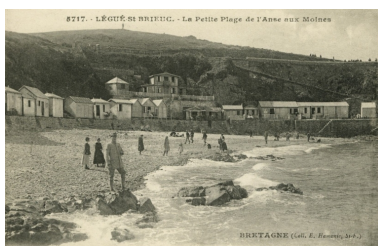
L'Anse aux Moines en 1924 : remarquer les cabines de bains sous la falaise (carte postale, AD 22) Phot. Emile Hamonic, Autr. Emile Hamonic IVR53_20082213031NUCB
