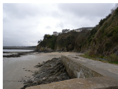
Vue de l'extrémité de la digue en face de la falaise de la Pointe à l'Aigle et de la salle 'Bagatelle' Phot. Guy Prigent IVR53_20082213185NUCA
