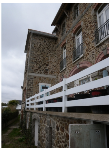
Vue d'un bâti littoral, construit en briques rouges, daté de 1907, sur le sentier de la falaise Phot. Guy Prigent IVR53_20082213190NUCA
