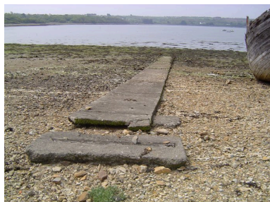
Vue générale de la cale de lancement du chantier naval Tertu Phot. Clotilde Buhot IVR53_20062908530NUCA
