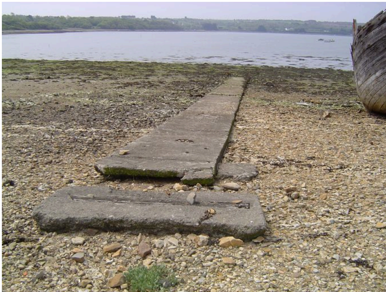
Vue générale de la cale de lancement du chantier naval Tertu
