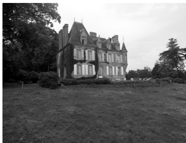
Logis, élévation sud à l'état de vestiges Phot. Bernard Bègne IVR53_19975600723X
