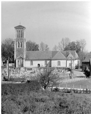
Vue générale sud Phot. Guy Artur, Phot. Norbert Lambart IVR53_19943500817X
