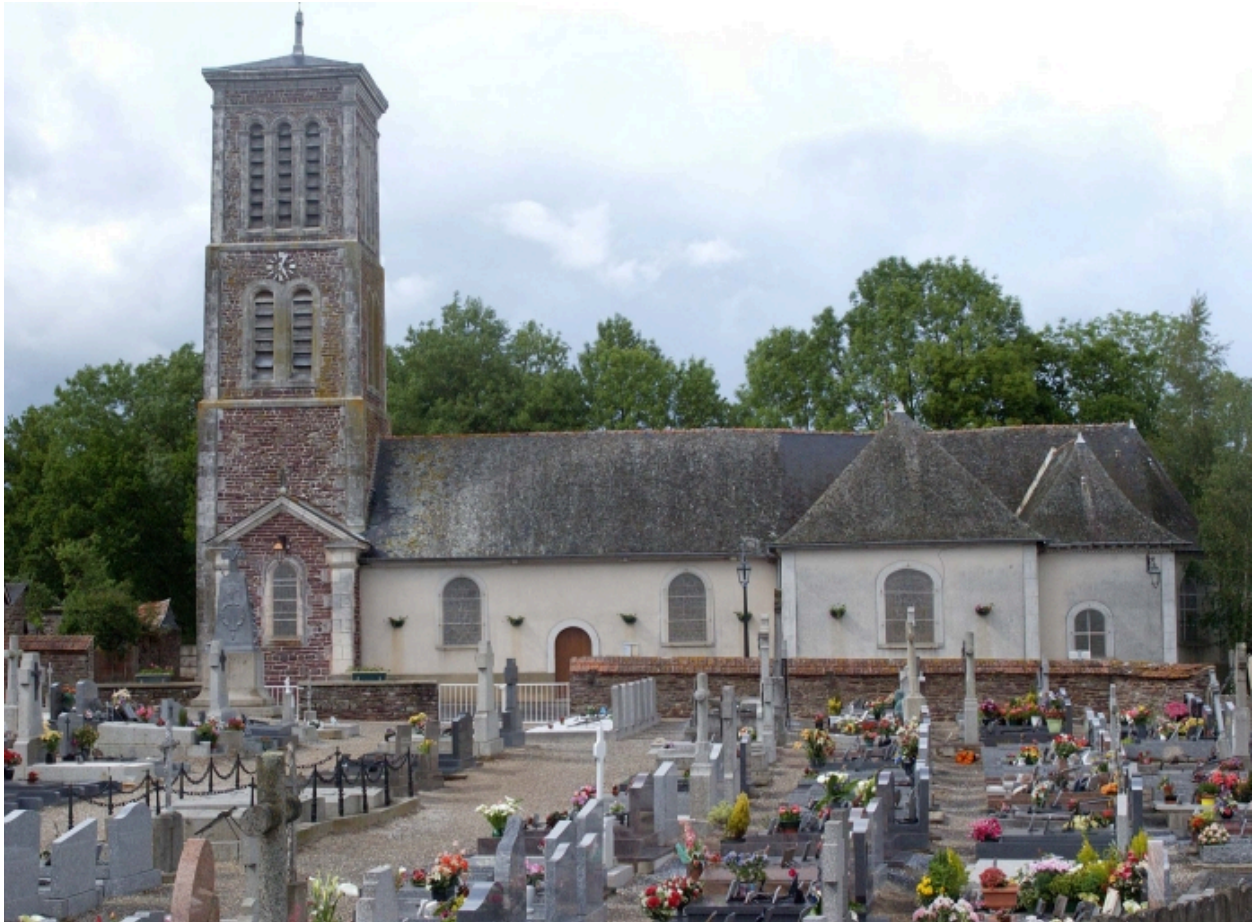
Vue générale sud depuis le cimetière
