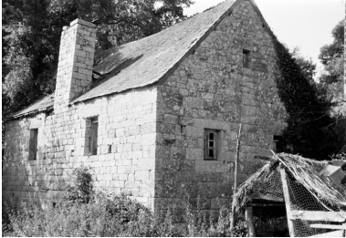
Vue de situation prise du sud Phot. Brulon IVR53_19662200557Z
