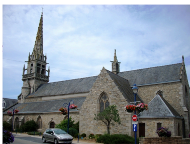
Santec, église paroissiale Saint-Adrien : vue générale sud-est Phot. Gwénaél Fauchille IVR53_20082906549NUCA
