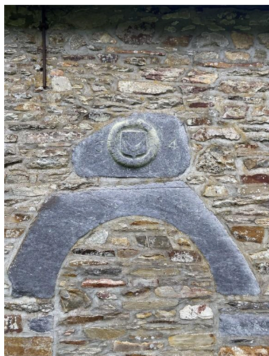
Porte murée, vue ouest Phot. Baptiste Oligo IVR53_20255611131NUCA
