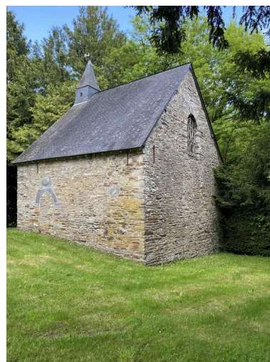
Vue sud-ouest Phot. Baptiste Oligo IVR53_20255611135NUCA
