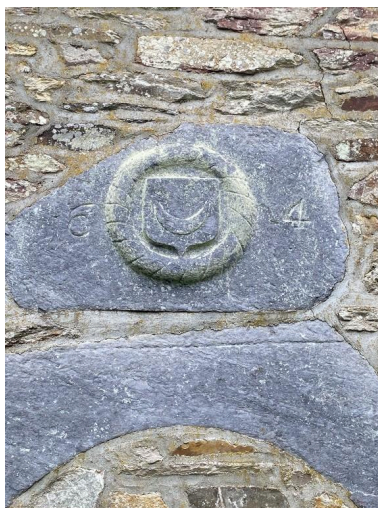
Linteau porte murée, vue ouest Phot. Baptiste Oligo IVR53_20255611132NUCA
