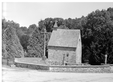
Chapelle : élévation sud (état en 1983) Phot. Jean-Pierre Ducouret IVR53_19835600268X
