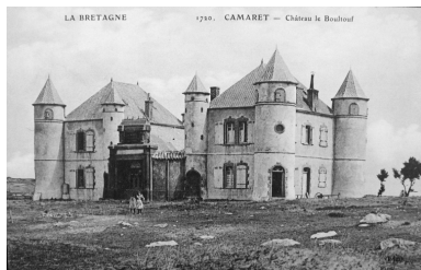
Vue générale Phot. Elise Lauranceau IVR53_20042905527NUCB
