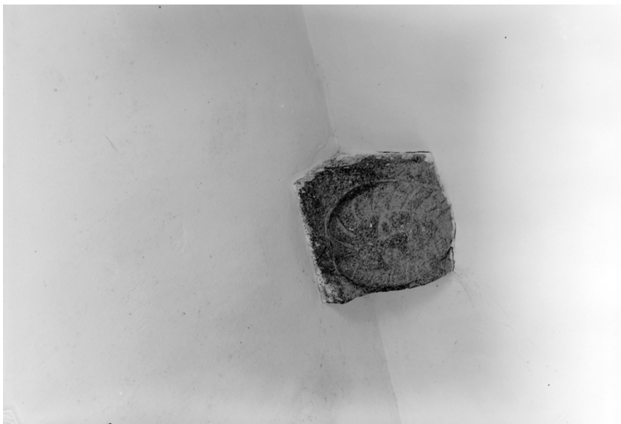
Rez-de-chaussée de l'aile nord, mur est de la cuisine, détail : corbeau sculpté
