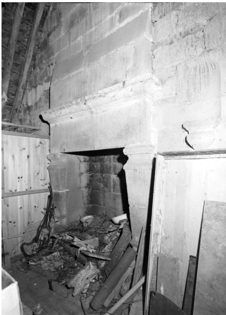
Combles nord du corps central : cheminée
