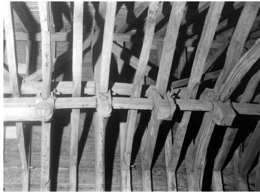
Combles nord du corps central, détail : abouts de poinçons, partie nord Phot. François Dagorn IVR53_19682200570V
