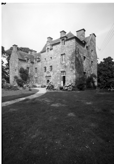
Vue générale des faces ouest et nord Phot. François Dagorn IVR53_19682200543V
