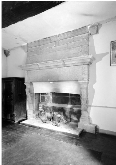
1er étage, pièce de la partie nord du corps central, cheminée Phot. François Dagorn IVR53_19682200643V
