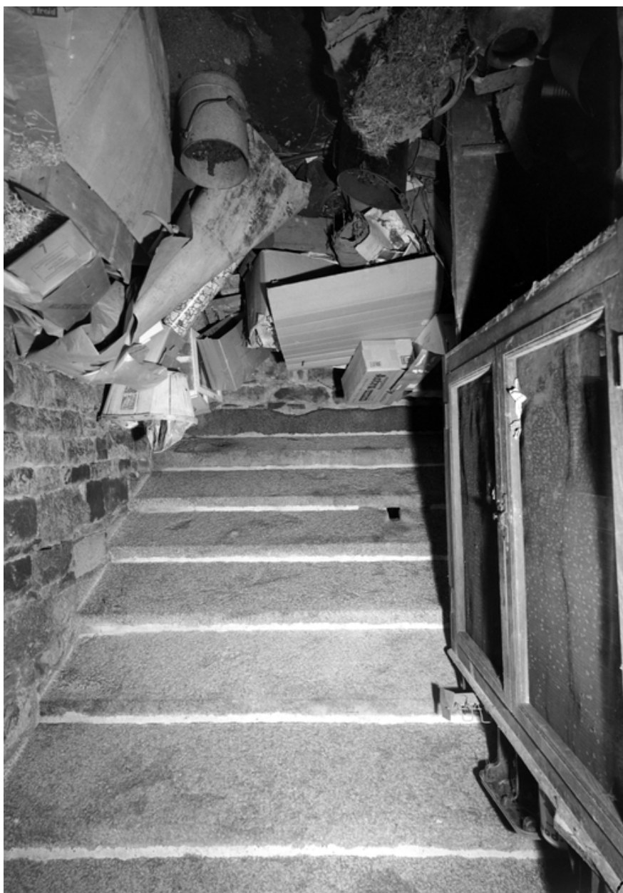
Cave sous l'escalier : vue du revers des marches
