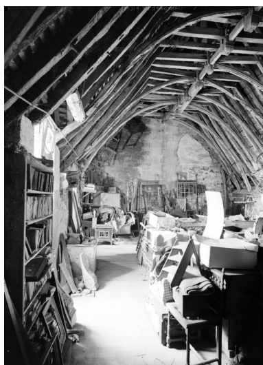
Combles nord du corps central : charpente et mur ouest Phot. François Dagorn IVR53_19682200566V
