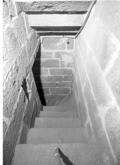
Vue générale de l'escalier secondaire Phot. François Dagorn IVR53_19682200650V
