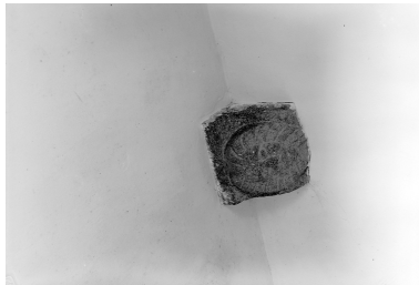
Rez-de-chaussée de l'aile nord, mur est de la cuisine, détail : corbeau sculpté Phot. François Dagorn IVR53_19682200555V
