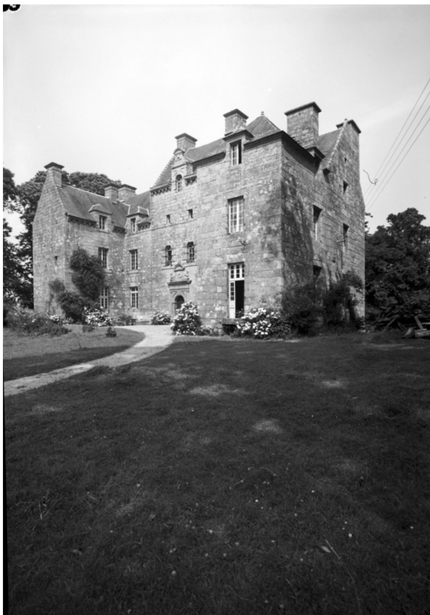
Vue générale des faces ouest et nord
