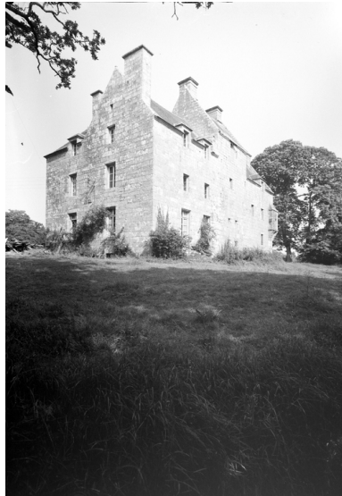
Vue générale des faces sud et est Phot. François Dagorn IVR53_19682200527V
