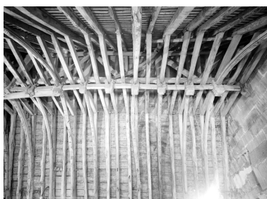
Combles nord du corps central : vue générale de la charpente Phot. François Dagorn IVR53_19682200567V
