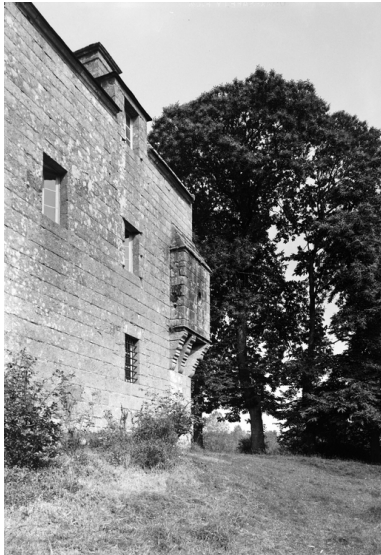
Face est : vu sud-est de l'échauguette Phot. François Dagorn IVR53_19682200545V
