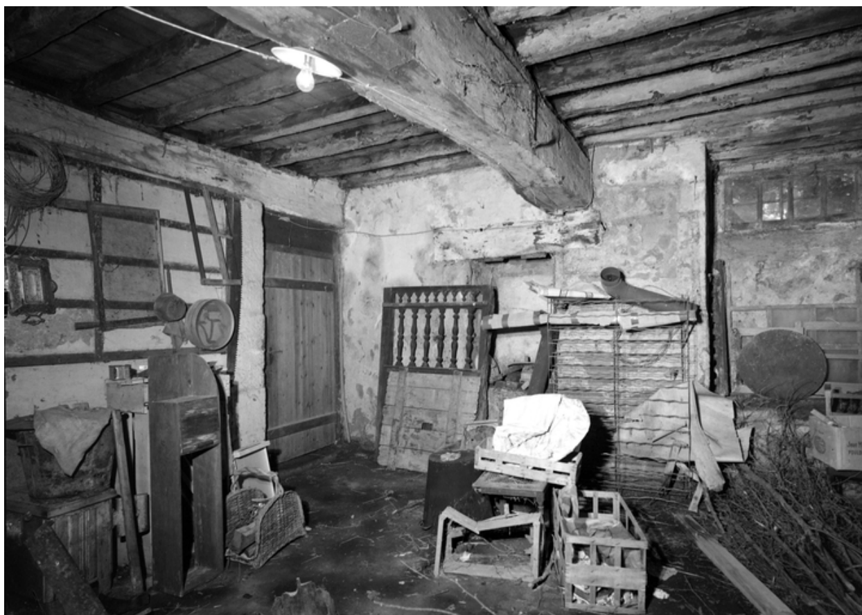
Cuisine en sous-sol à l'extrémité sud - angle nord-est
