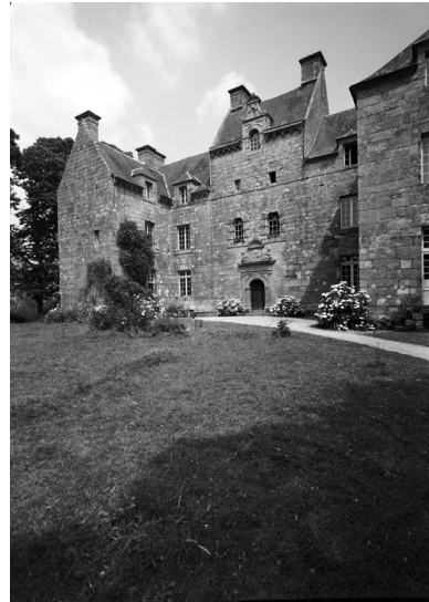
Vue de la face ouest et de l'aile sud Phot. François Dagorn IVR53_19682200520V
