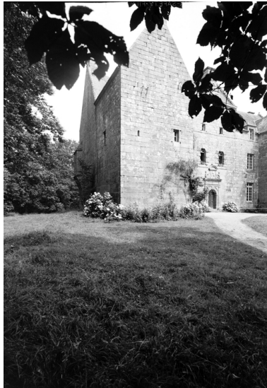
Aile nord : angle nord-ouest Phot. François Dagorn IVR53_19682200546V
