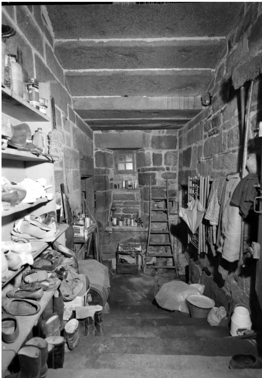
Cave : vue du revers de la volée sud et de la porte du vestibule
