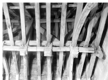
Combles nord du corps central, détail : abouts de poinçons, partie sud Phot. François Dagorn IVR53_19682200568V
