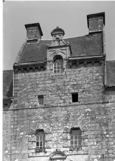
Face ouest : vue du 3ème niveau et de la lucarne passante axiale Phot. François Dagorn IVR53_19682200547V
