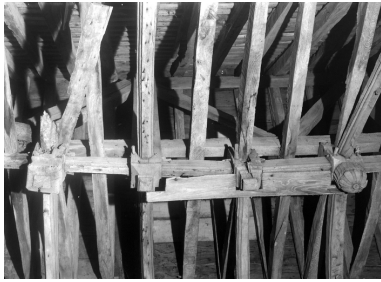
Combles nord du corps central, détail : abouts de poinçons, partie médiane Phot. François Dagorn IVR53_19682200569V
