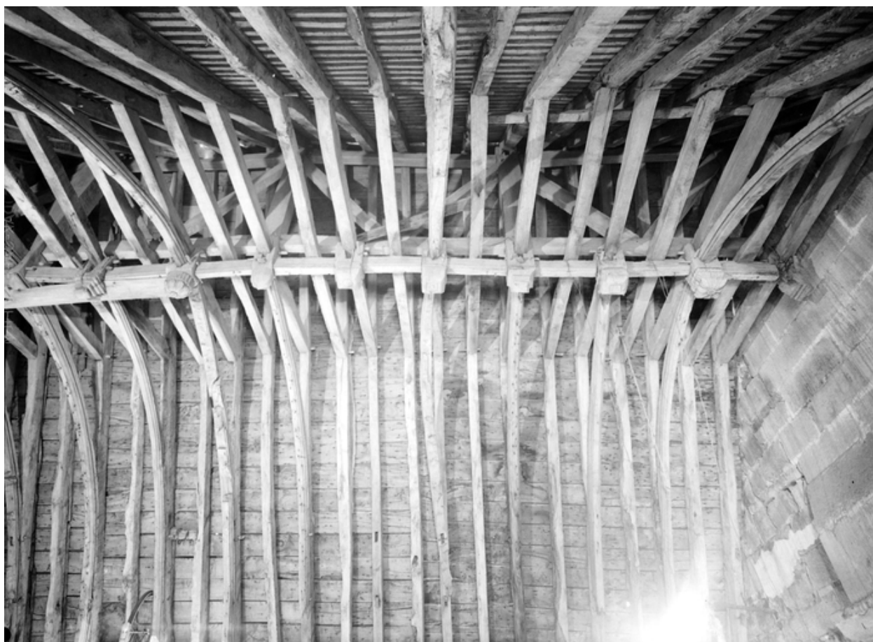
Combles nord du corps central : vue générale de la charpente
