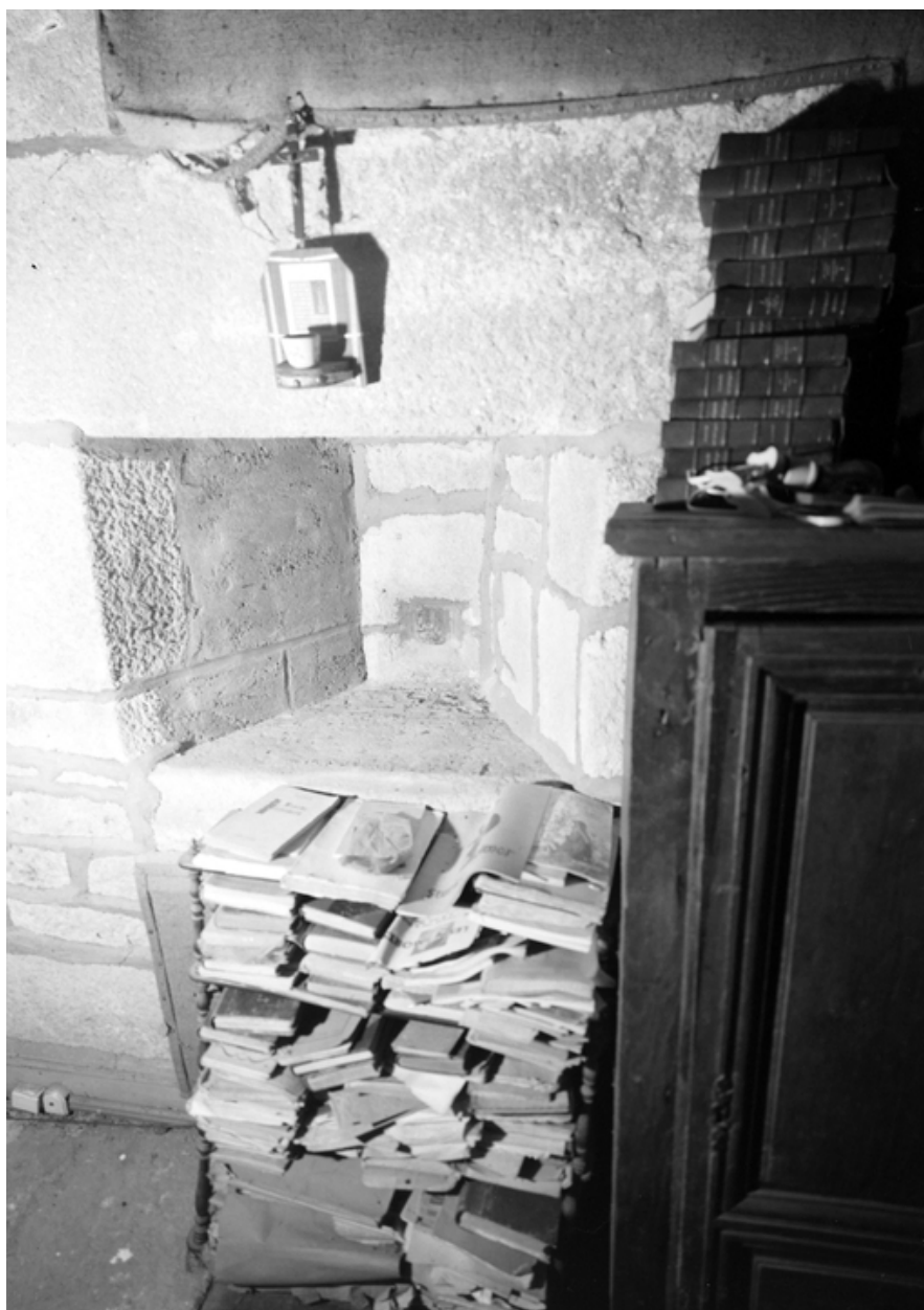
Aile nord, 1er étage : détail de la petite ouverture à gauche de la fenêtre du mur nord
