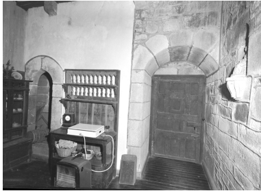
1er étage : partie nord du corps central, mur sud, vestibule Phot. François Dagorn IVR53_19682200648V
