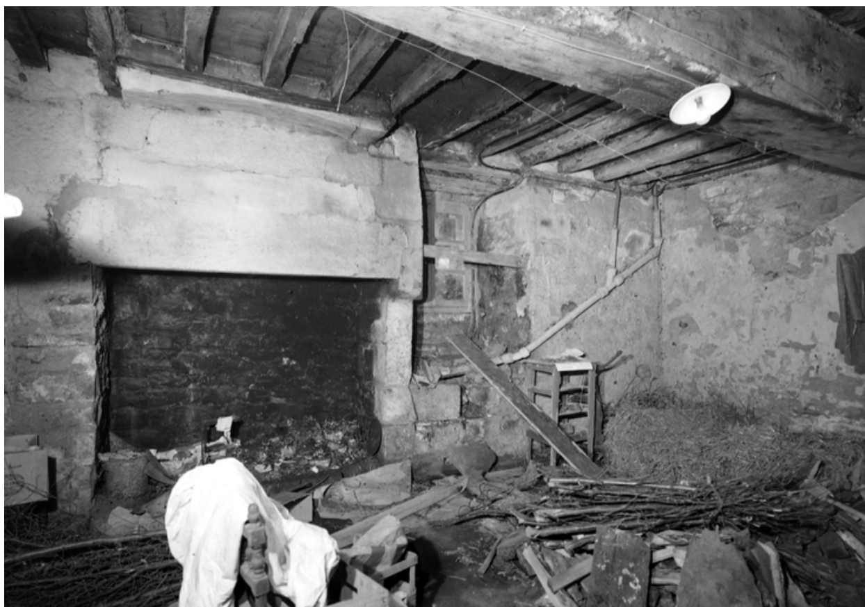
Cuisine en sous-sol à l'extrémité sud - mur sud
