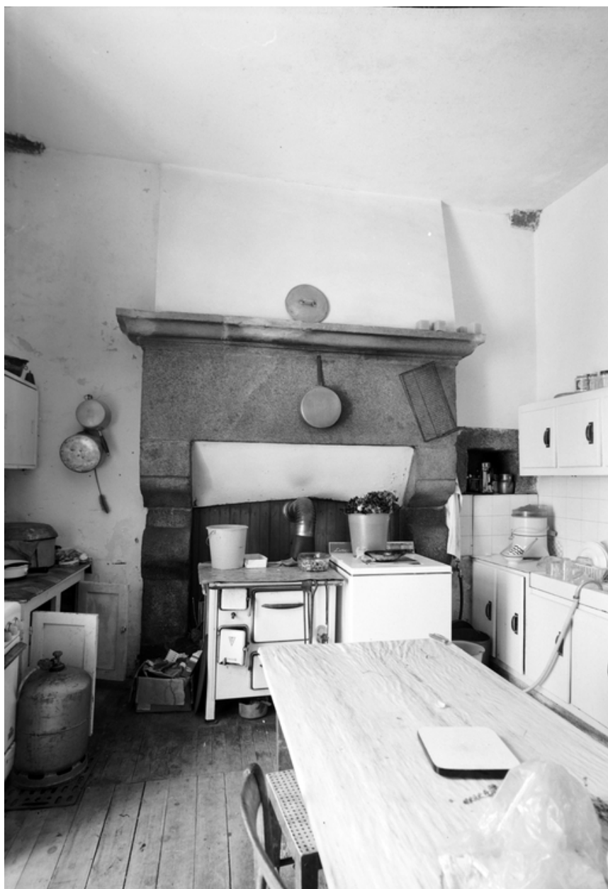
Rez-de-chaussée de l'aile nord : cheminée de la cuisine, mur ouest
