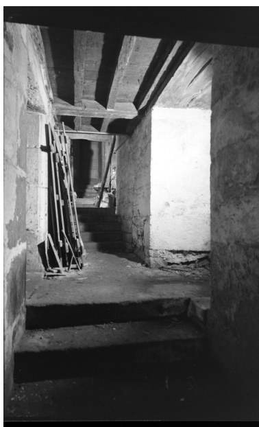
Escalier de communication entre la cave et la cuisine de l'aile sud Phot. François Dagorn IVR53_19682200619V
