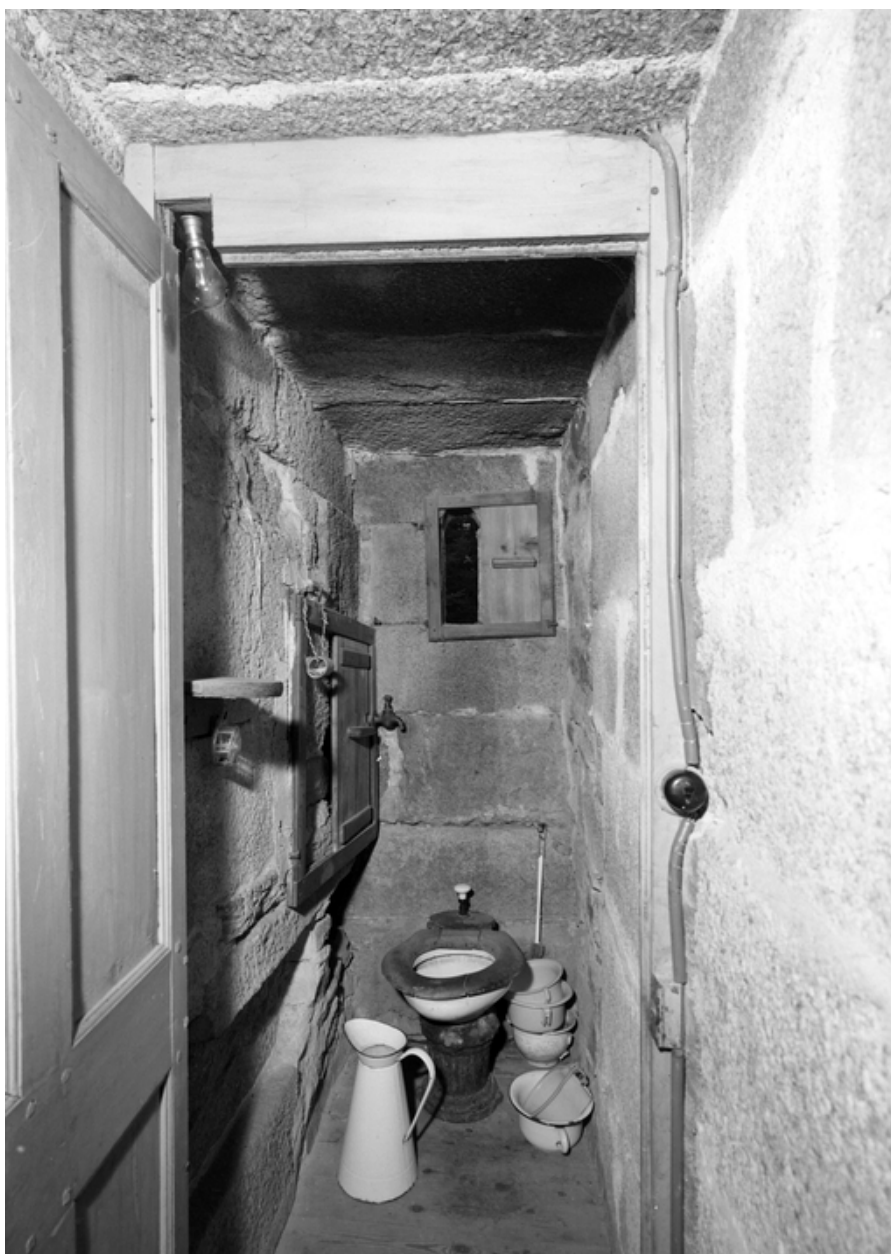
1er étage, partie sud du corps central, latrines
