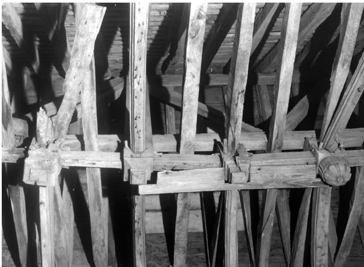
Combles nord du corps central, détail : abouts de poinçons, partie médiane
