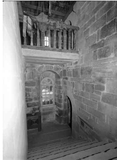
Cage d'escalier : paliers des 1er et 2ème étages Phot. François Dagorn IVR53_19682200562V
