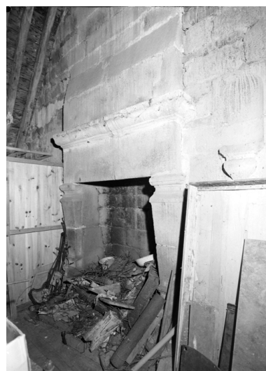
Combles nord du corps central : cheminée Phot. François Dagorn IVR53_19682200565V
