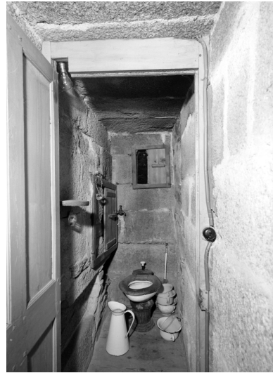
1er étage, partie sud du corps central, latrines Phot. François Dagorn IVR53_19682200641V
