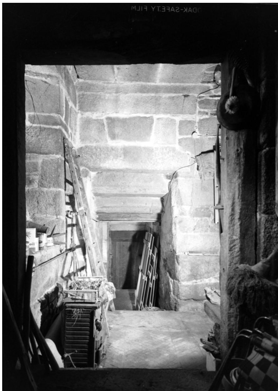
Enfilade d'escaliers d'accès à la cave
