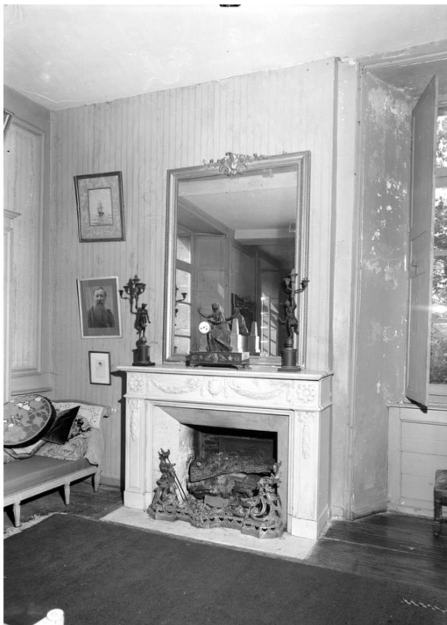
Aile sud, rez-de-chaussée : cheminée du mur sud
