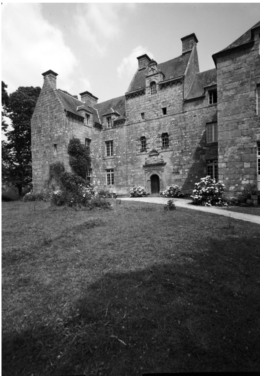
Vue de la face ouest et de l'aile sud
