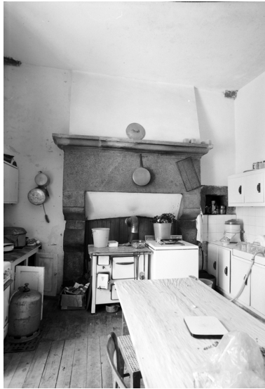
Rez-de-chaussée de l'aile nord : cheminée de la cuisine, mur ouest Phot. François Dagorn IVR53_19682200552V
