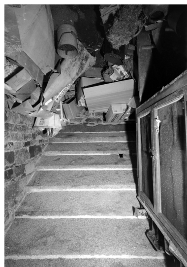
Cave sous l'escalier : vue du revers des marches Phot. François Dagorn IVR53_19682200620V
