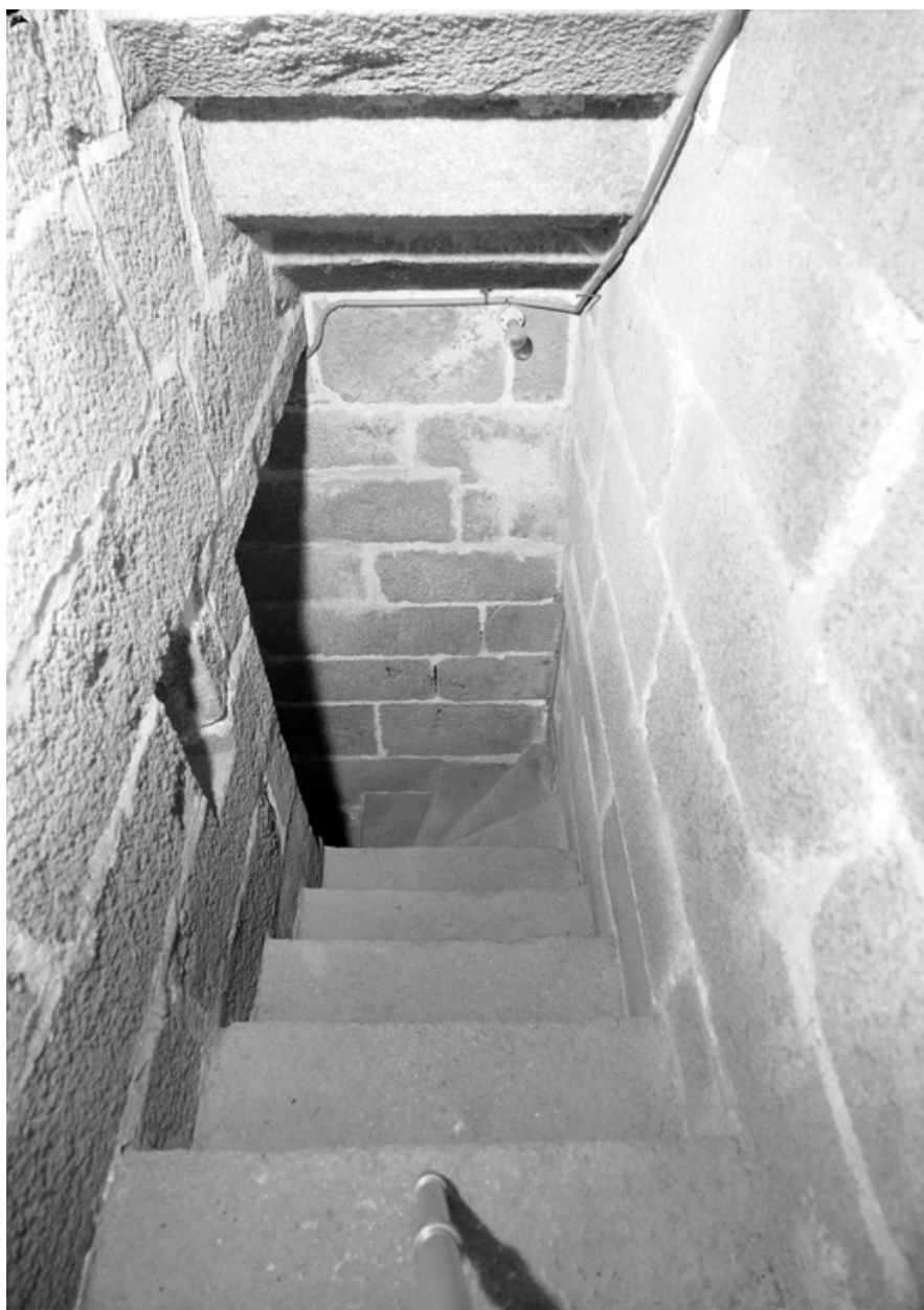
Vue générale de l'escalier secondaire
