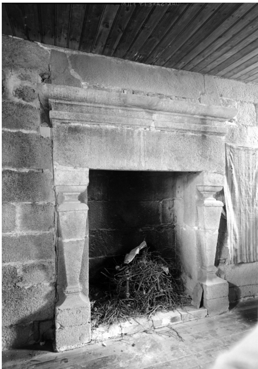
Pièce au-dessus de l'escalier principal : cheminée
