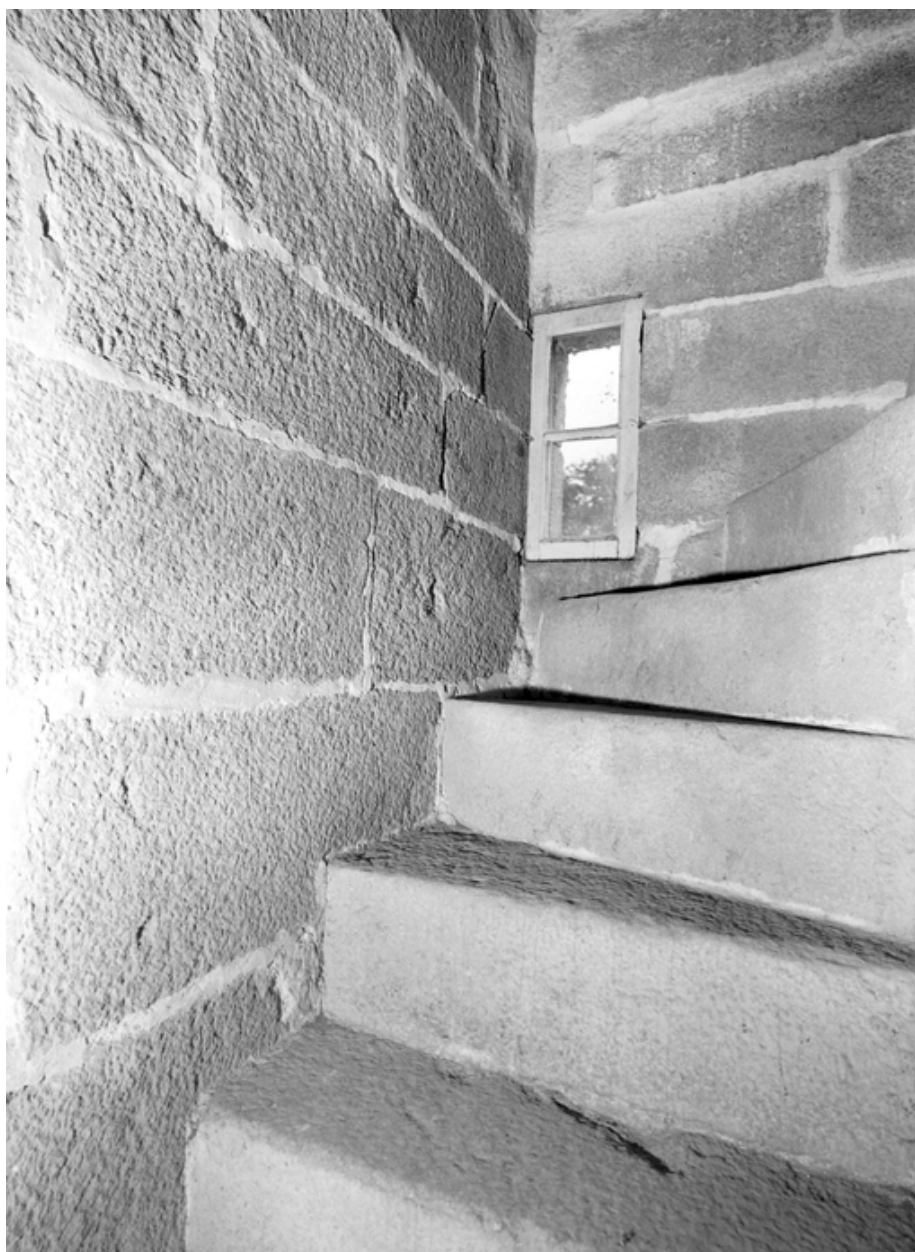
Vue des marches de départ de l'escalier secondaire
