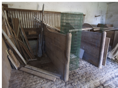
Communs, vue intérieure, stalles Phot. Bernard Bègne IVR53_20115600349NUCA
