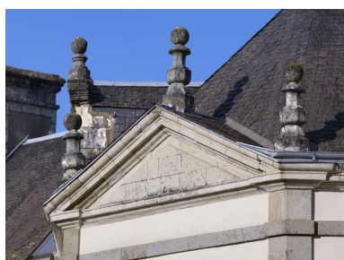
Elévation sud, avant-corps polygonale, détail fronton et amortissement en balustres Phot. Bernard Bègne IVR53_20115600335NUCA
