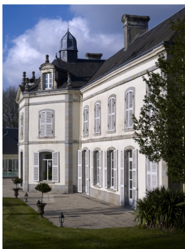
Elévation sud, détail partie droite et pan sud de l'avant-corps médian Phot. Bernard Bègne IVR53_20115600329NUCA
