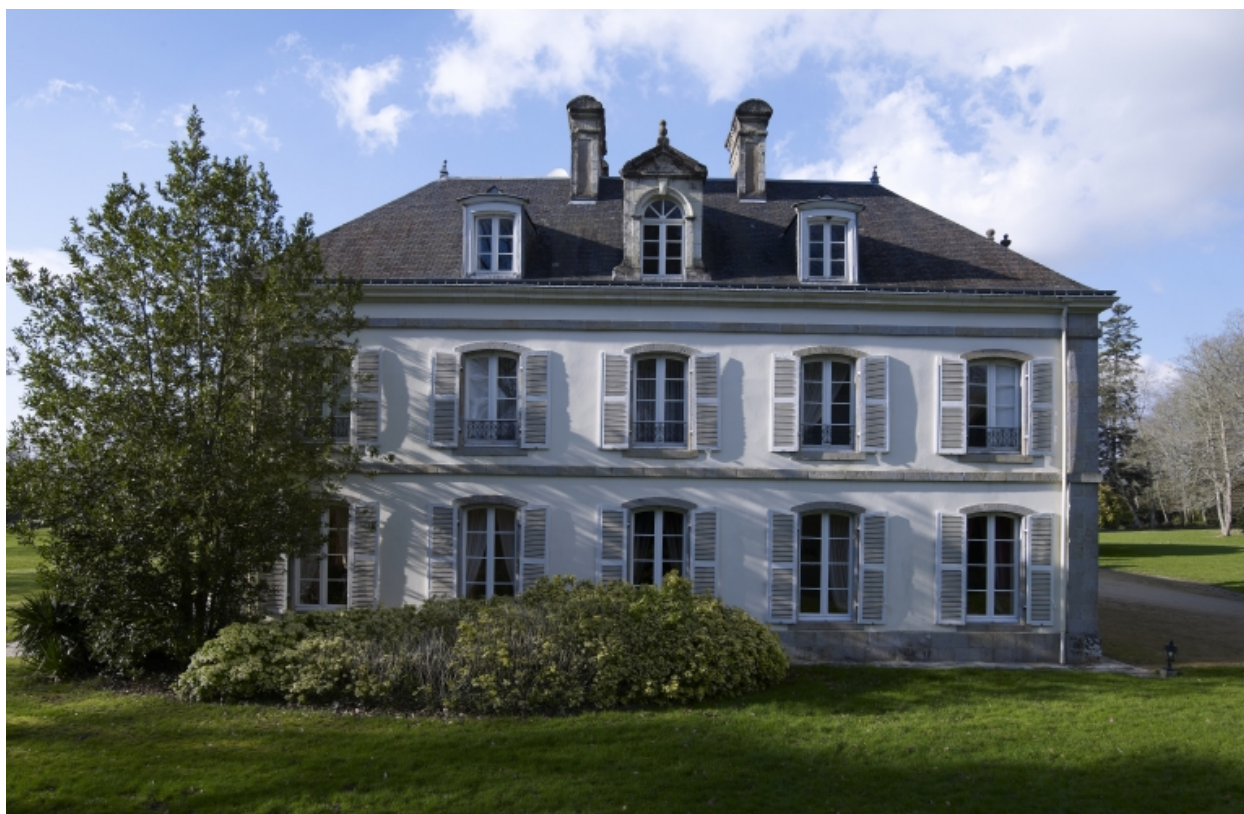
Pavillon est, élévation latérale est
