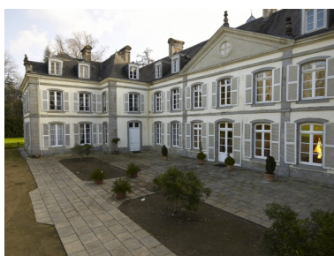
Elévation nord, vue prise du nord-ouest Phot. Bernard Bègne IVR53_20115600340NUCA
