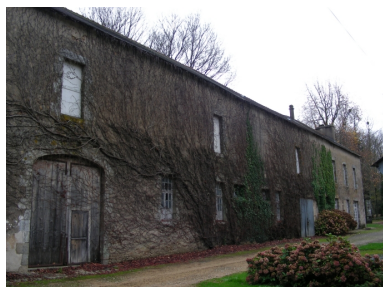
Ferme, élévation sud, vue générale Phot. Catherine Toscer IVR53_20095606145NUCA
