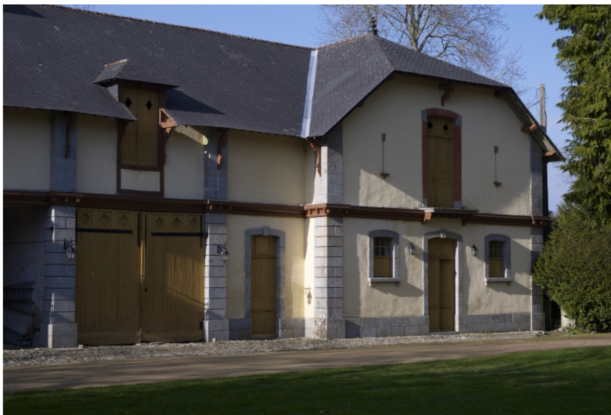
Communs, élévation est, partie nord
