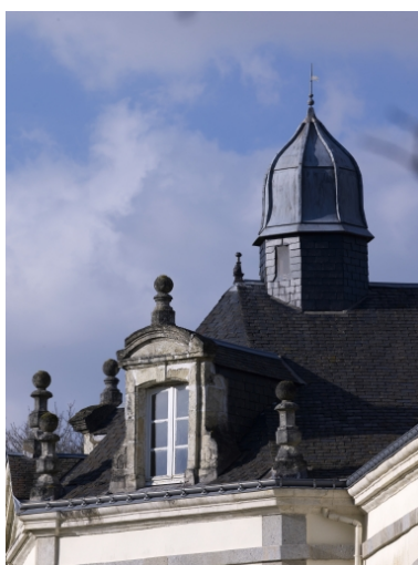
Elévation sud, corps médian, détail lucarne, amortissements et campanile Phot. Bernard Bègne IVR53_20115600332NUCA
