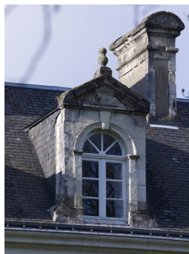
Pavillon est, élévation est : détail de la lucarne Phot. Bernard Bègne
