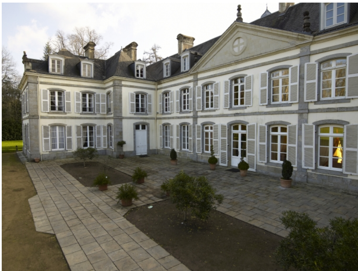
Elévation nord, vue prise du nord-ouest
