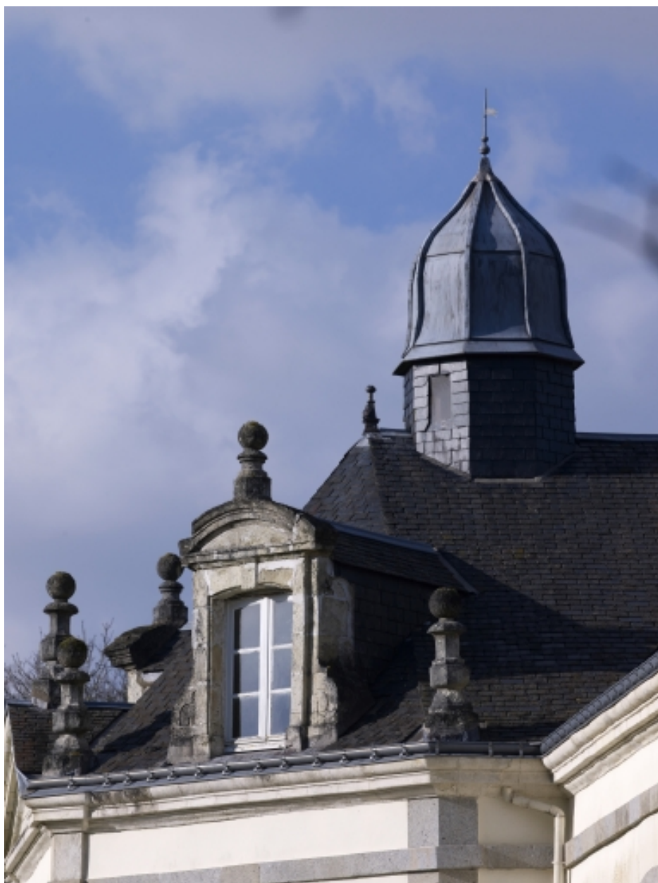
Elévation sud, corps médian, détail lucarne, amortissements et campanile
