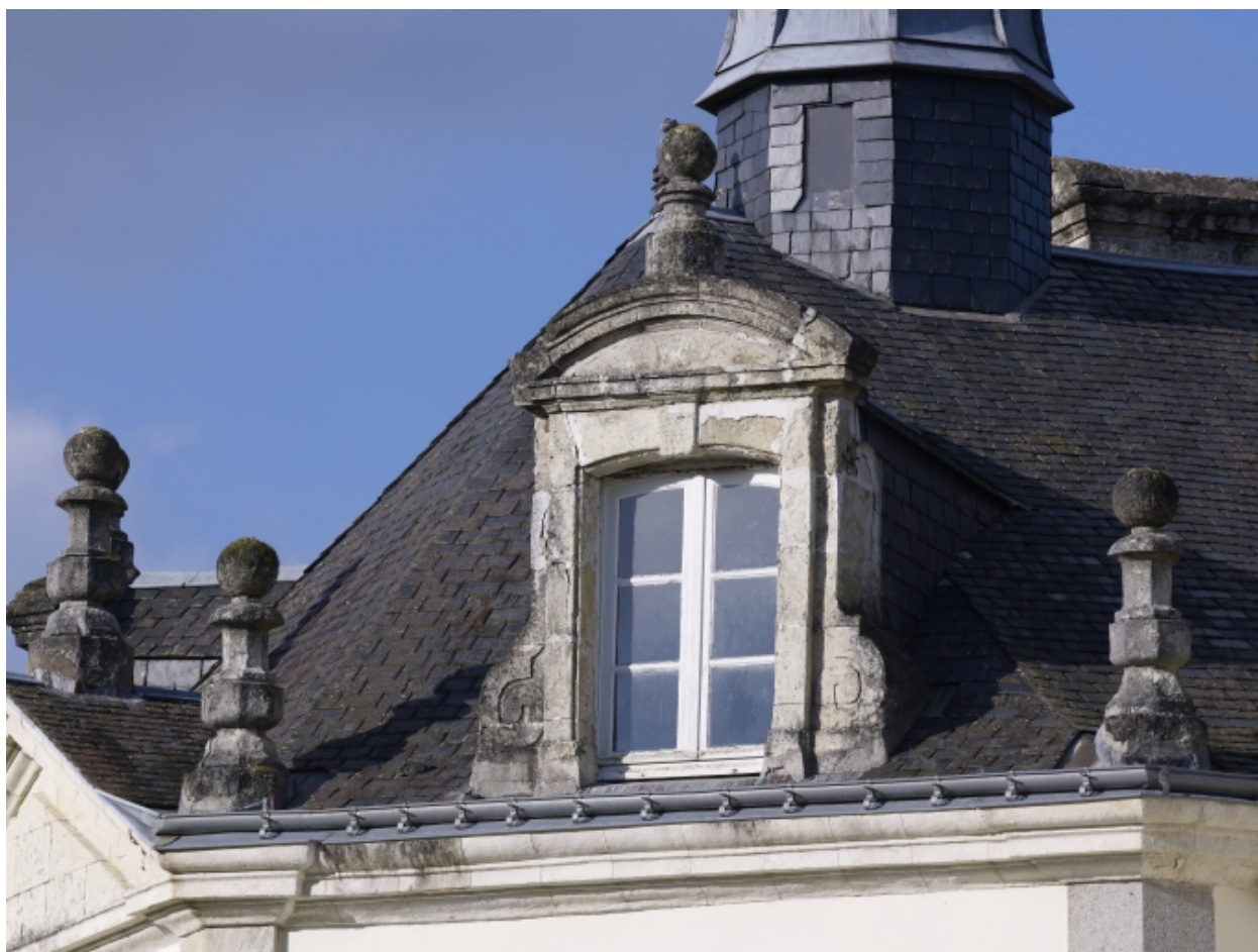
Elévation sud, avant-corps polygonal, détail lucarne
