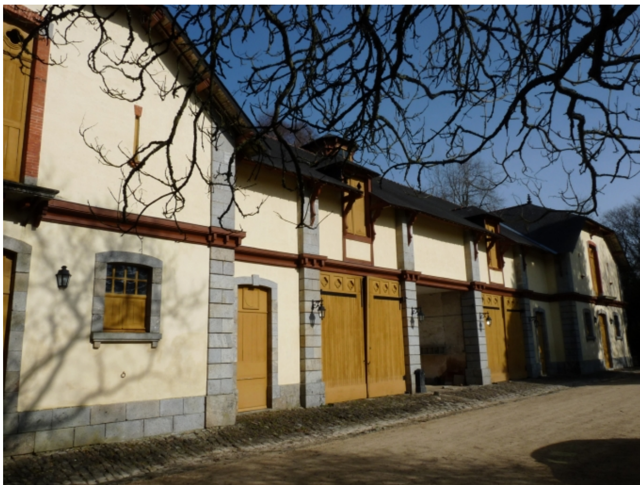
Communs, élévation est, vue sud-est
