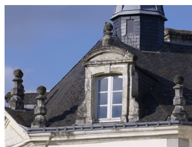
Elévation sud, avant-corps polygonal, détail lucarne Phot. Bernard Bègne IVR53_20115600333NUCA
