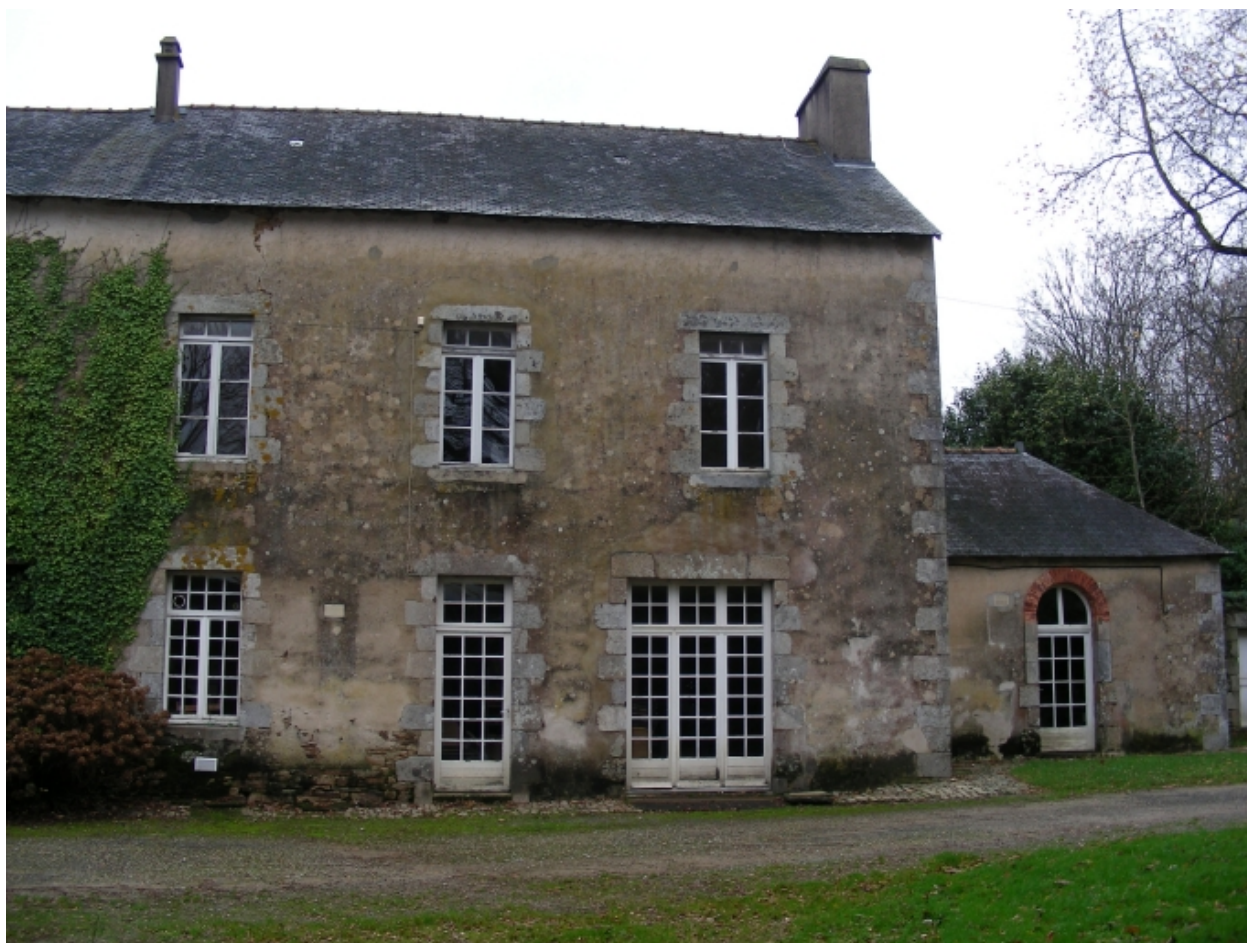
Ferme, élévation sud du logis
