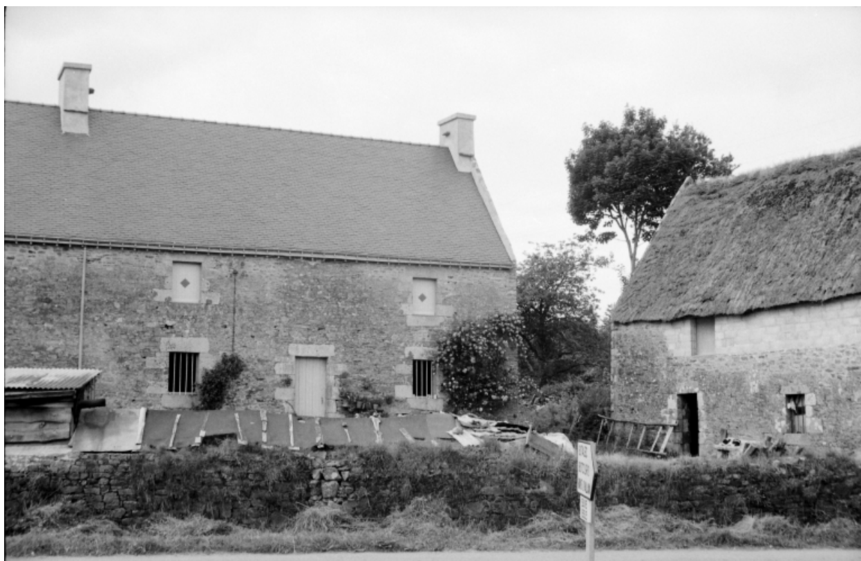
Métairie du château, logis daté 1813, vue générale en 1969
