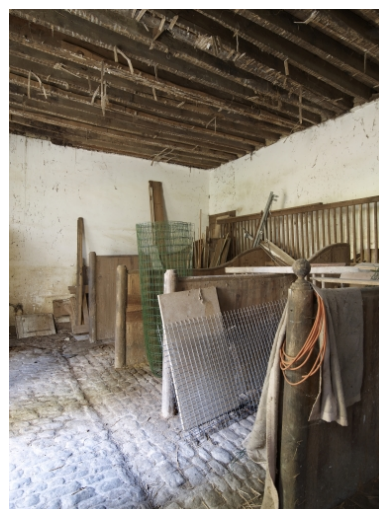
Communs, vue intérieure, stalles Phot. Bernard Bègne IVR53_20115600350NUCA
