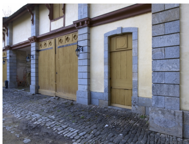
Communs, élévation est, partie centrale, détail des portes Phot. Bernard Bègne IVR53_20115600347NUCA
