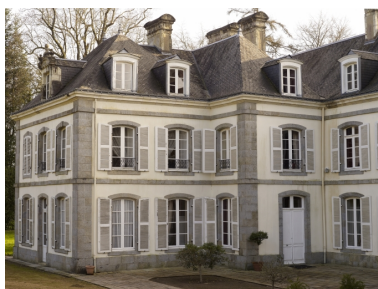
Elévation nord, corps latéral est, vue nord-ouest Phot. Bernard Bègne IVR53_20115600339NUCA
