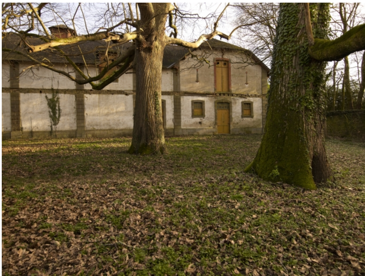
Communs, élévation ouest sur cour de la ferme, partie sud
