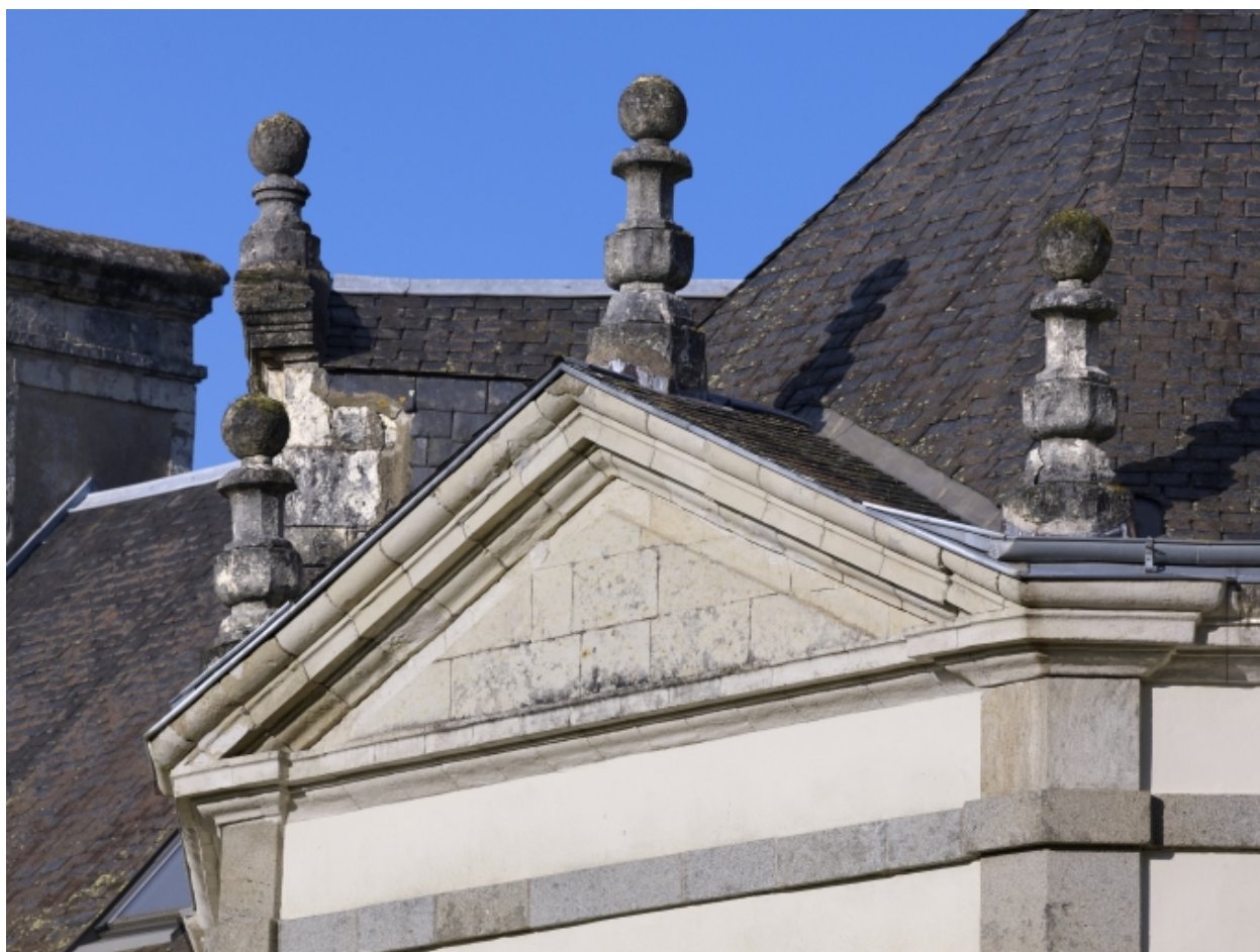
Elévation sud, avant-corps polygonale, détail fronton et amortissement en balustres
