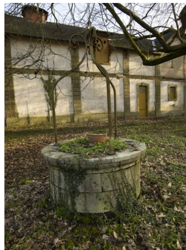
Cour de la ferme, puits Phot. Bernard Bègne IVR53_20115600346NUCA
