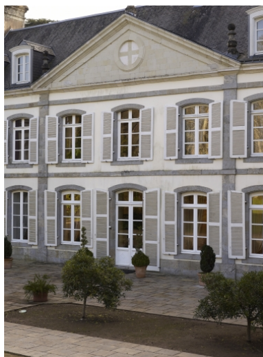
Elévation nord, détail des trois travées centrales Phot. Bernard Bègne IVR53_20115600338NUCA
