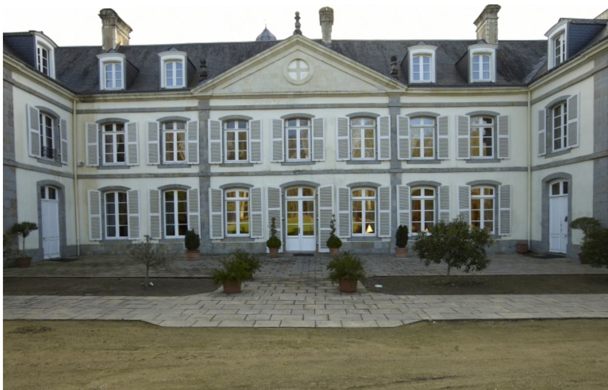
Elévation nord, détail corps central
