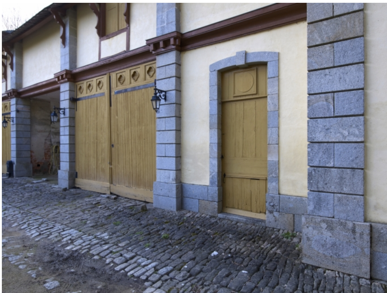
Communs, élévation est, partie centrale, détail des portes
