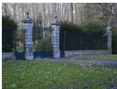
Portail d'entrée est Phot. Bernard Bègne IVR53_20115600352NUCA
