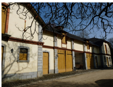
Communs, élévation est, vue sud-est Phot. Catherine Toscer IVR53_20095606144NUCA
