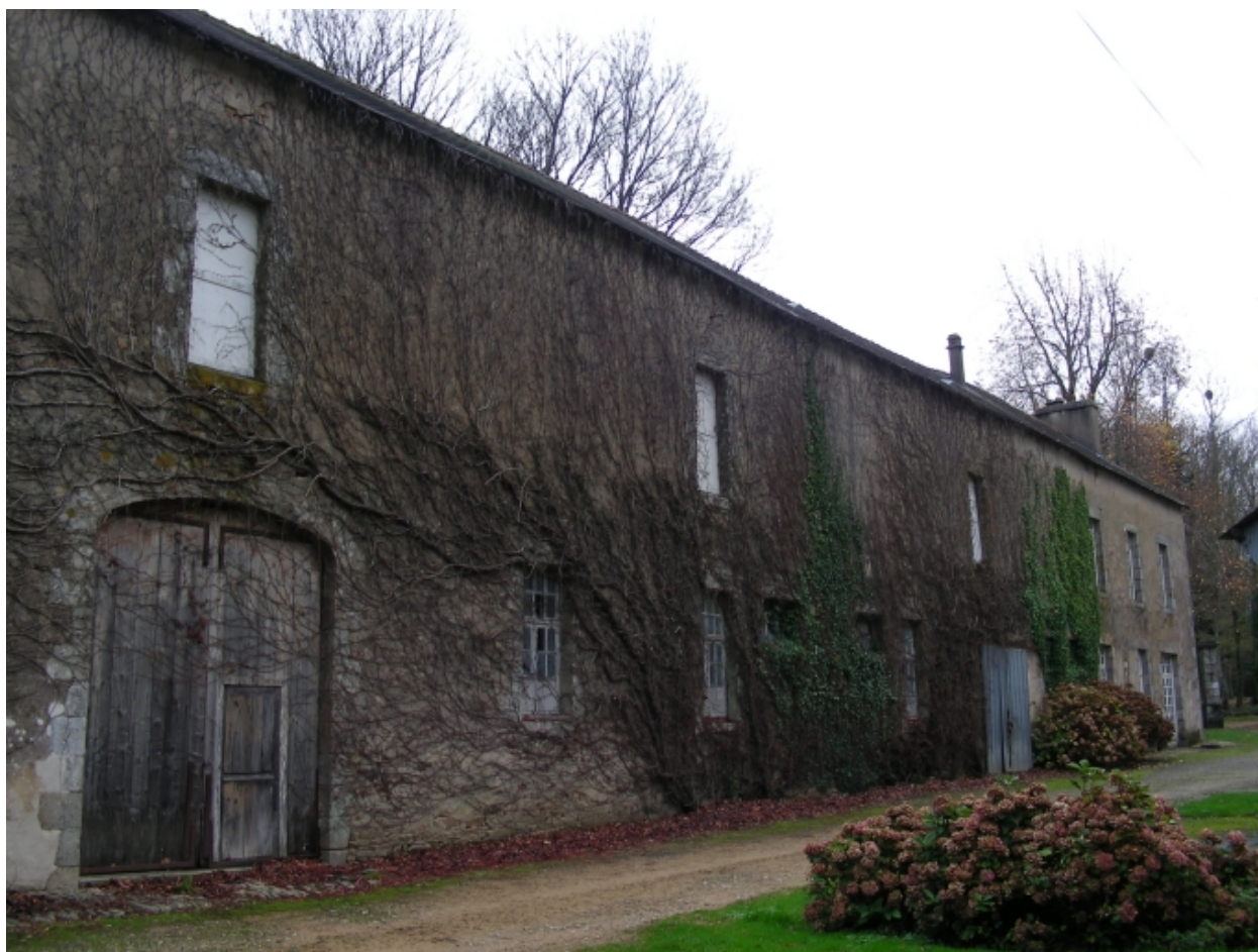
Ferme, élévation sud, vue générale
