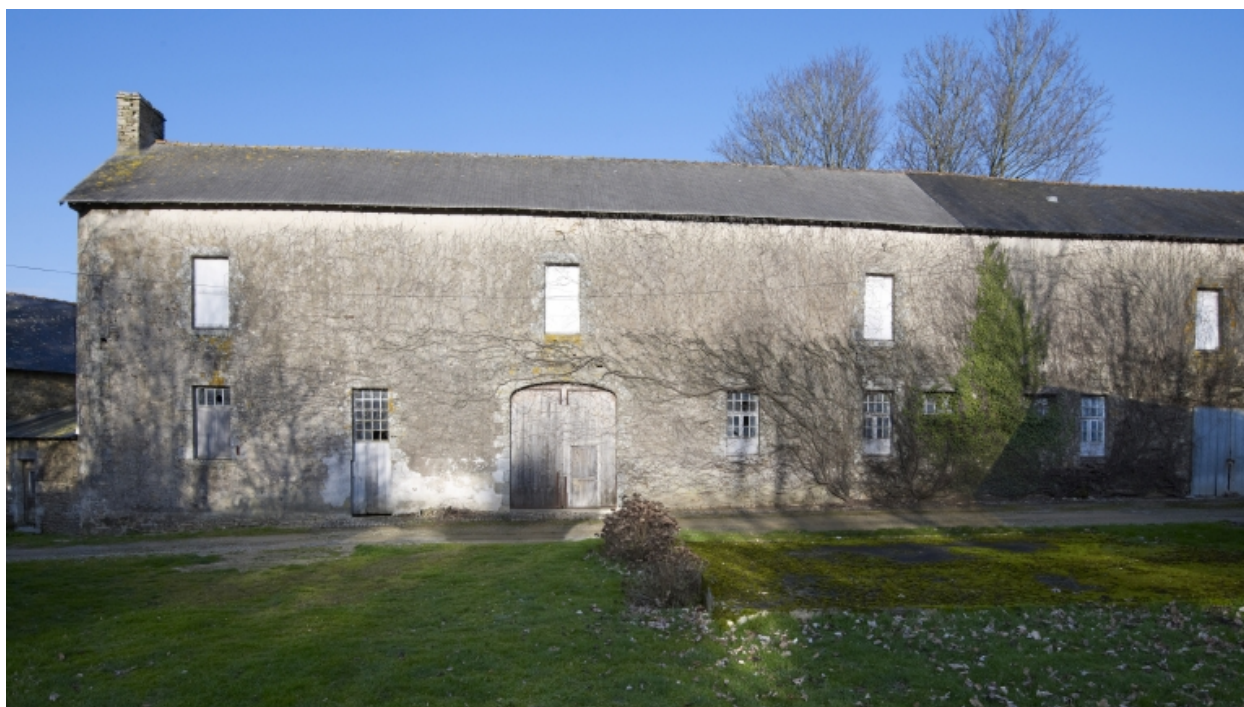
Ferme, élévation sud de la partie agricole
