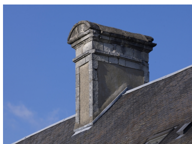
Corps principal, souche de cheminée Phot. Bernard Bègne IVR53_20115600334NUCA
