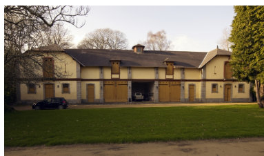
Communs, élévation antérieure est Phot. Bernard Bègne IVR53_20115600342NUCA
