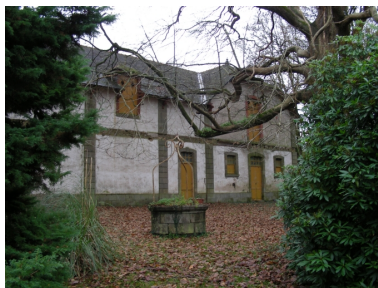
Puits et élévation ouest des communs Phot. Catherine Toscer IVR53_20095606146NUCA
