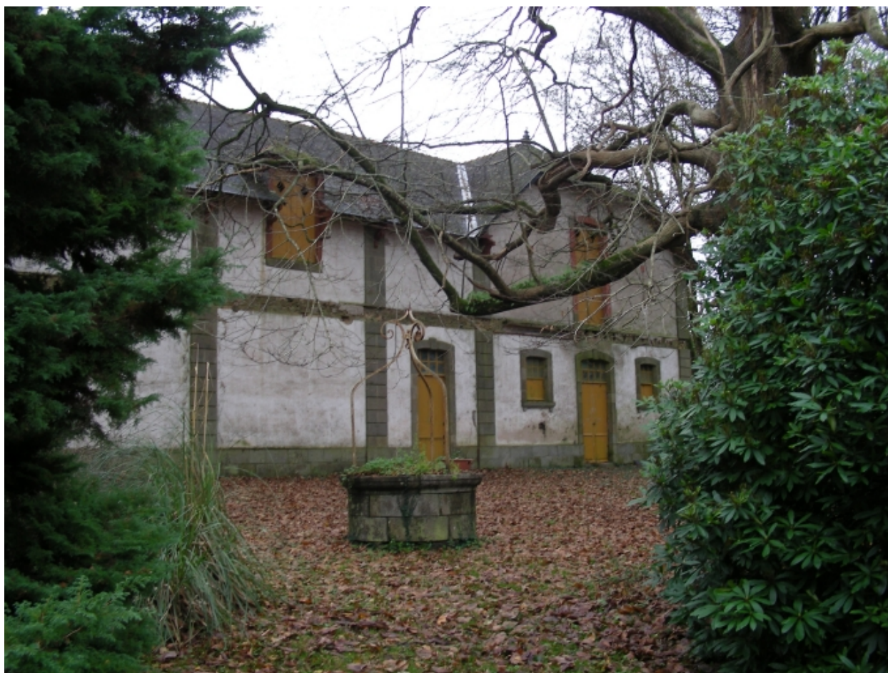
Puits et élévation ouest des communs
