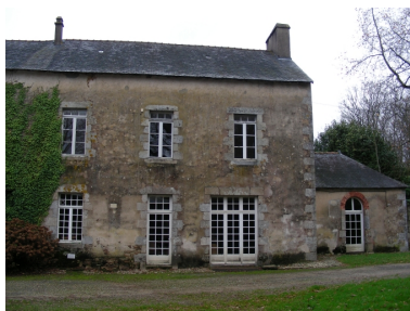
Ferme, élévation sud du logis Phot. Catherine Toscer IVR53_20095606186NUCA
