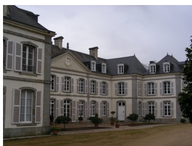
Vue générale nord-est Phot. Catherine Toscer IVR53_20095606143NUCA
