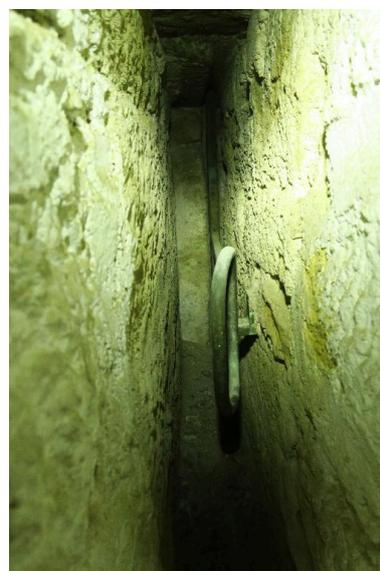
Le Palais, citadelle, magasin à poudre de l'Avancée, évent d'aération, détail du mécanisme d'obturation.
