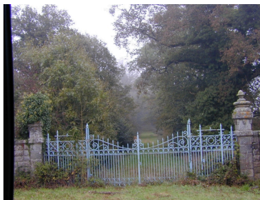
La grille et l'avenue principale : vue générale sud-ouest Phot. Xavier Gilbert IVR53_20013512873NUCA
