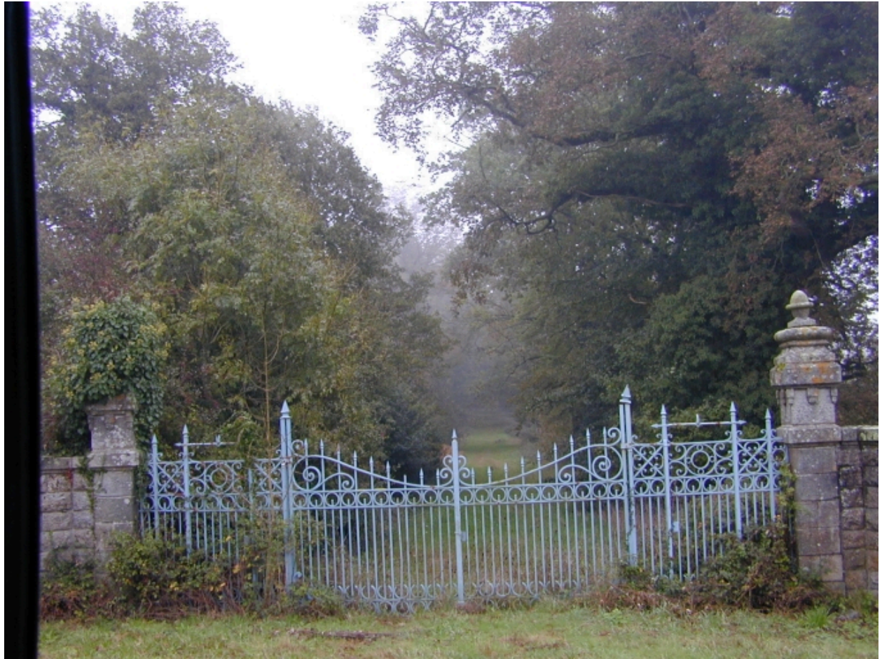
La grille et l'avenue principale : vue générale sud-ouest
