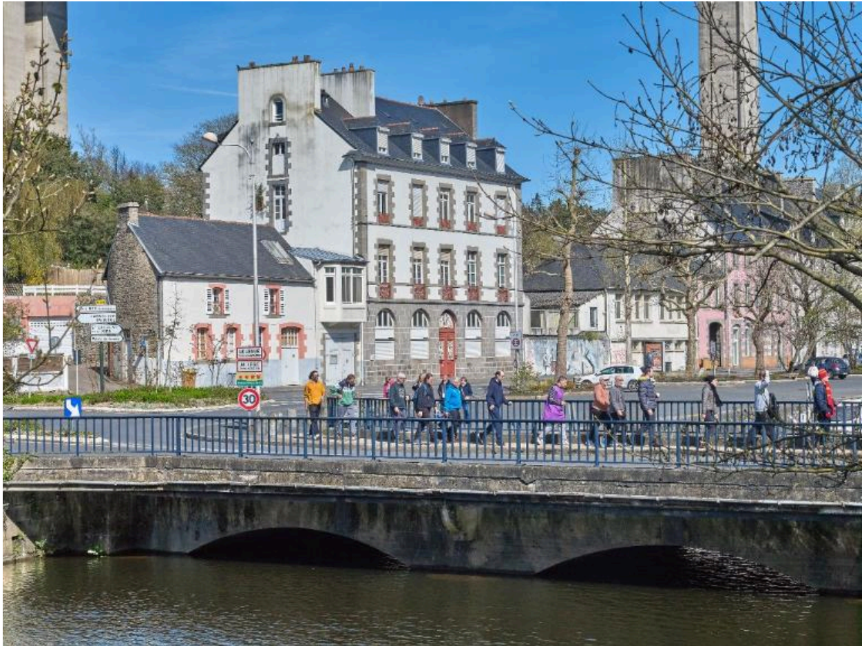
Alignement des maisons quai Chanoine Guinard depuis le pont de pierre
