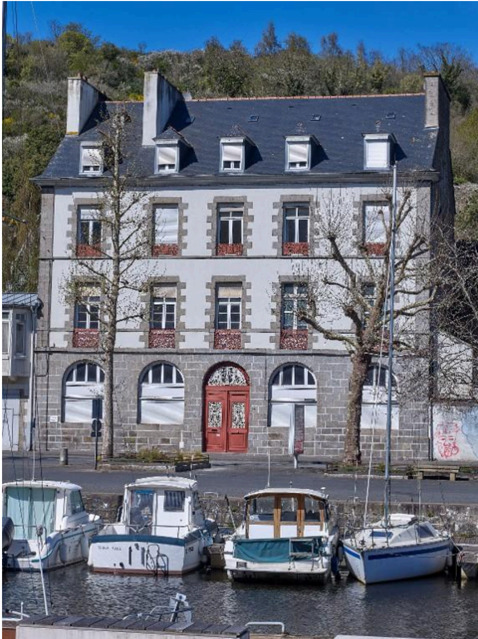
Elévation principale d'un immeuble à logements dont la construction est liée à l'activité portuaire du 19e siècle
