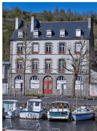
Élévation principale d'un immeuble à logements dont la construction est liée à l'activité portuaire du 19e siècle Phot. Bernard Bègne IVR53_20262200262NUCA
