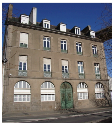
Vue générale en 2008 Phot. Patrick Pichouron IVR53_20082212637NUCA
