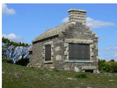
Pignon sud et façade ouest du corps de garde de Bellangenêt Phot. Julien Amghar IVR53_20082908642NUCA
