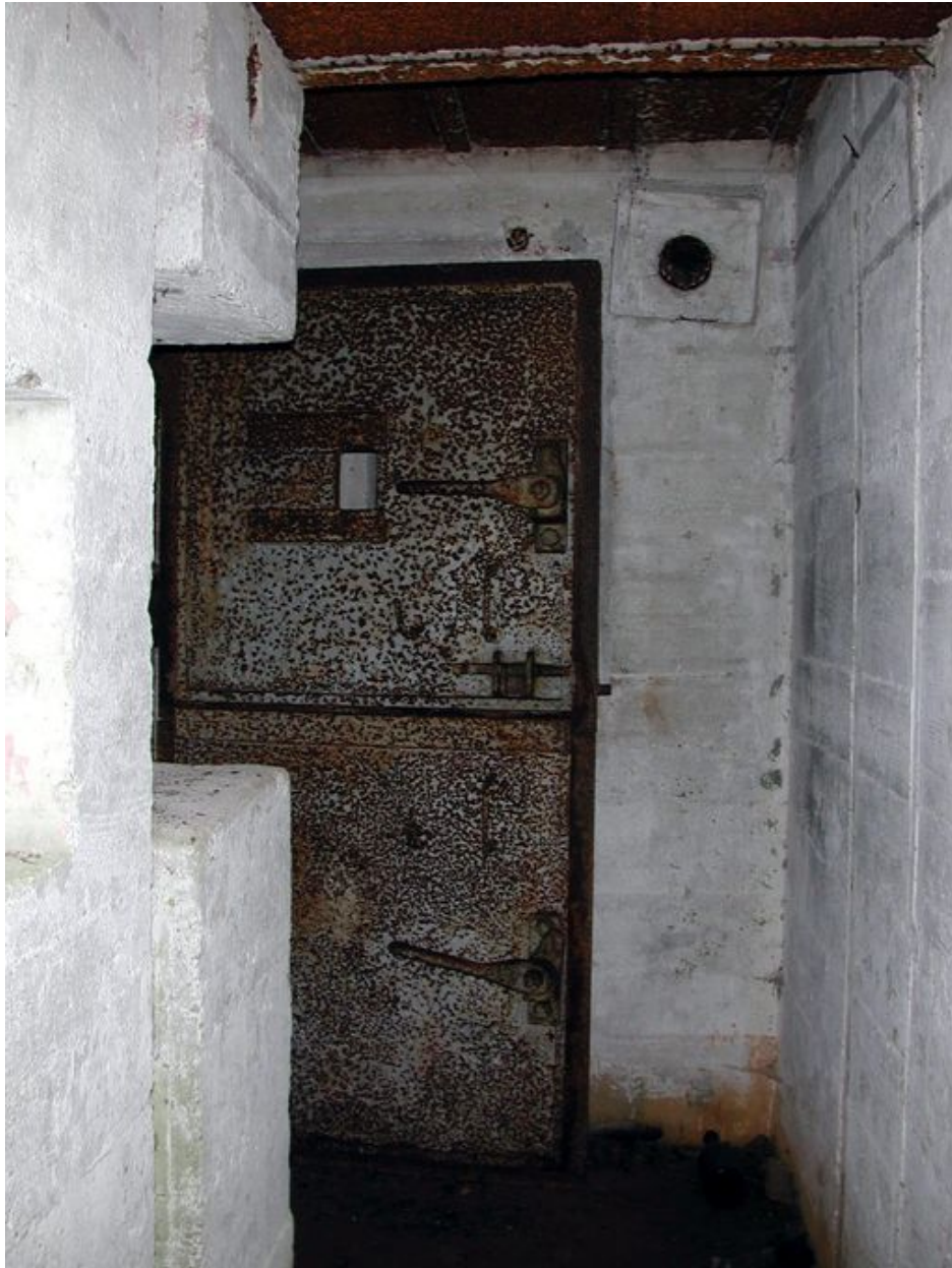
Vue intérieure : porte blindée (état en 2002)
