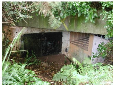
Vue de la porte blindée de la chambre de combat et du créneau de tir (état en 2002). Les accès au bunker sont défendus par un créneau de tir ; les peintures sont d'origine Phot. Guillaume Lécueillier IVR53_20022902955NUCA
