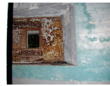
Vue de la salle de garde : créneau blindé permettant de défendre l'entrée (état en 2002) Phot. Guillaume Lécueillier IVR53_20072905885NUCA
