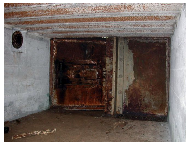
Vue intérieure : porte blindée de type 447P01 de la chambre de combat (état en 2002) Phot. Guillaume Lécueillier IVR53_20072905883NUCA
