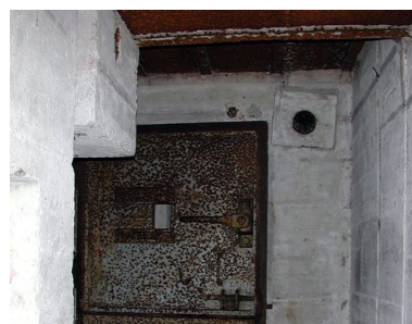
Vue intérieure : porte blindée de type 447P01 de la chambre de combat (état en 2002) Phot. Guillaume Lécueillier IVR53_20072905883NUCA
