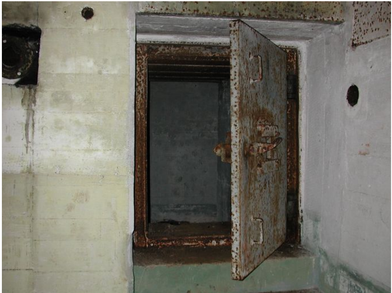
Vue intérieure : porte blindée (état en 2002)
