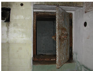
Vue intérieure : porte blindée (état en 2002) Phot. Guillaume Lécueillier IVR53_20072905882NUCA
