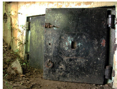
Vue de la porte blindée à deux battants de la chambre de combat (état en 2002) Phot. Guillaume Lécueillier IVR53_20072905880NUCA
