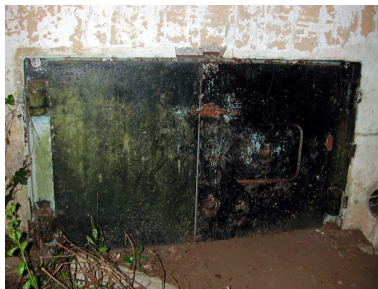
Vue de la porte blindée à deux battants de la chambre de combat (état en 2002) Phot. Guillaume Lécueillier IVR53_20072905879NUCA
