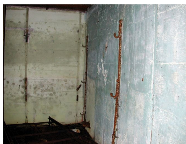
Vue de la salle de garde : fixations des couchettes tubulaires (état en 2002) Phot. Guillaume Lécueillier IVR53_20072905884NUCA
