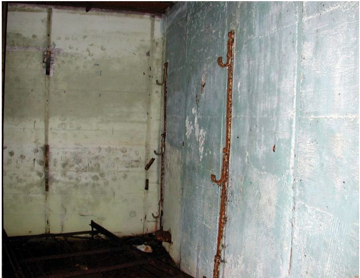
Vue de la salle de garde : fixations des couchettes tubulaires (état en 2002)
