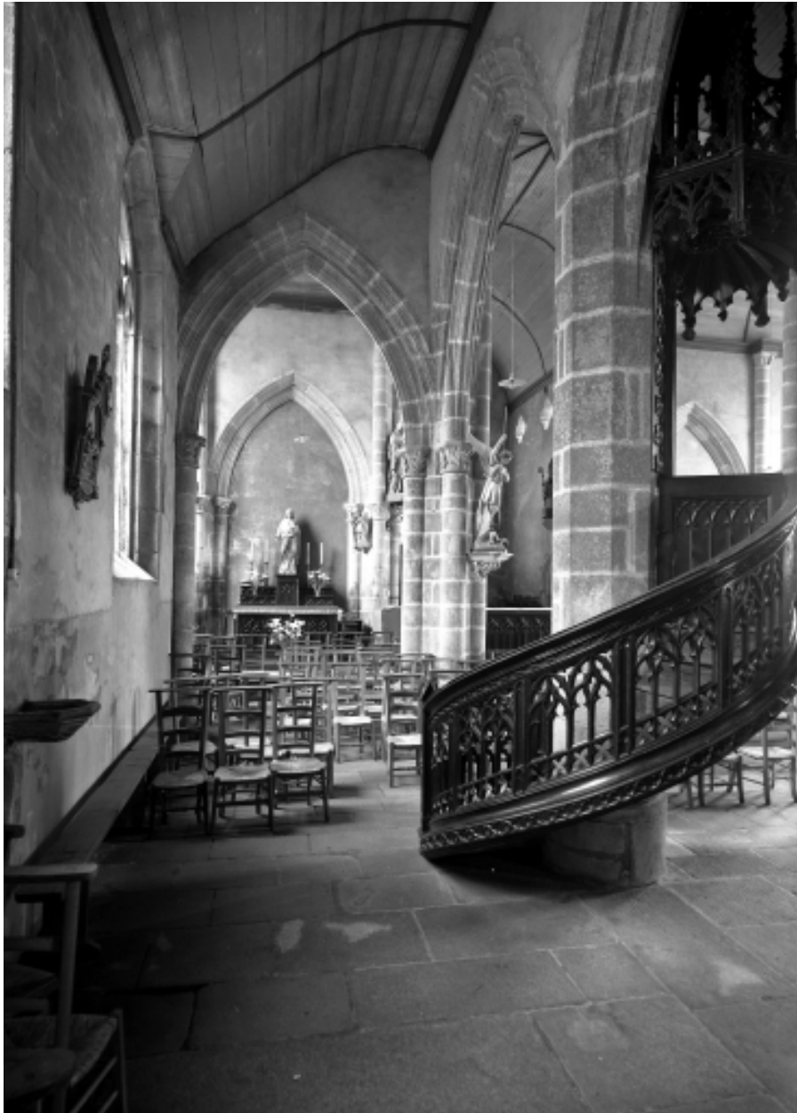
Quéménéven, église paroissiale Saint-Ouen : bas-côté nord, état en 1972
