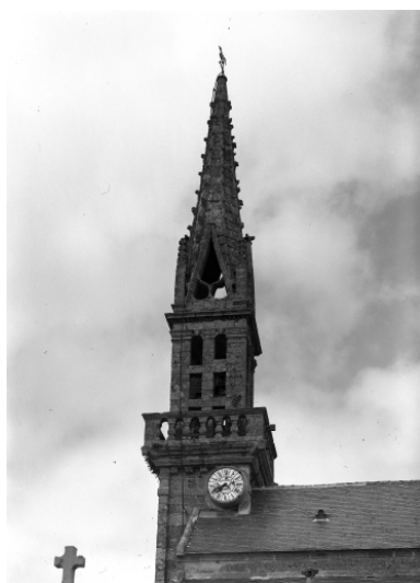
Quéménéven, église paroissiale Saint-Ouen : façade ouest, détail clocher, état en 1972 Phot. François Dagorn IVR53_19722900748V
