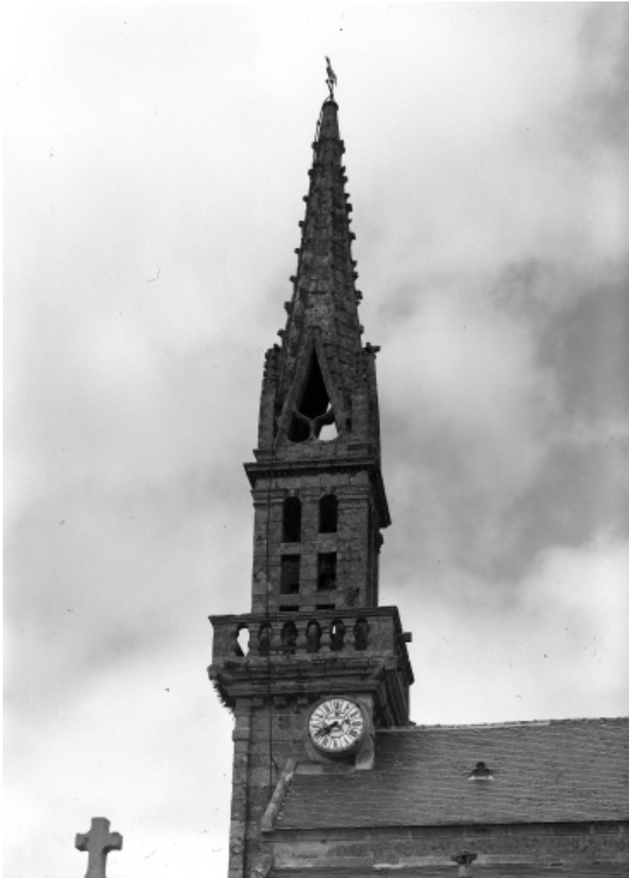
Quéménéven, église paroissiale Saint-Ouen : façade ouest, détail clocher, état en 1972
