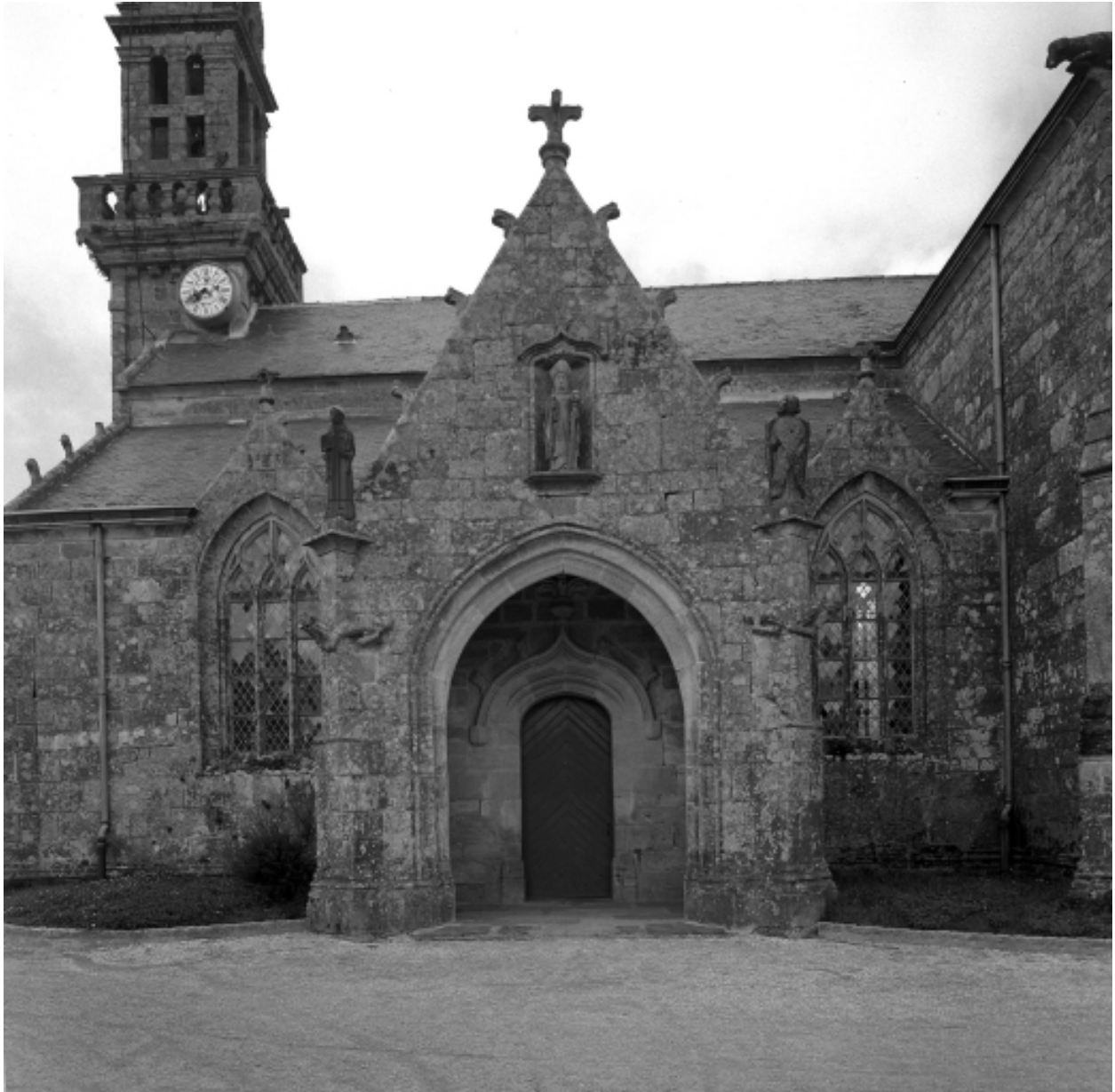
Quéménéven, église paroissiale Saint-Ouen : façade sud, le porche, état en 1972
