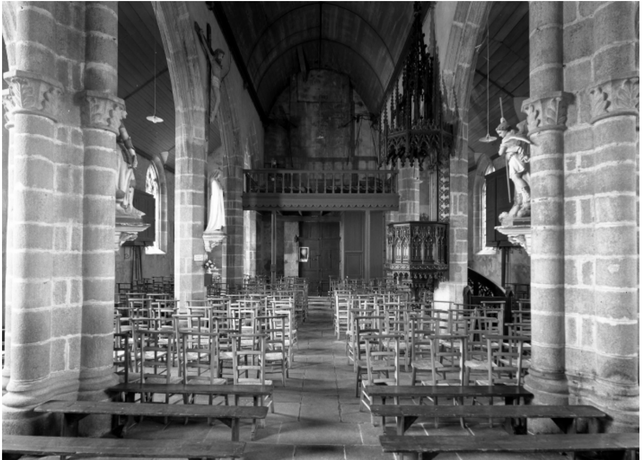
Quéménéven, église paroissiale Saint-Ouen : vue intérieure d'est en ouest, état en 1972
