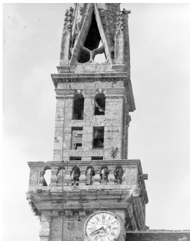
Quéménéven, église paroissiale Saint-Ouen : façade ouest, clocher, inscription face sud, état en 1972 Phot. François Dagorn IVR53_19722900812X
