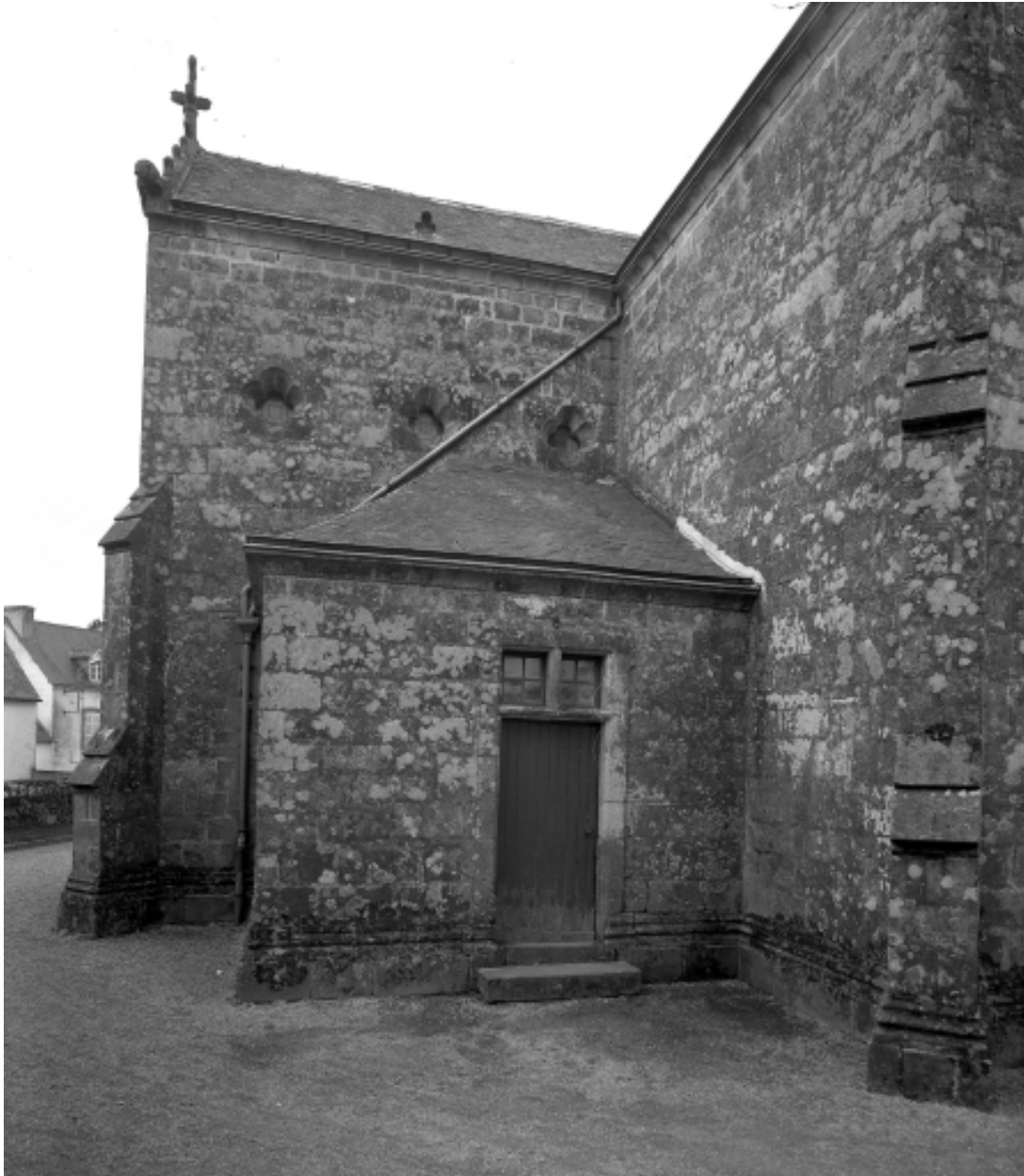
Quéménéven, église paroissiale Saint-Ouen : façade nord, partie est, état en 1972
