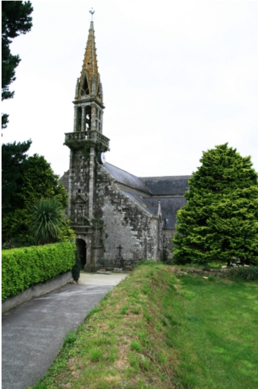
Quéménéven, église paroissiale Saint-Ouen : vue générale sud-ouest
