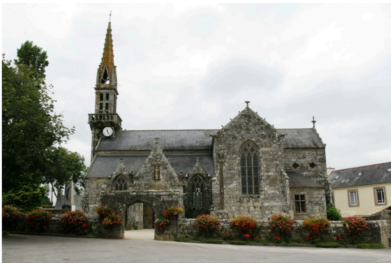
Quéménéven, église paroissiale Saint-Ouen : élévation sud
