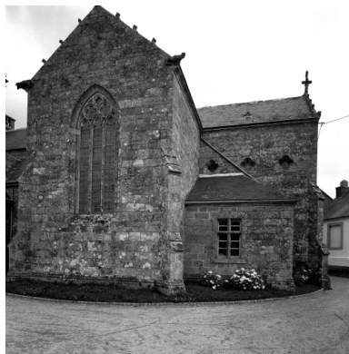
Quéménéven, église paroissiale Saint-Ouen : façade sud, partie est, état en 1972 Phot. François Dagorn IVR53_19722900757V
