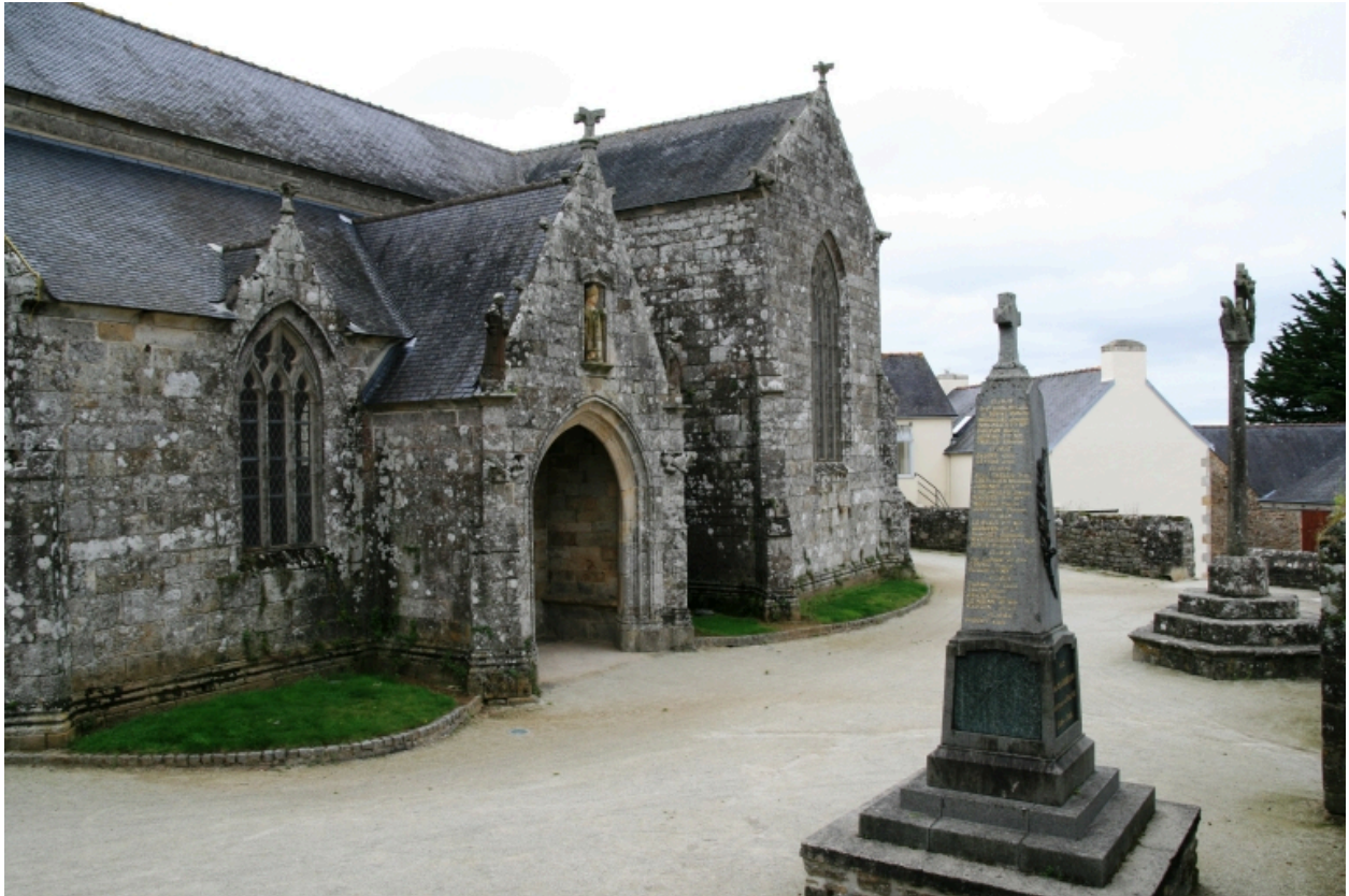
Quéménéven, église paroissiale Saint-Ouen : vue générale sud
