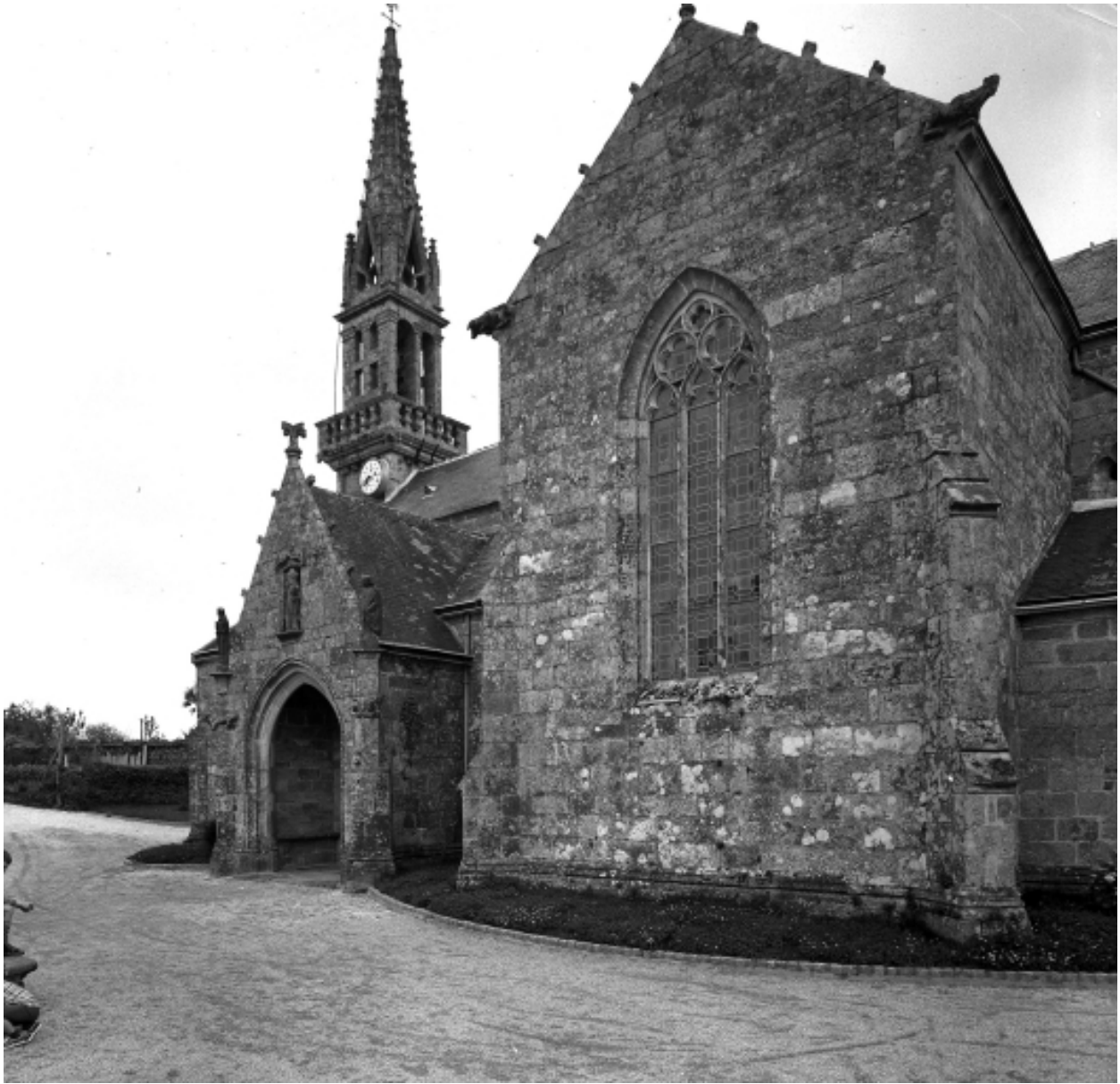
Quéménéven, église paroissiale Saint-Ouen : façade sud, vue sud-est, état en 1972
