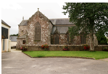
Quéménéven, église paroissiale Saint-Ouen : vue générale nord Phot. Gwénaél Fauchille IVR53_20082906694NUCA
