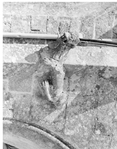
Quéménéven, église paroissiale Saint-Ouen : façade sud, le porche, détail crossette gauche, état en 1972 Phot. François Dagorn IVR53_19722900809X
