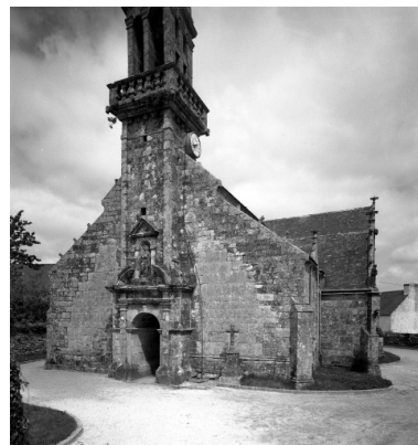
Quéménéven, église paroissiale Saint-Ouen : façade ouest, état en 1972 Phot. François Dagorn IVR53_19722900753V
