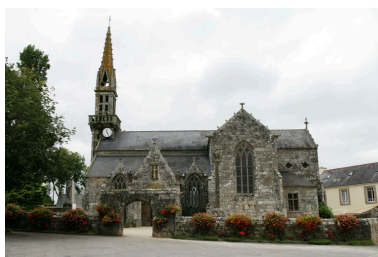
Quéménéven, église paroissiale Saint-Ouen : élévation sud Phot. Gwénaél Fauchille IVR53_20082906691NUCA
