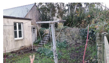
Vue des vestiges du mur de soutènement de la digue dans la parcelle section CA, n° 559 depuis la parcelle CA, n° 558 Phot. Alain Bargain IVR53_20263510288NUCA
