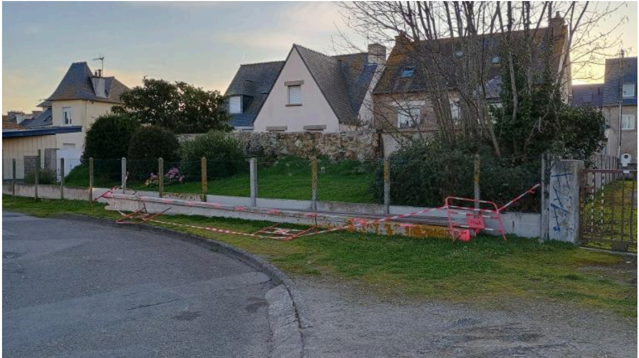
32 Vue des vestiges de la digue dans la parcelle section CA, n° 571 depuis la rue Claude Bernard à l'est
