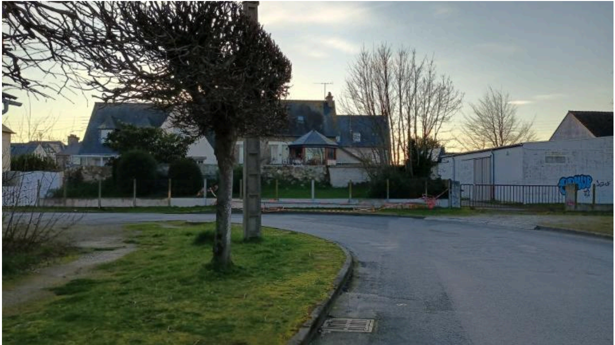
Vue des vestiges de la digue dans la parcelle section CA, n° 571 depuis la rue Claude Bernard à l'est
