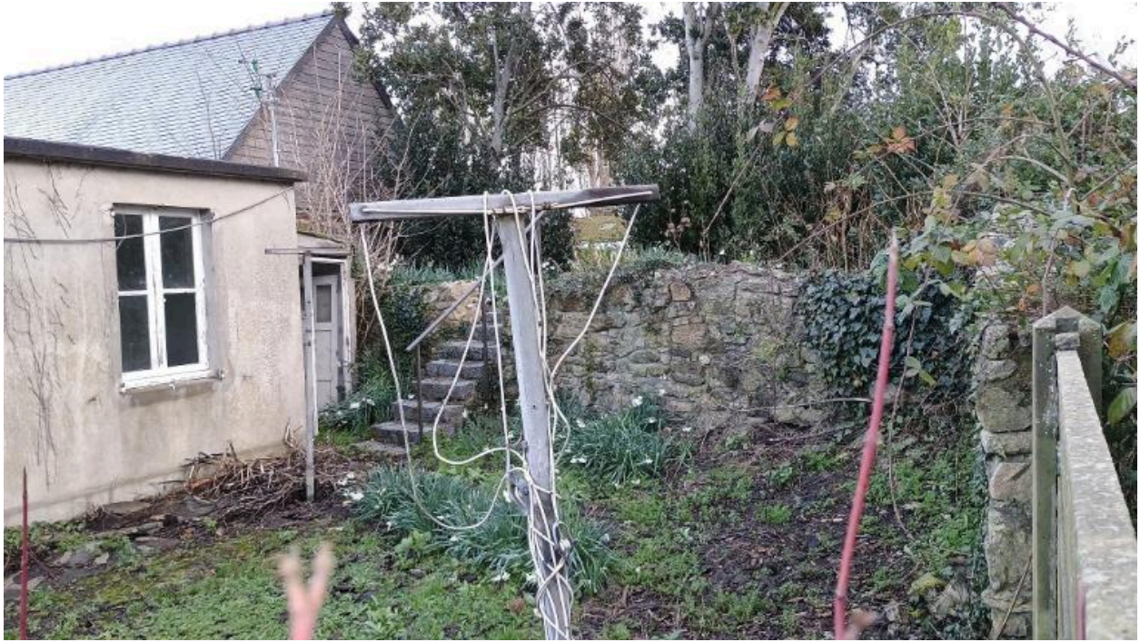
Vue des vestiges du mur de soutènement de la digue dans la parcelle section CA, n° 559 depuis la parcelle CA, n° 558
