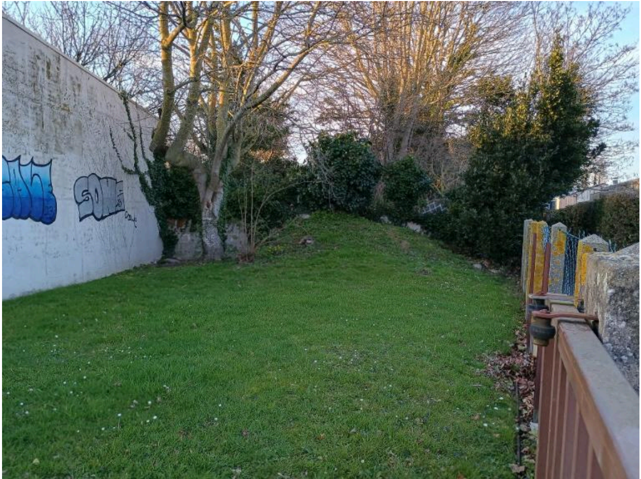
Vue de l'extrémité sud de la digue dans la parcelle section CA, n° 572 depuis le chemin des Amoureux
