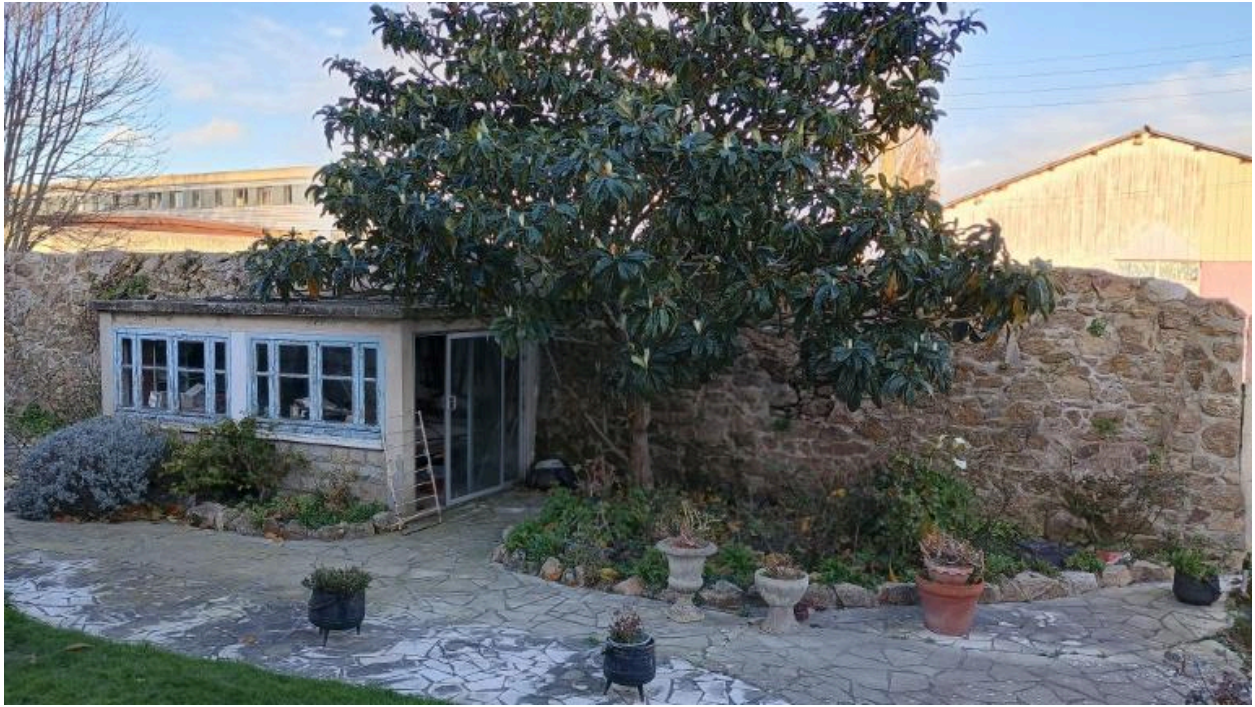
Vue du mur de soutènement de la digue dans la parcelle section CA, n° 571
