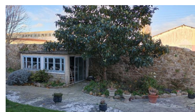
Vue du mur de soutènement de la digue dans la parcelle section CA, n° 571 Phot. Alain Bargain IVR53_20263510296NUCA
