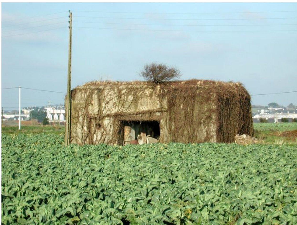
Vue générale de l'un des quatre bunkers - casemates de type 669 (état en 2002)
