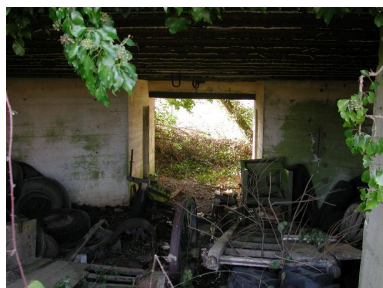
Vue intérieure de l'un des quatre bunkers - casemates de type 669 (état en 2002) Phot. Guillaume Lécueillier IVR53_20022901784NUCA
