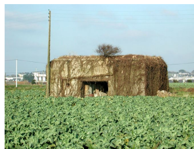
Vue générale de l'un des quatre bunkers - casemates de type 669 (état en 2002) Phot. Guillaume Lécueillier IVR53_20022901459NUCA
