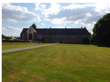
Vue générale est de l'ancien grand logis Phot. Laurence Marquet IVR53_20183506901NUCA
