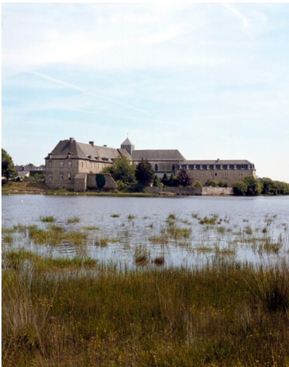
Vue partielle nord-ouest
