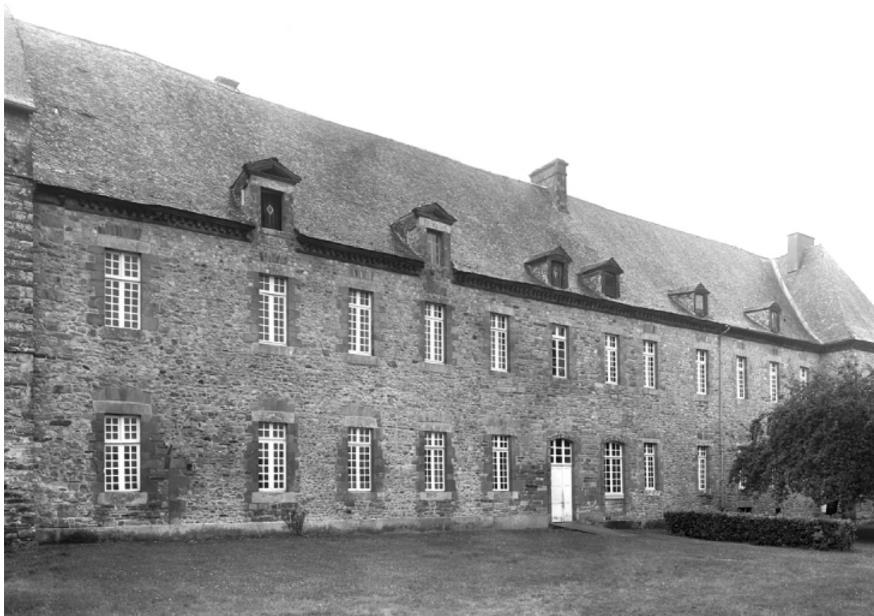
Bâtiment claustral, façade ouest ; détail
