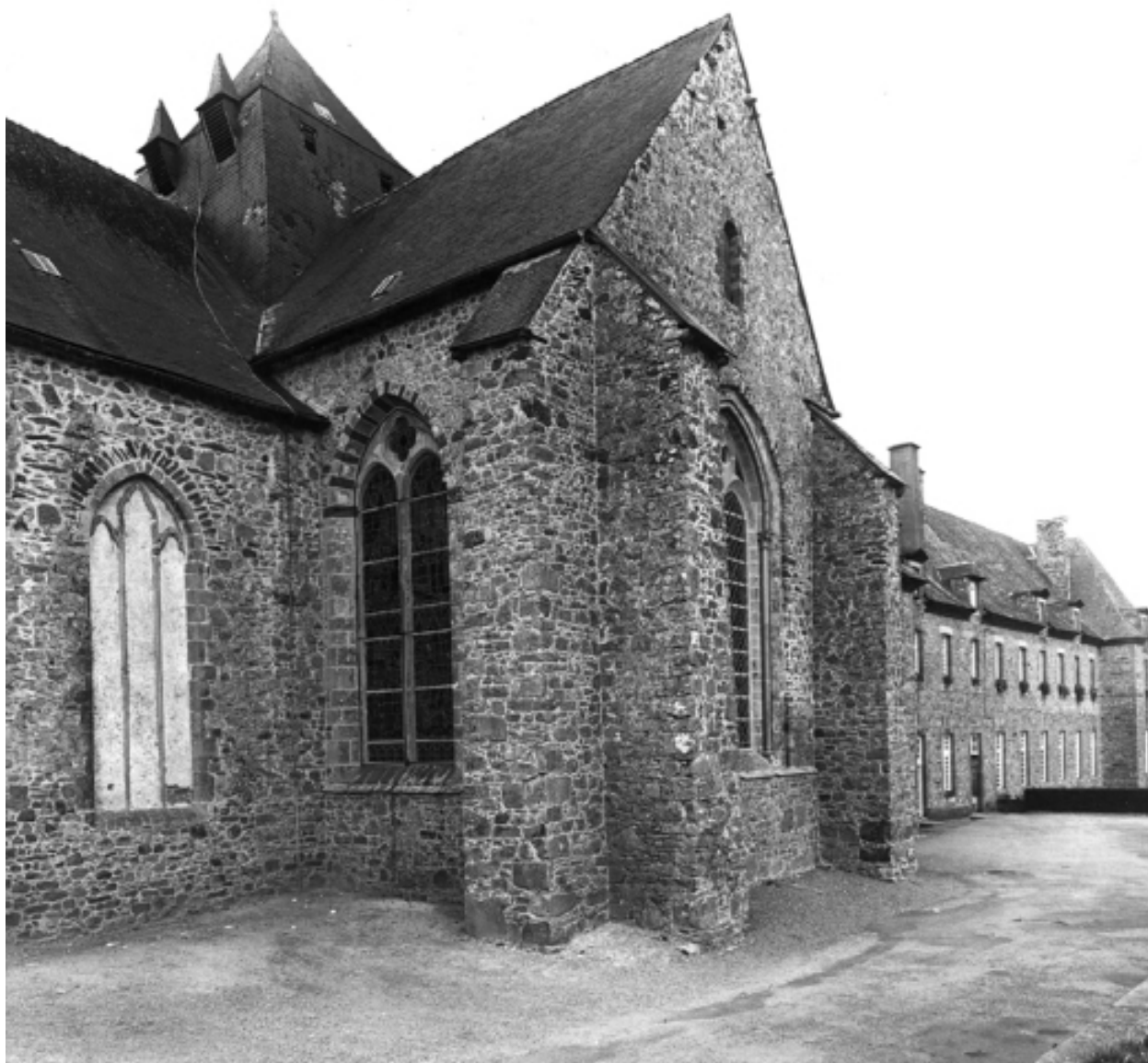
Eglise ; chevet, vue de situation
