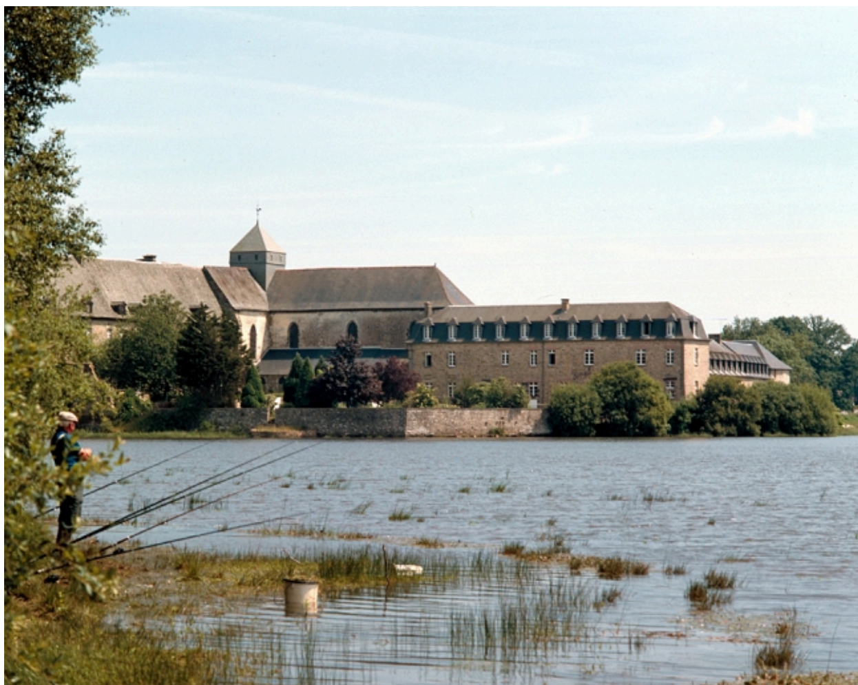
Vue partielle nord-ouest
