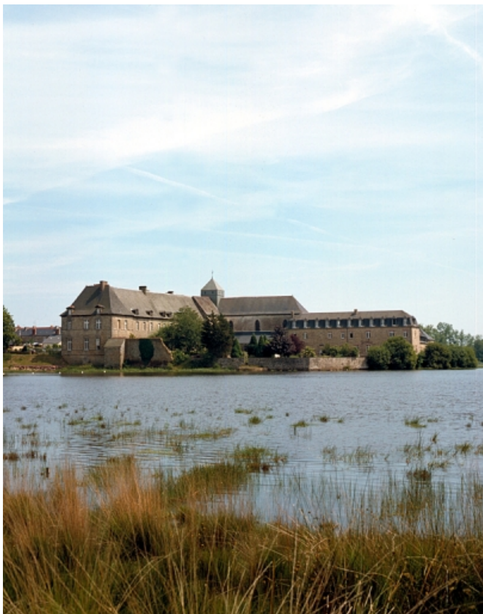
Vue partielle nord-ouest
