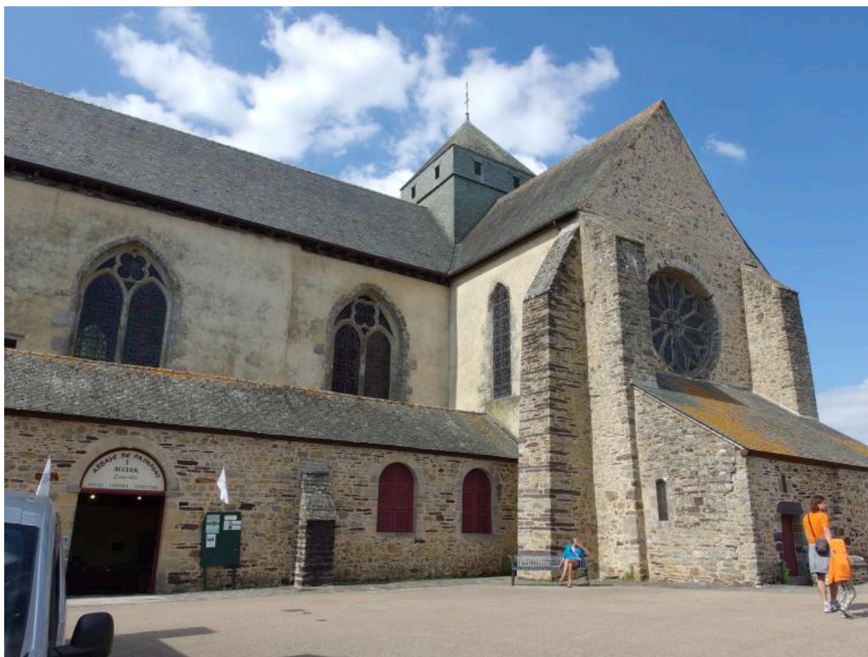
Vue partielle sud-ouest de l'abbaye 2018
