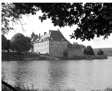
Vue générale prise de l'étang vers le sud-ouest Phot. Norbert Lambart IVR53_19823500508X
