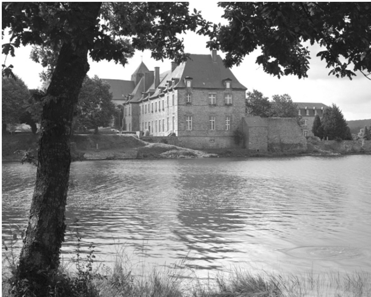
Vue générale prise de l'étang vers le sud-ouest
