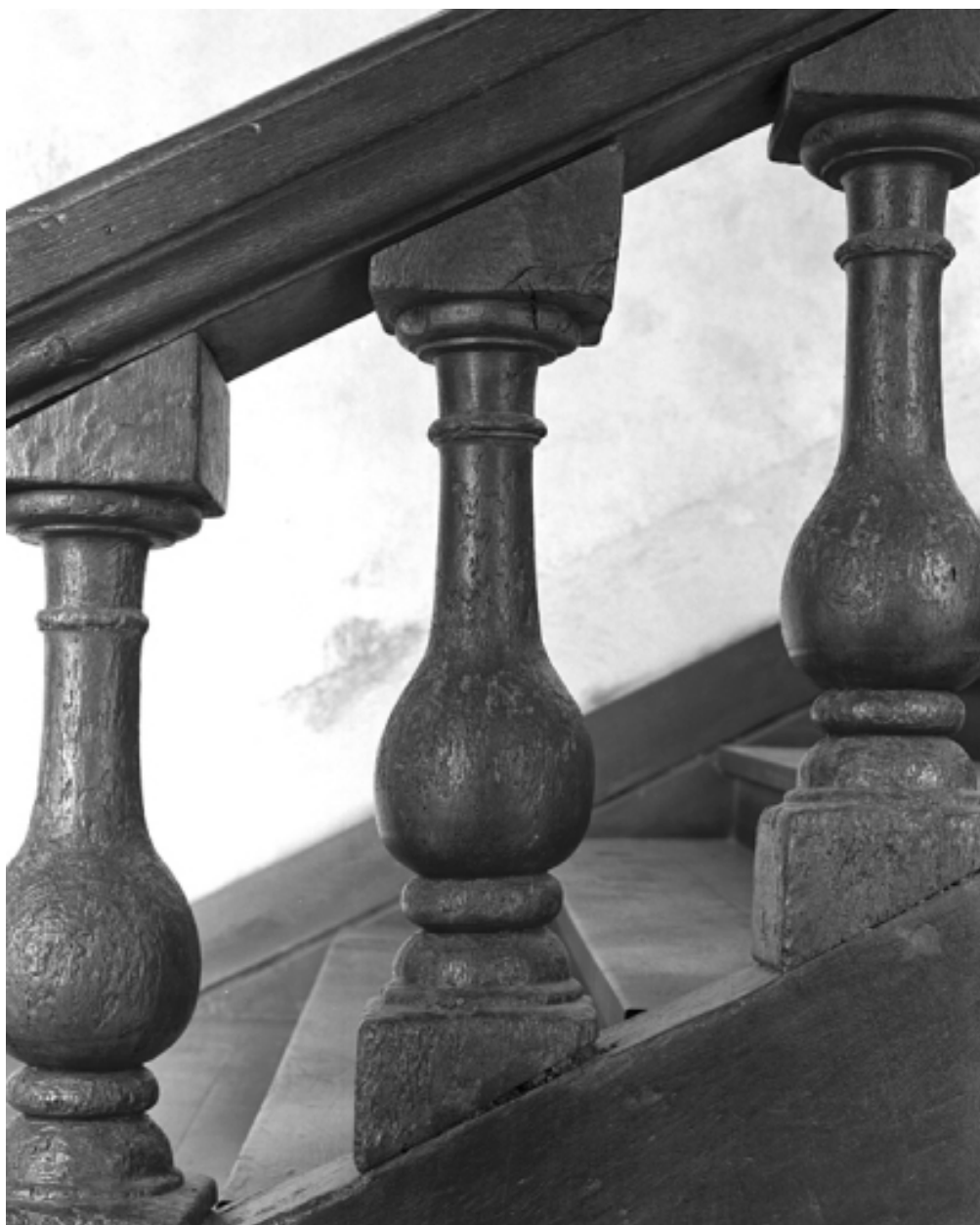
Ancien bâtiment claustral ; vue intérieure : escalier, balustres
