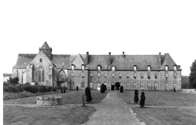
Vue générale prise vers l'ouest Phot. Norbert Lambart IVR53_19823500517V
