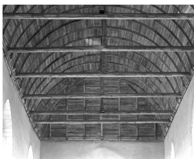
Eglise abbatiale ; vue intérieure : le lambris de couverture de la nef Phot. Norbert Lambart IVR53_19833500106X
