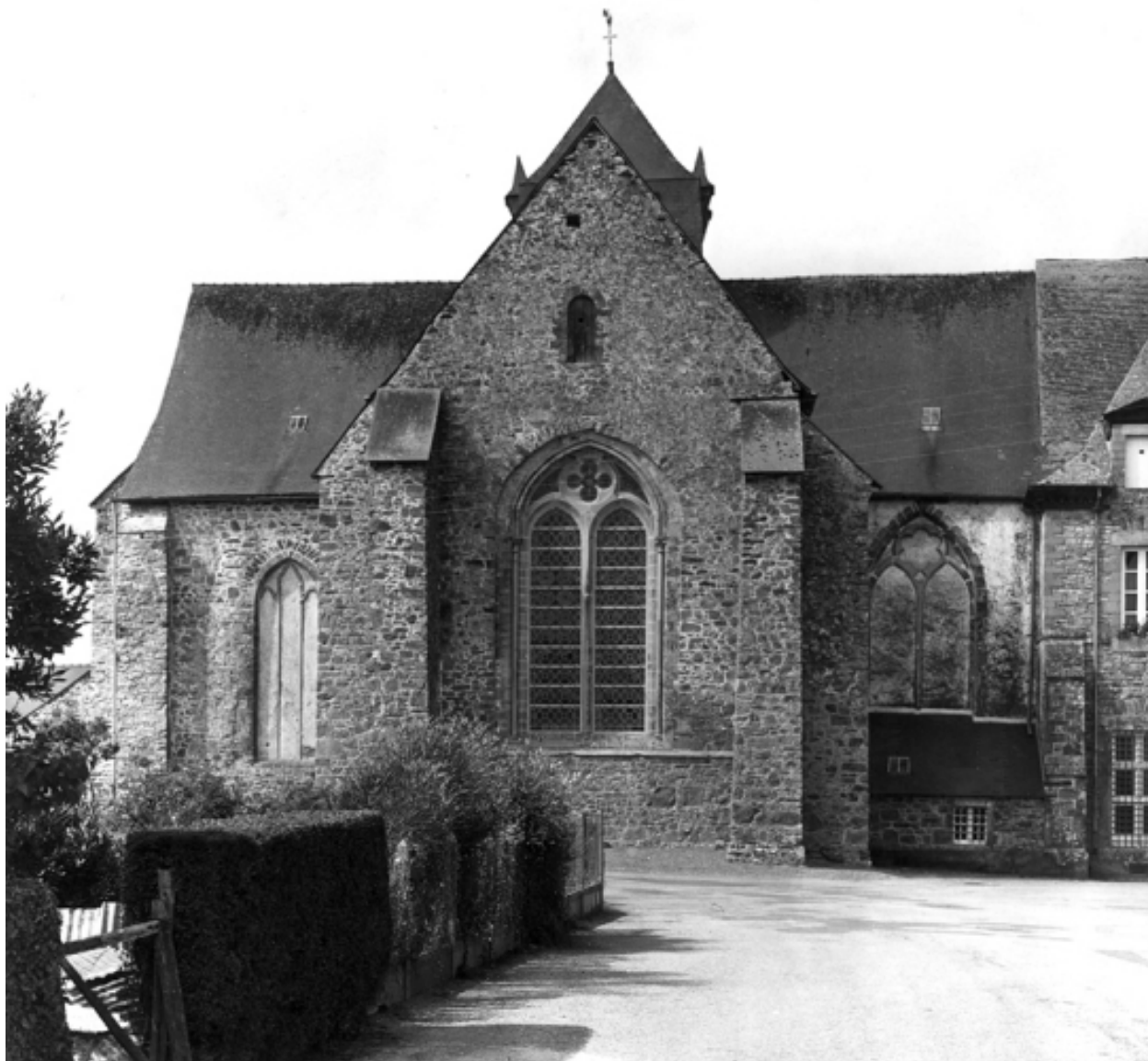
Eglise ; chevet, vue de situation
