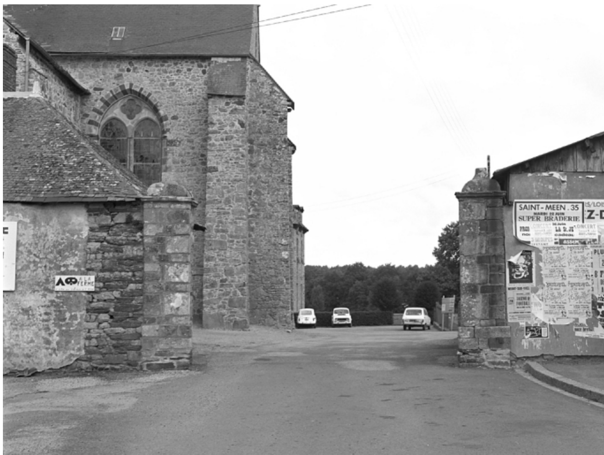
Eglise ; mur sud du choeur
