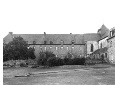
Bâtiment claustral, façade ouest Phot. Norbert Lambart IVR53_19823500526V
