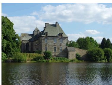
Vue générale nord du grand logis 2018 Phot. Laurence Marquet IVR53_20183506902NUCA
