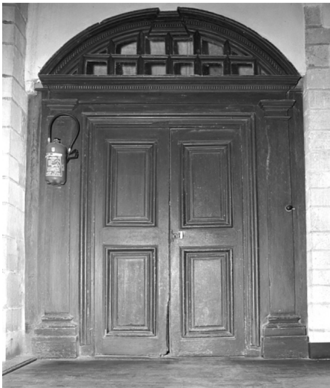
Ancien bâtiment claustral ; vue intérieure : 1er étage, porte d'accès aux cellules
