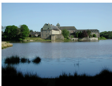
Vue générale nord Phot. Claude Quillivic IVR53_20023512718NUCA
