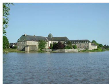
Vue générale nord-ouest Phot. Claude Quillivic IVR53_20023512719NUCA
