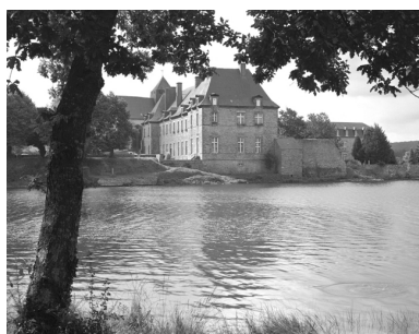
Vue générale prise de l'étang vers le sud-ouest Phot. Norbert Lambart IVR53_19823500509X
