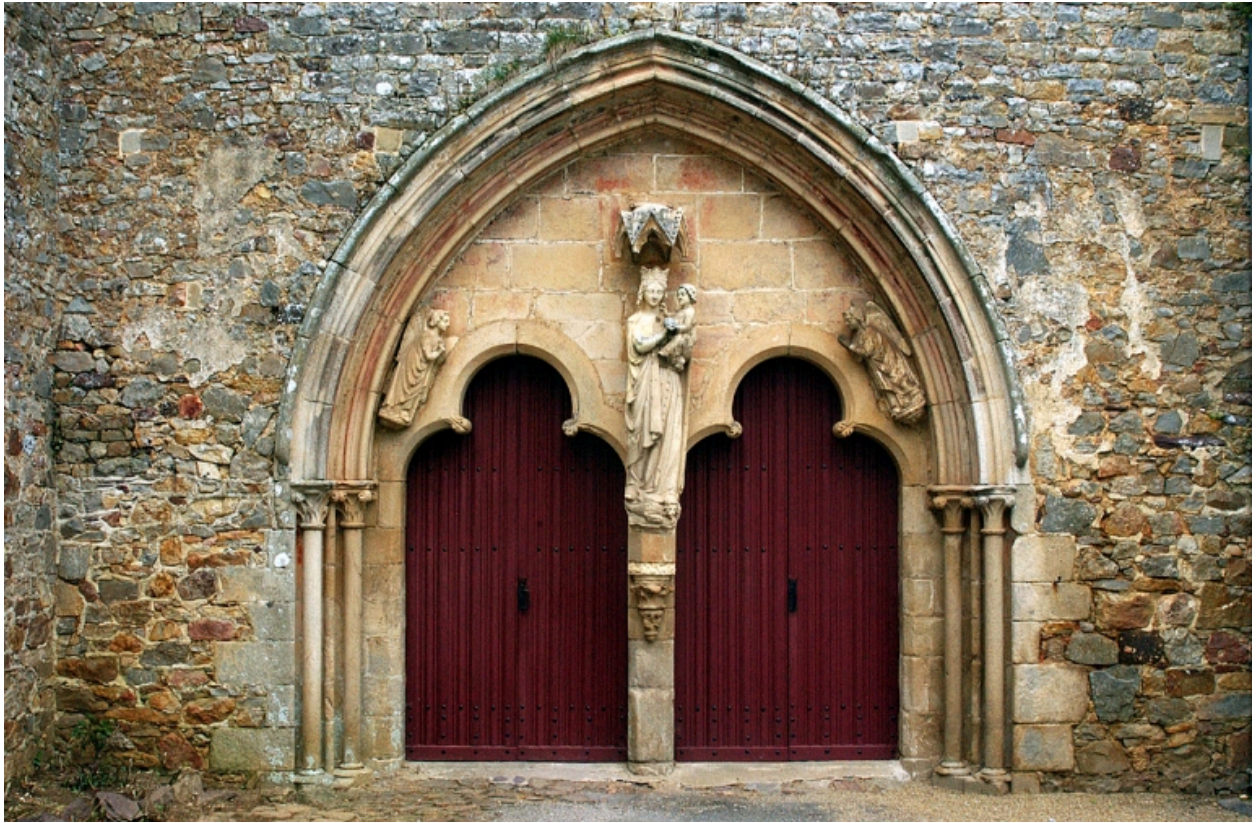
Eglise ; portail ouest
