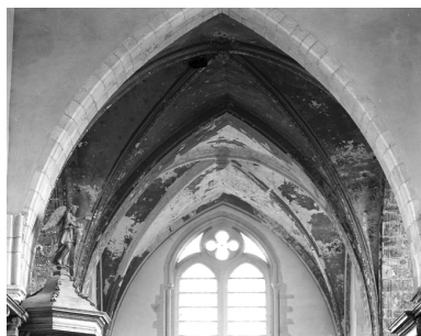
Eglise abbatiale ; vue intérieure : voûtes du chœur Phot. Norbert Lambart IVR53_19823500561X
