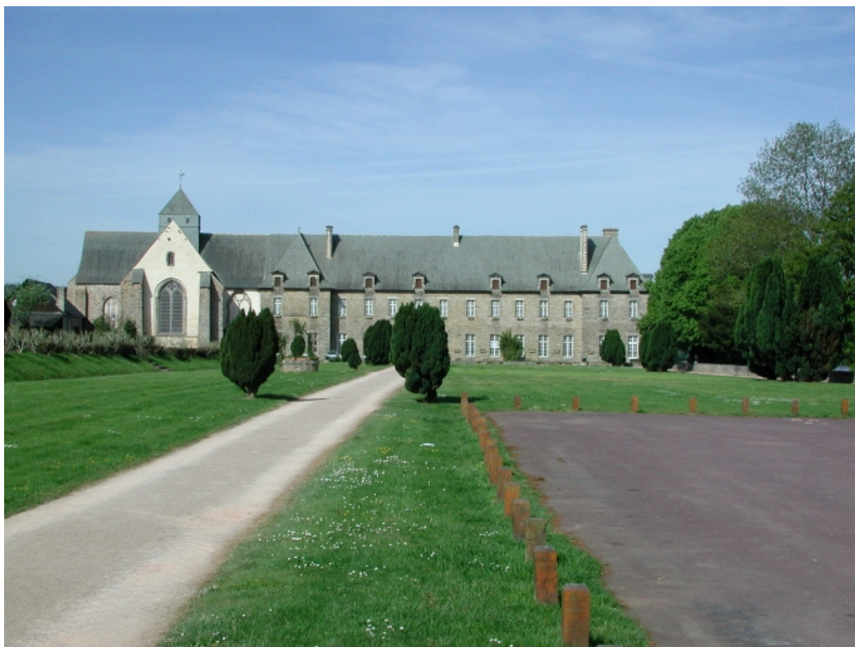
Vue générale est
