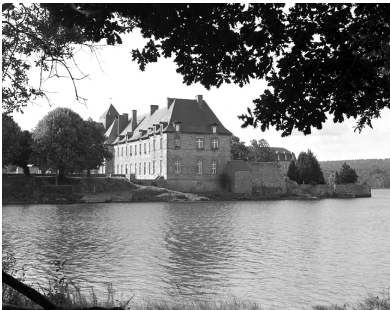
Vue générale prise de l'étang vers le sud-ouest
