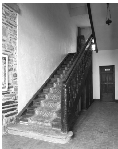
Ancien bâtiment claustral ; vue intérieure : escalier nord Phot. Norbert Lambart IVR53_19823500636X
