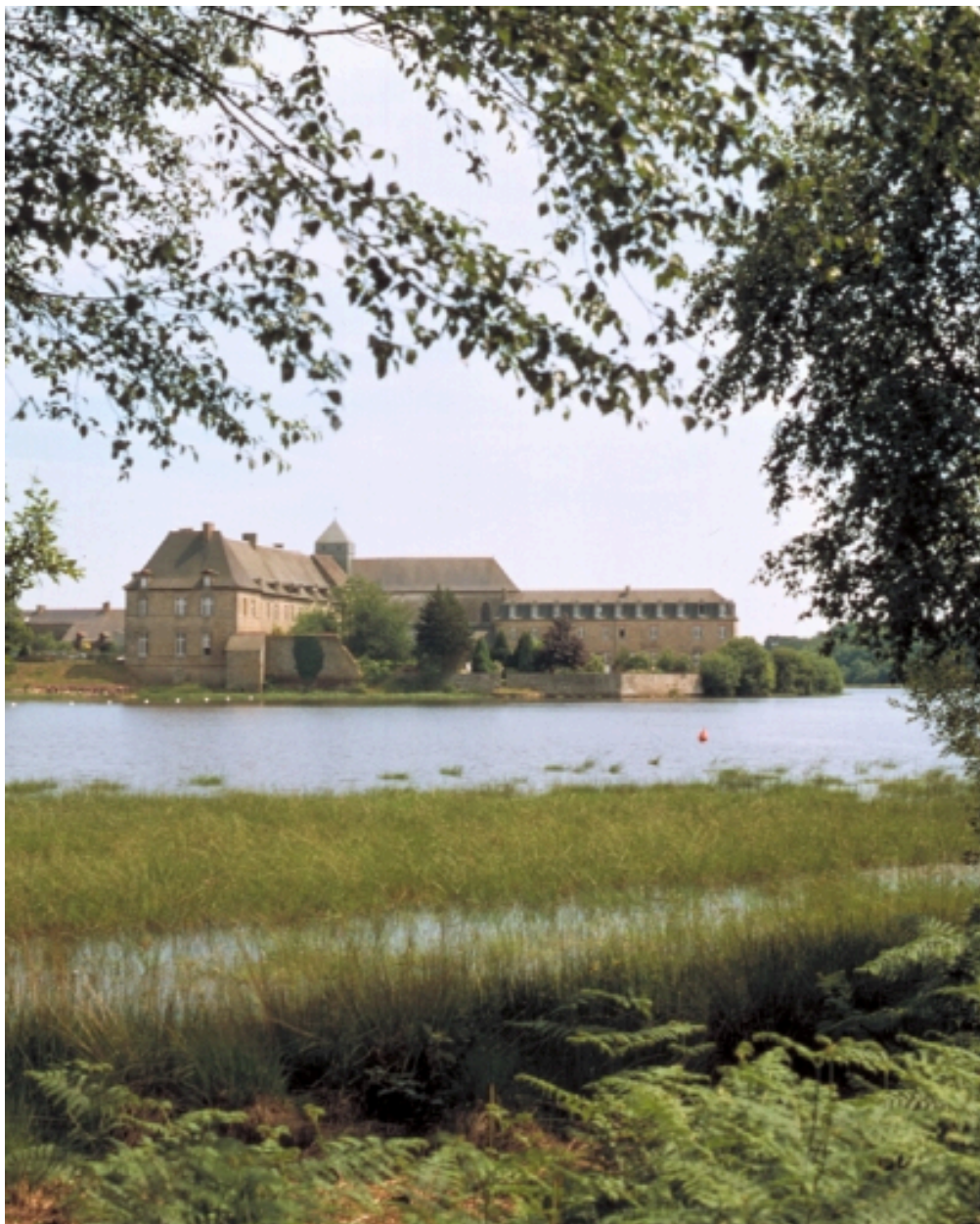
Vue de situation nord
