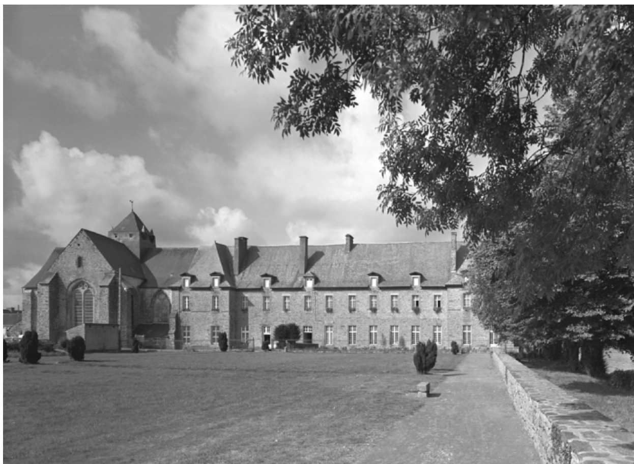
Vue générale prise vers l'ouest
