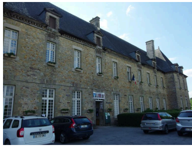
Vue partielle sud-est du grand logis 2018 Phot. Laurence Marquet IVR53_20183507168NUCA
