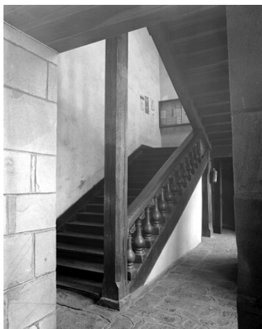
Ancien bâtiment claustral ; vue intérieure : départ d'escalier Phot. Norbert Lambart IVR53_19823500632V
