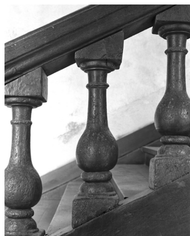
Ancien bâtiment claustral ; vue intérieure : escalier, balustres Phot. Norbert Lambart IVR53_19823500633X
