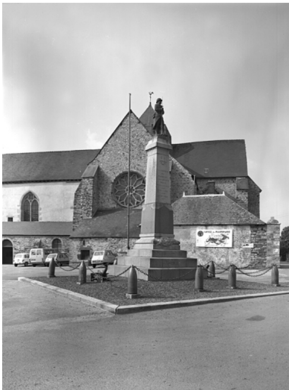
Eglise ; transept sud, vue de situation
