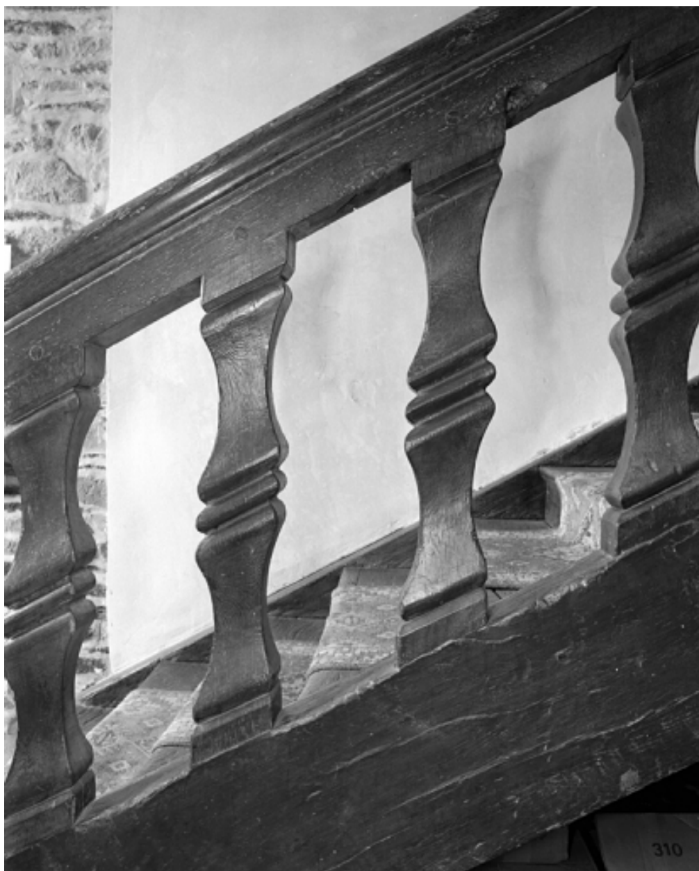
Ancien bâtiment claustral ; vue intérieure : escalier nord, balustres
