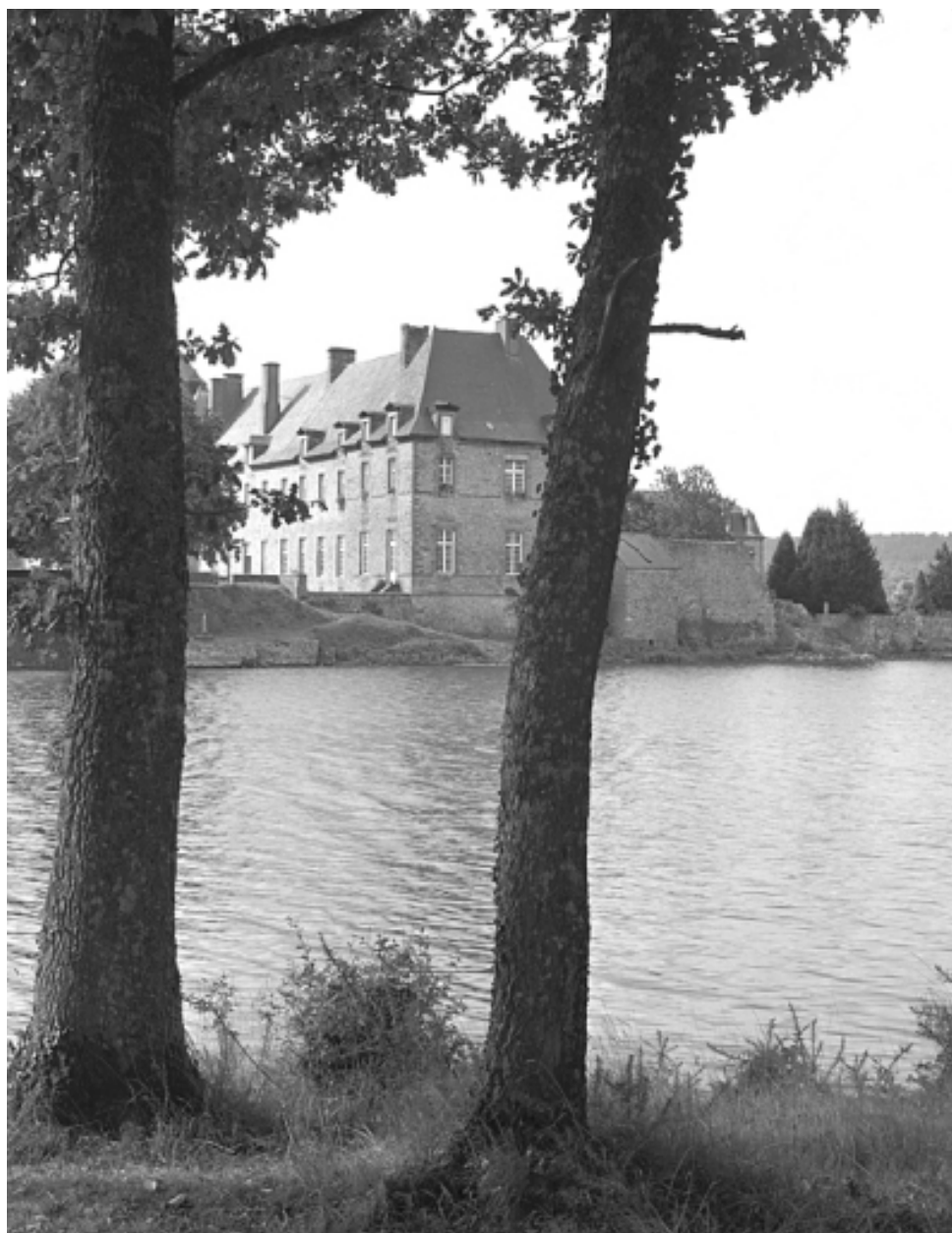
Vue générale prise de l'étang vers le sud-ouest
