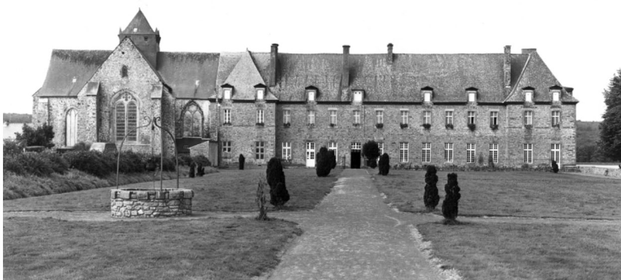
Vue générale prise vers l'ouest
