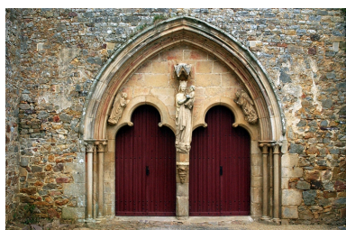
Eglise ; portail ouest Phot. Norbert Lambart IVR53_20023502924NUCA
