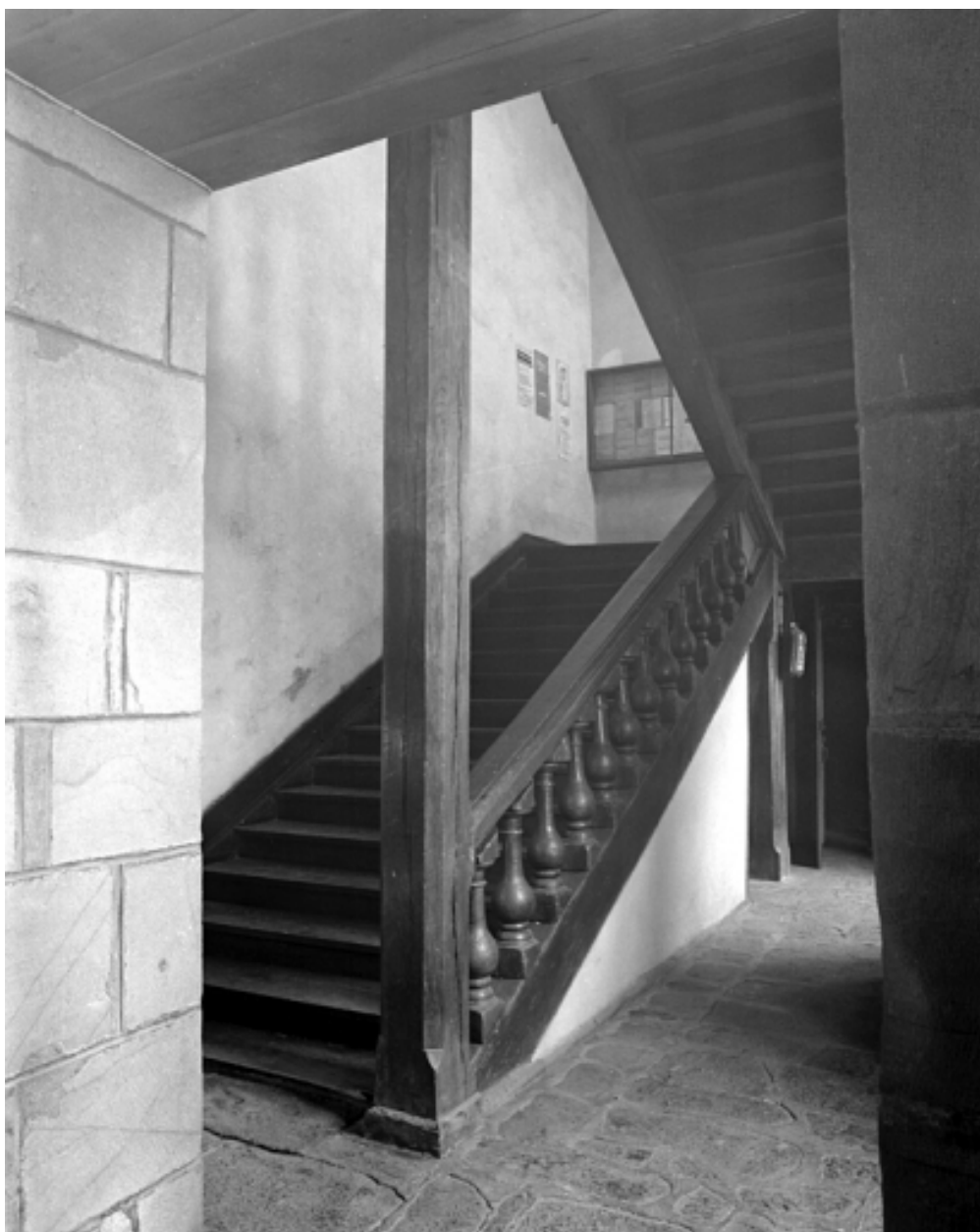
Ancien bâtiment claustral ; vue intérieure : départ d'escalier
