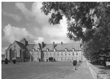
Vue générale prise vers l'ouest Phot. Norbert Lambart IVR53_19823500518V
