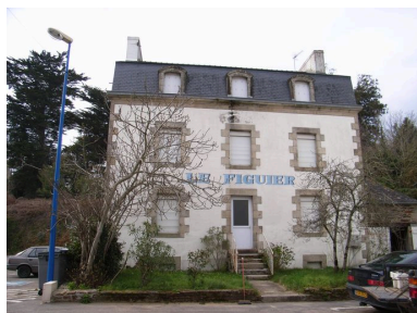
Vue générale de la maison Le Figuier Phot. Florence Despretz IVR53_20072909110NUCA
