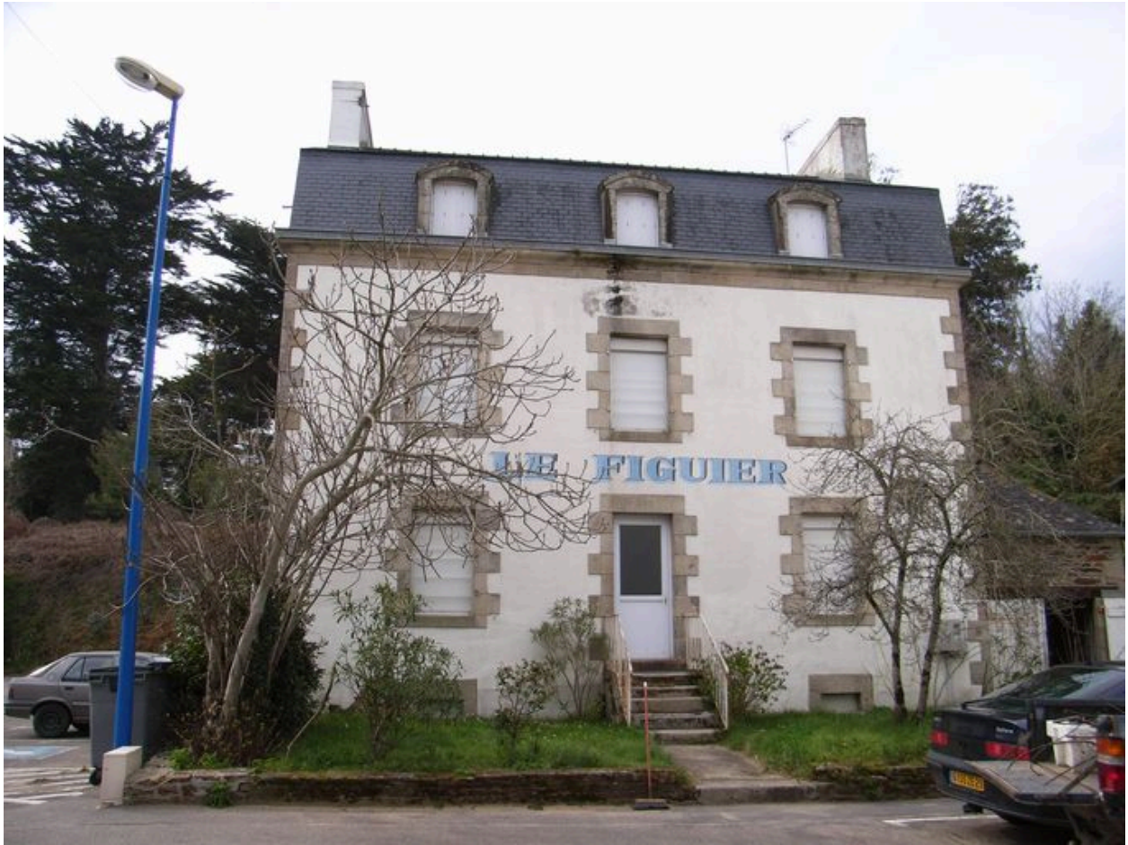
Vue générale de la maison Le Figuier
