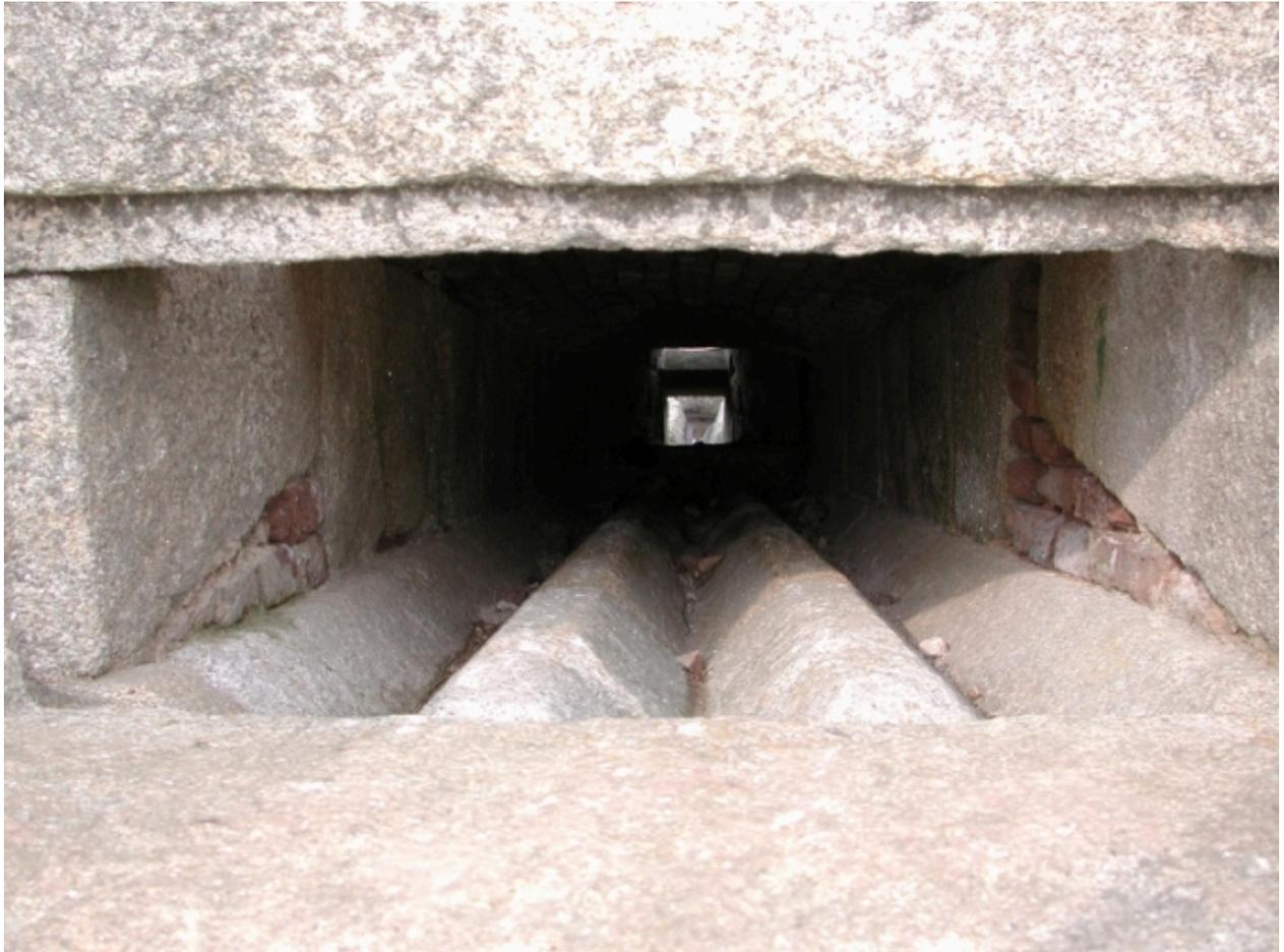
Vue intérieure : ouverture de chargement des boulets dans les trois rainures inclinées en granite (état en 2004). Les rainures guidaient les boulets vers le foyer
