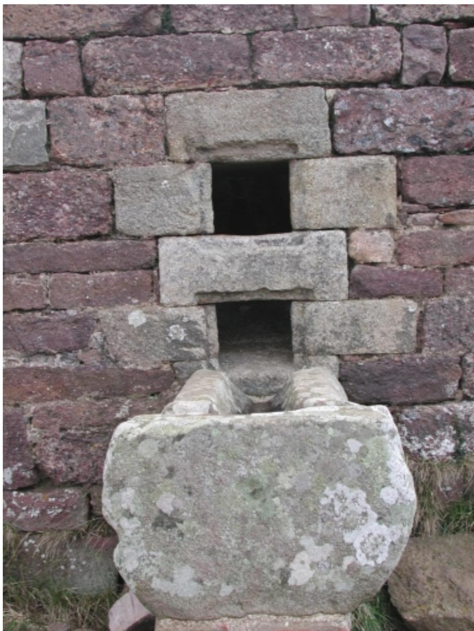
Vue de détail de l'élévation nord : regard de contrôle (en haut) et sortie des boulets (état en 2004). La goulotte de réception remploie le fût en granite d'une croix
