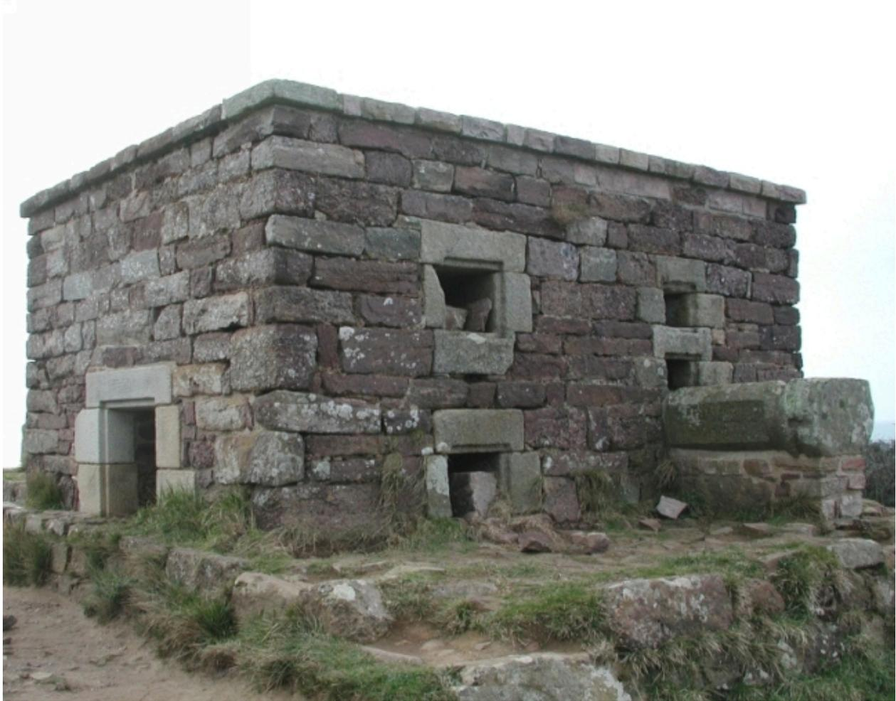
Vue de l'élévation nord (état en 2004). A gauche, l'élévation est avec la baie donnant sur le cendrier. La goulotte de réception des boulets remploie le fût d'une croix
