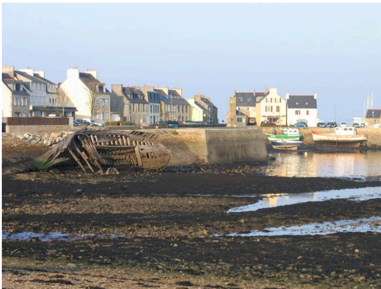
Vue générale du front portuaire du Fret
