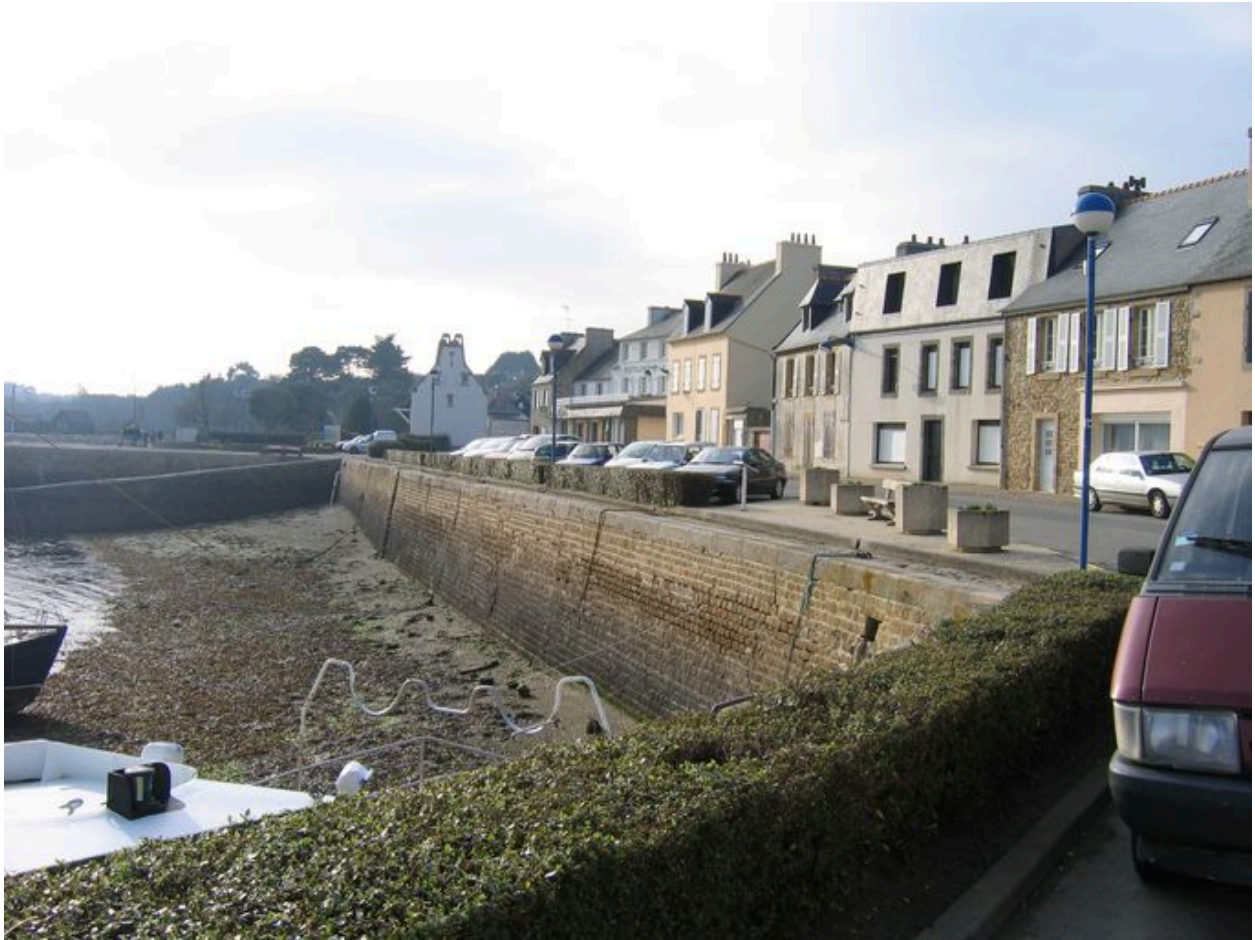
Partie occidentale du front portuaire du Fret
