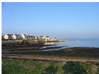
Vue du front portuaire du Fret Phot. Françoise Péron IVR53_20062908550NUCA
