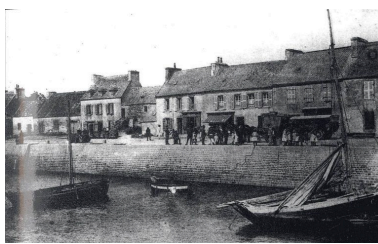
Front portuaire du Fret au début du 20e siècle (?) Repro. Florence Desprez IVR53_20072908854NUC
