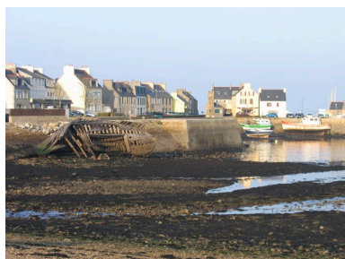
Vue générale du front portuaire du Fret Phot. Françoise Péron IVR53_20062908551NUCA
