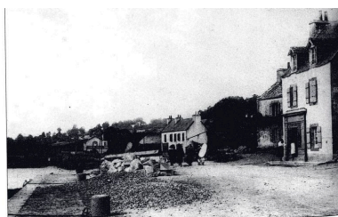
Front portuaire du Fret au début du 20e siècle (?) Repro. Florence Desprez IVR53_20072908853NUC
