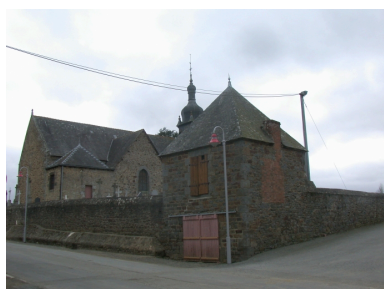
Pavillon Nord-Est, vue générale arrière Phot. Véronique Orain IVR53_20063509580NUCA
