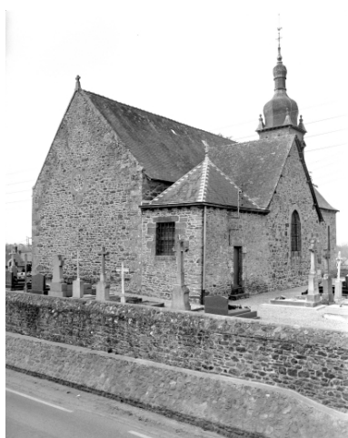
Élévation Est : vue générale Phot. Guy Artur, Phot. Norbert Lambart IVR53_19943500743X
