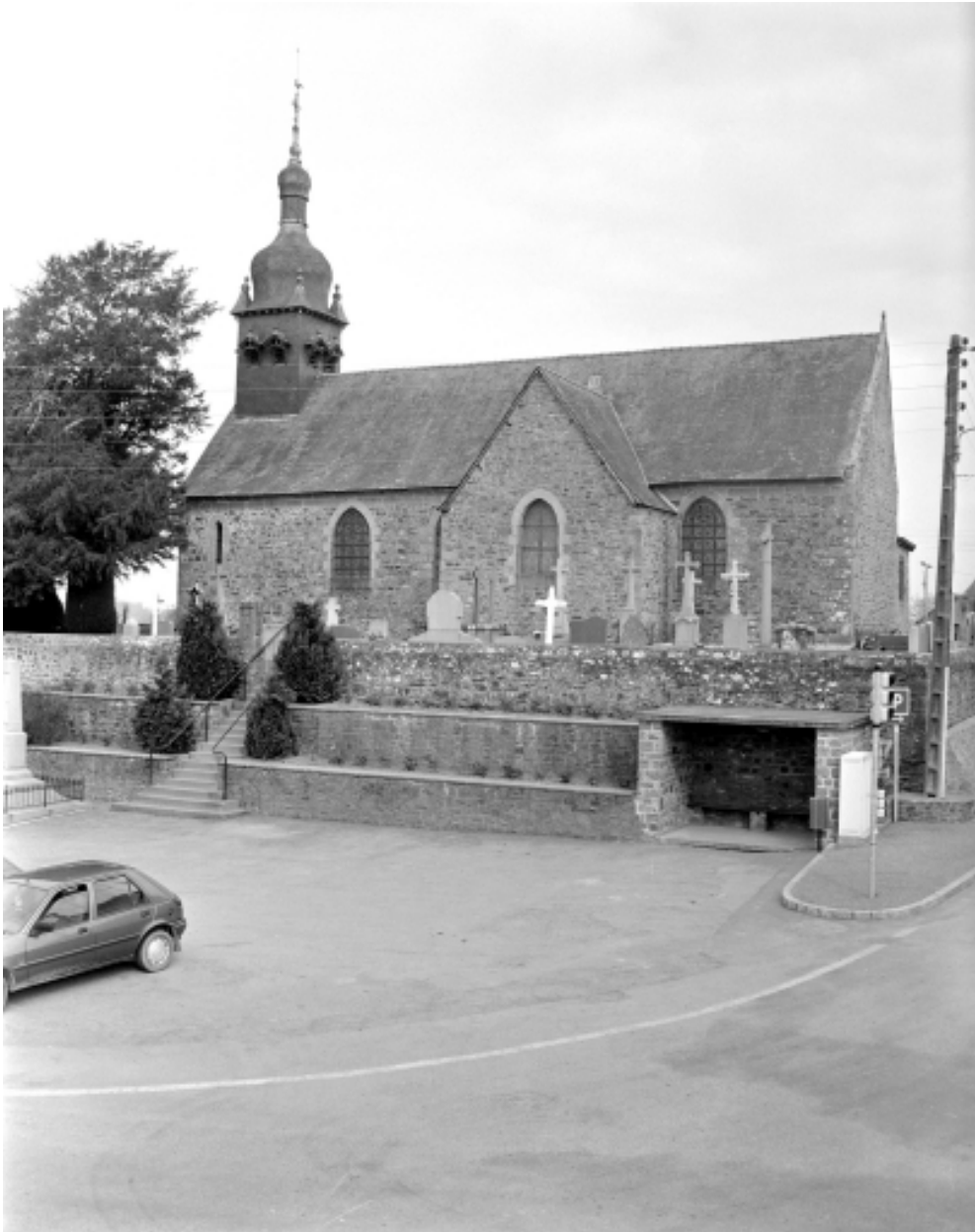
Elévation Sud : vue générale
