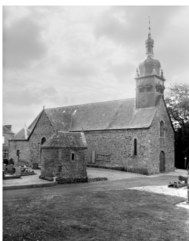
Élévation Nord-Ouest : vue générale Phot. Guy Artur, Phot. Norbert Lambart IVR53_19943500742X
