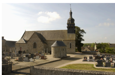
Façade Nord, vue générale actuelle Phot. Norbert Lambart IVR53_20063501063NUCA
