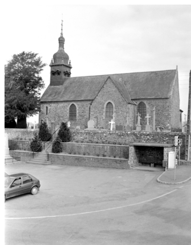
Élévation Sud : vue générale Phot. Guy Artur, Phot. Norbert Lambart IVR53_19943500744X
