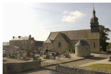
Façade Nord, vue générale actuelle Phot. Norbert Lambart IVR53_20063501062NUCA
