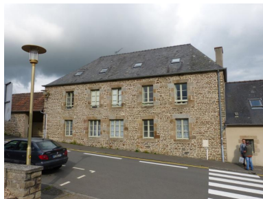
Ancienne gendarmerie à pied et à cheval - Façade ouest Phot. Marquet Laurence IVR53_20233530324NUCA
