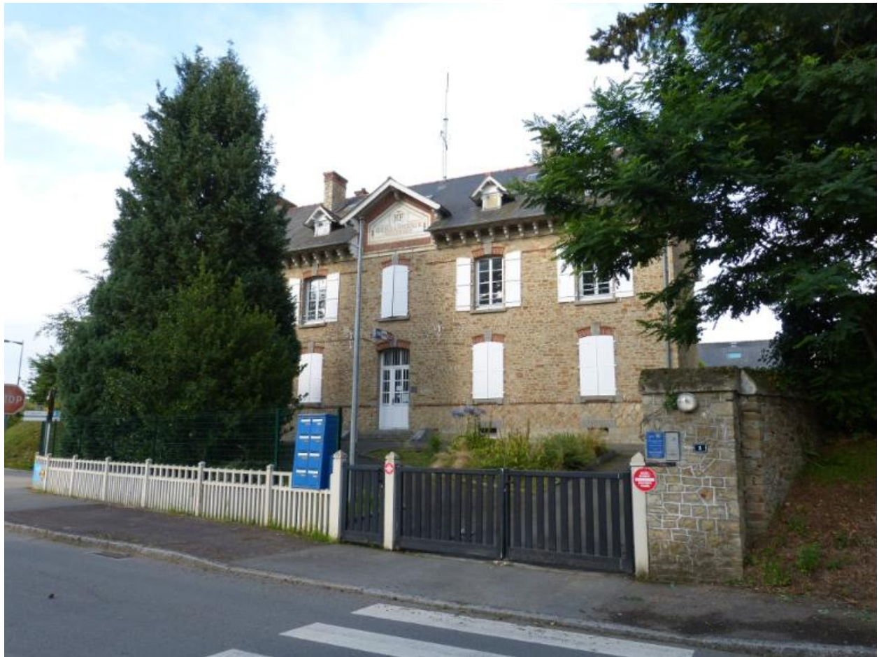
Vue générale de la façade ouest de l'ancienne gendarmerie, rue de Bretagne
