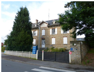
Vue générale de la façade ouest de l'ancienne gendarmerie, rue de Bretagne Phot. Marquet Laurence
