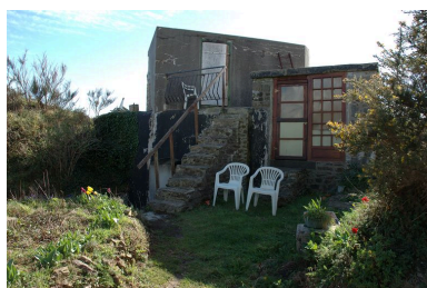
Vue du poste d'observation ouest : la cuve est en maçonnerie avec dalle de couverture en béton (état en 2007)
