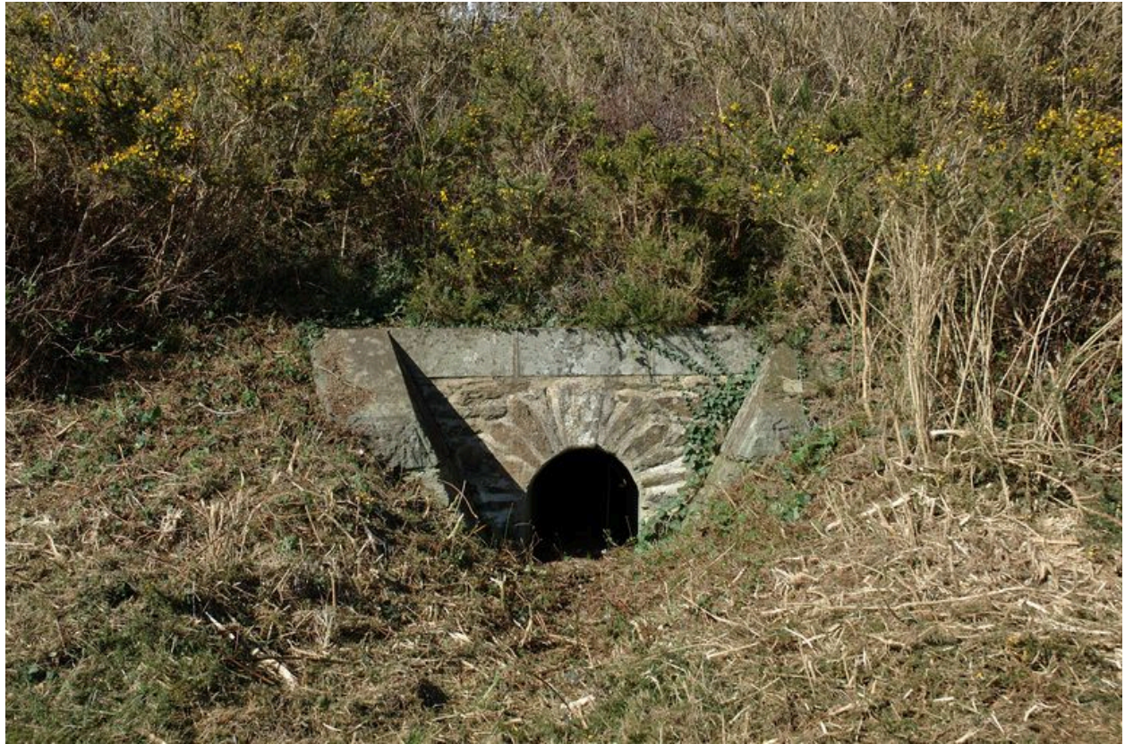
Vue de l'égout central en maçonnerie pour l'évacuation des eaux pluviales de la batterie (état en 2007)
