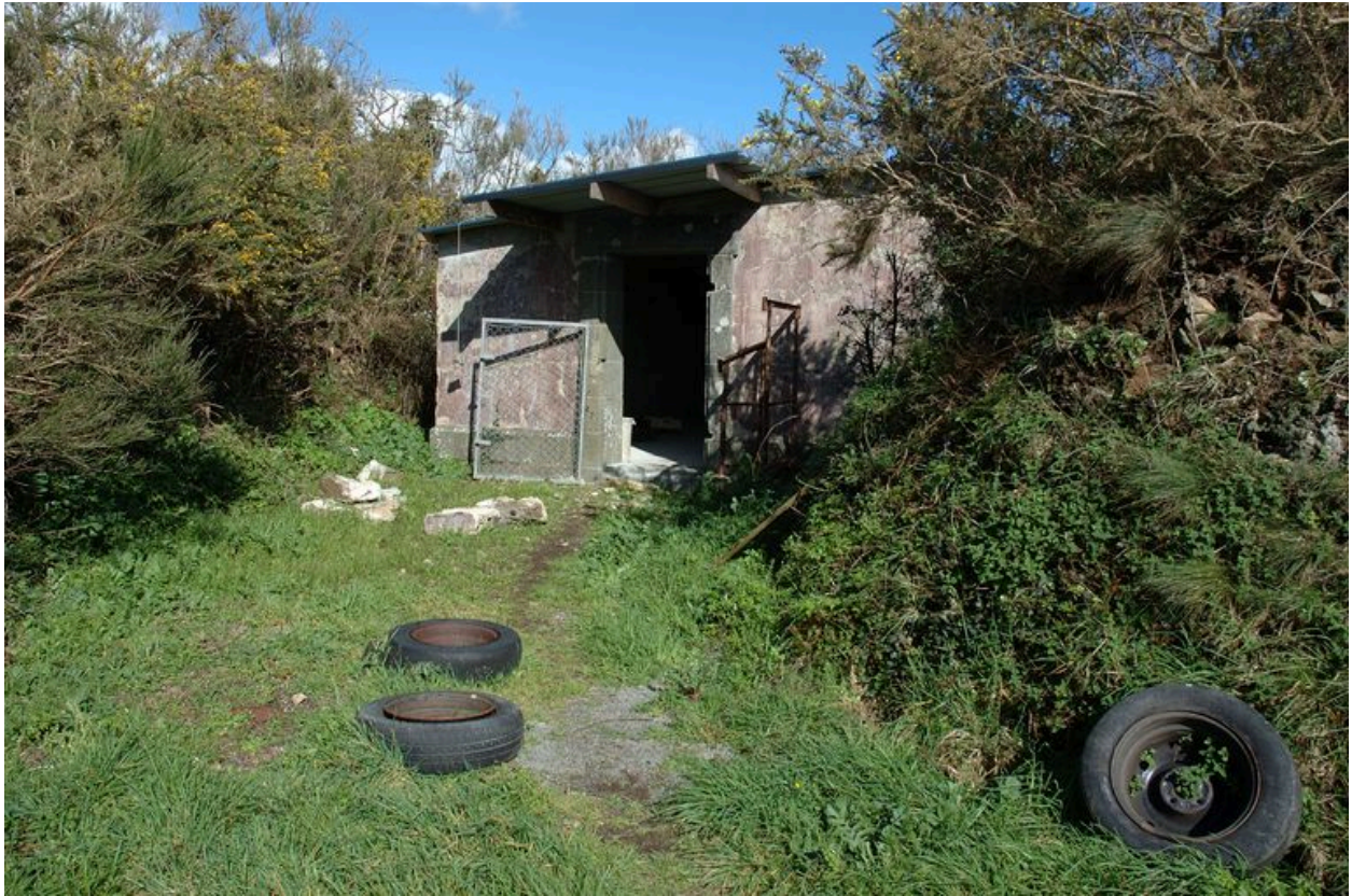
Vue du magasin aux projectiles monté en maçonnerie enduite (état en 2007). Il a perdu sa couverture d'origine
