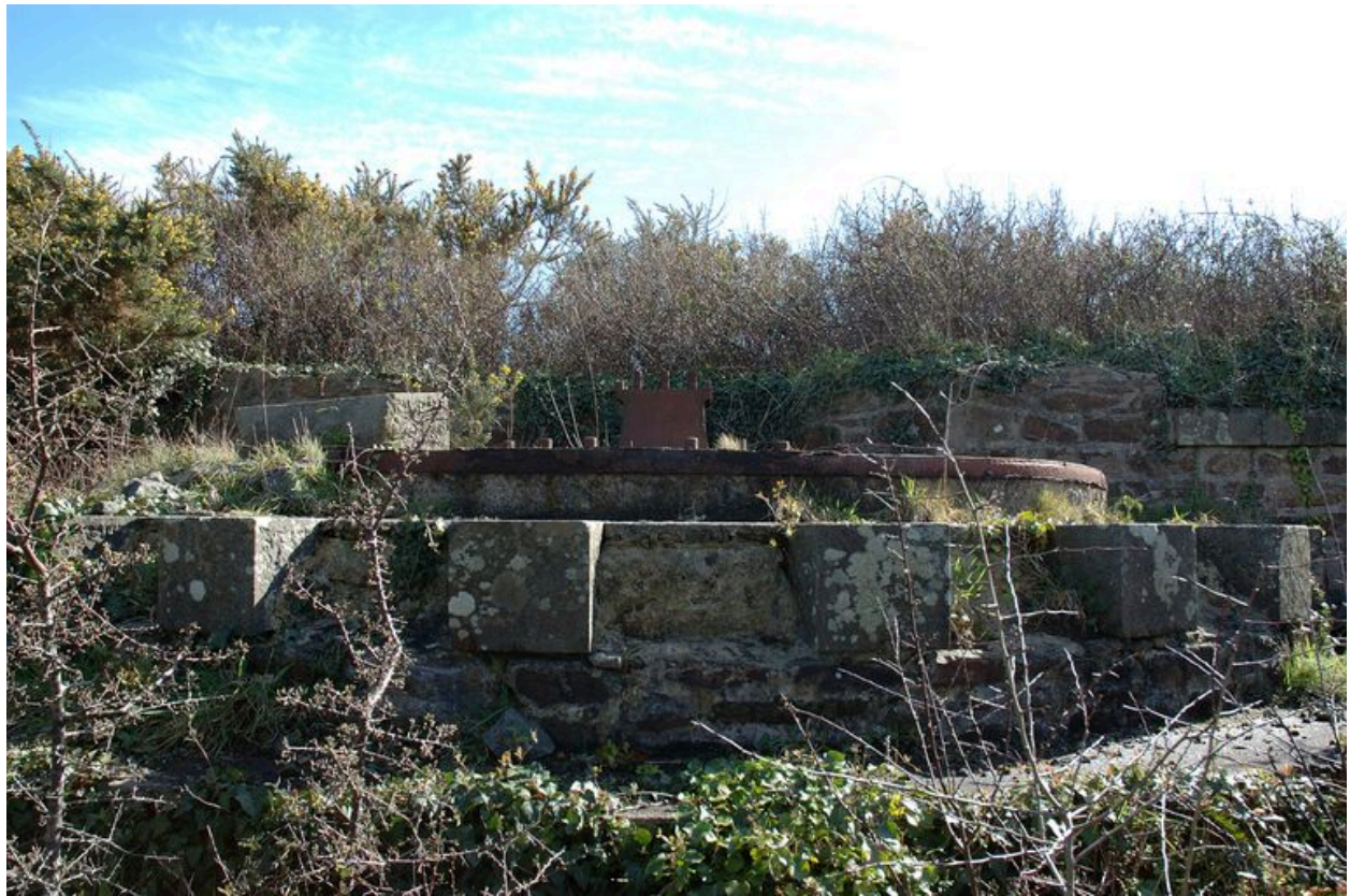
Vue de l'une des six plate-formes de tir : sous-sellette d'affût (état en 2007)
