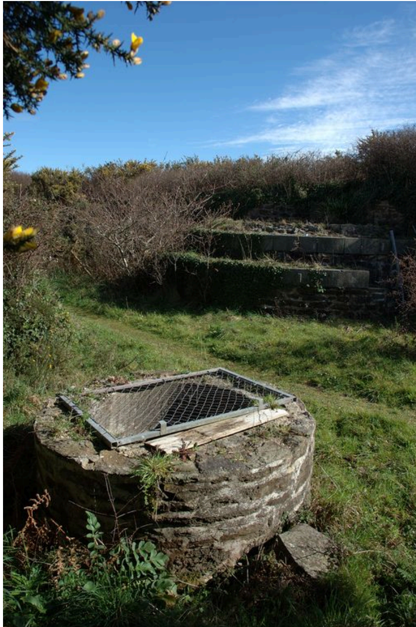
Vue du puits de la batterie situé en arrière des six plate-formes de tir (état en 2007)
