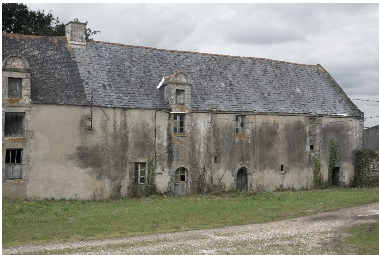
Vue de détail de la façade est des communs
