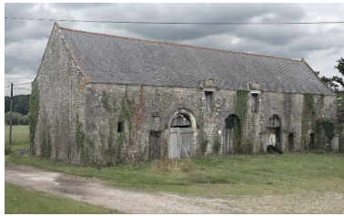
Vue sud-ouest des communs du château Phot. Bernard Bègne IVR53_20165600097NUCA
