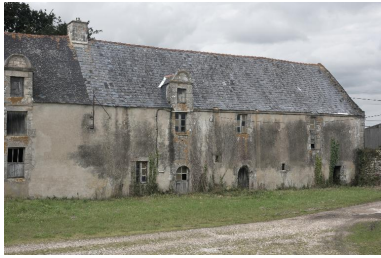
Vue de détail de la façade est des communs Phot. Bernard Bègne IVR53_20165600093NUCA
