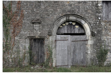
Vue de détail des ouvertures des communs du château Phot. Bernard Bègne IVR53_20165600095NUCA
