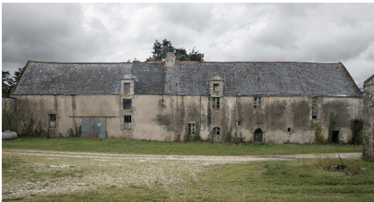
Vue de la façade est des communs
