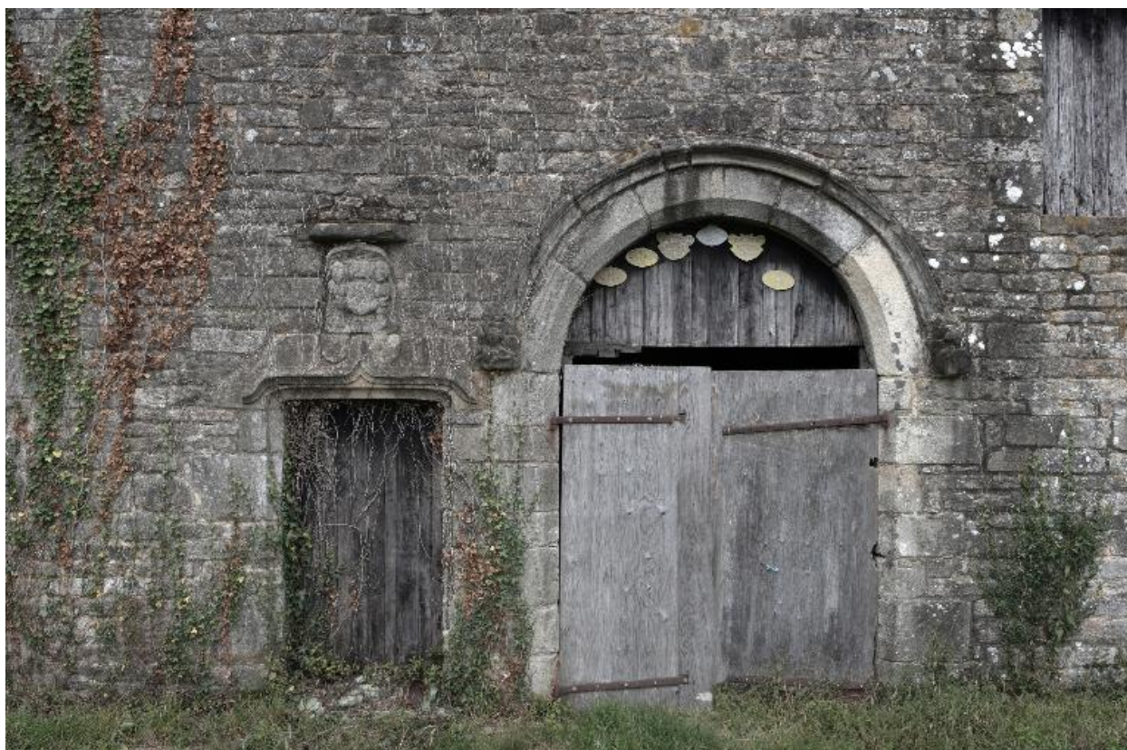
Vue de détail des ouvertures des communs du château
