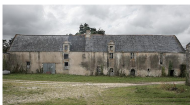
Vue de la façade est des communs Phot. Bernard Bègne IVR53_20165600091NUCA
