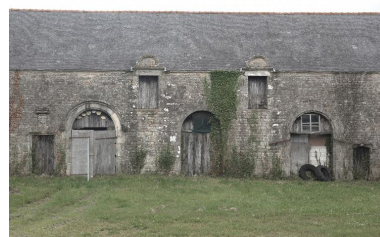
Vue de détail de la façade sud des communs
