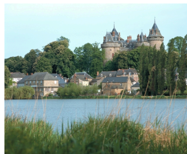
Vue de situation sud
