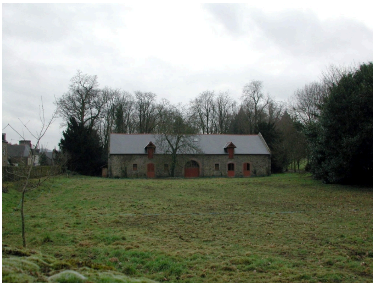
Communs, vue générale nord
