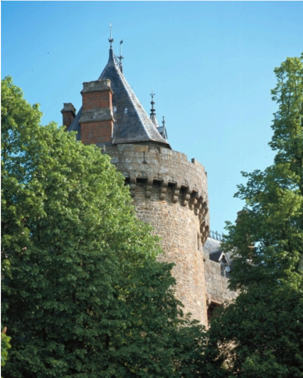
Vue partielle de la tour sud
