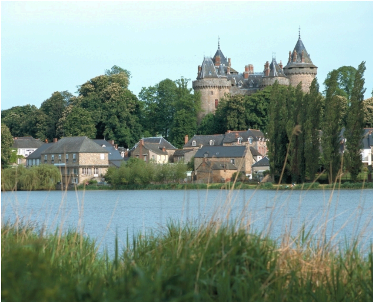
Vue de situation sud
