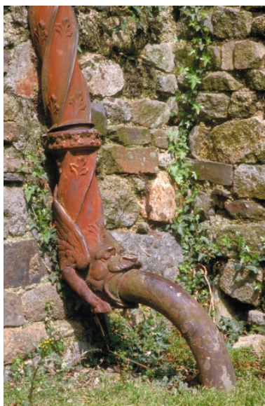
Détail ; descente de gouttière Phot. Claude Quillivic IVR53_19943502550ZA
