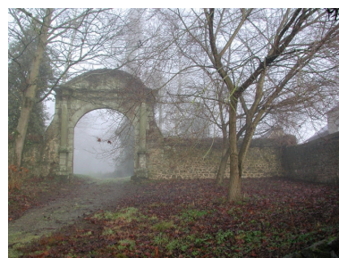
Portail dans le parc Phot. Elise Lauranceau IVR53_20023507856NUCA
