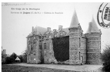
Elévations latérale et postérieure Phot. Elise Lauranceau IVR53_20042209051NUCB
