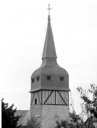
Elévation ouest : partie haute du clocher Phot. Guy Artur, Phot. Norbert Lambart IVR53_19943501772X
