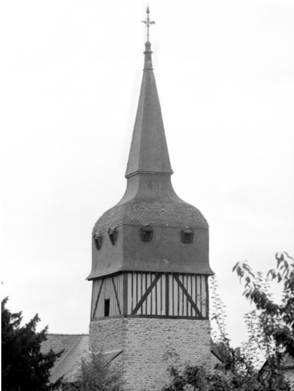
Elévation ouest : partie haute du clocher
