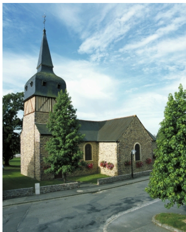
Vue générale nord-est Phot. Norbert Lambart IVR53_20023500623XA
