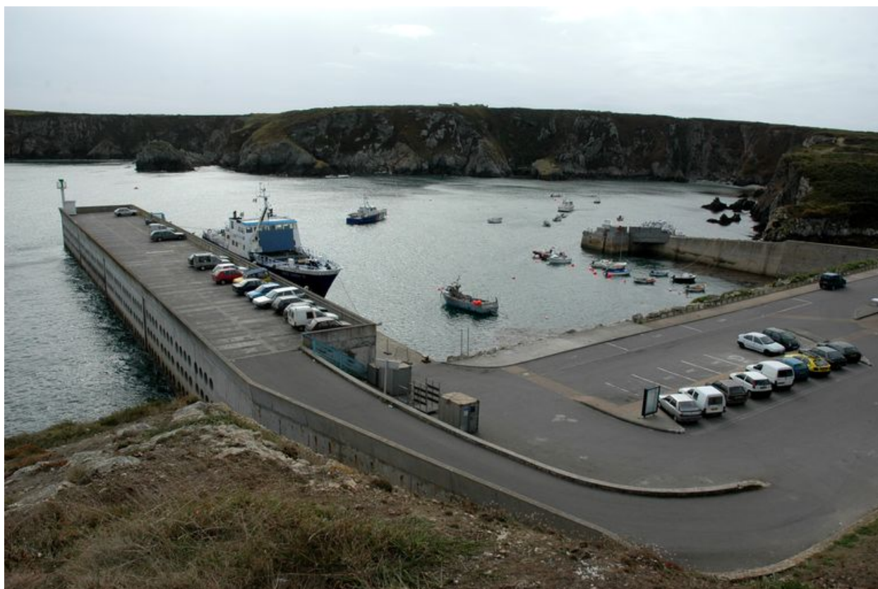
Digue Jarlan, parking et terre-plein
