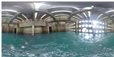
Digue Jarlan, caisson 2, vue à 360° Phot. Région Bretagne IVR53_20212905712NUCA
