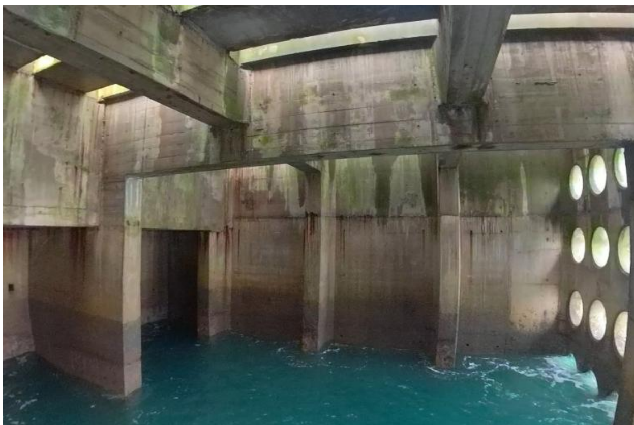
Digue Jarlan, caisson 3, vue intérieure
