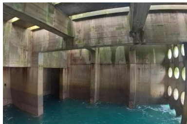
Digue Jarlan, caisson 3, vue intérieure Phot. Région Bretagne IVR53_20212905711NUCA
