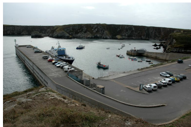
Digue Jarlan, parking et terre-plein Phot. Guillaume Lécueillier IVR53_20062903520NUCA
