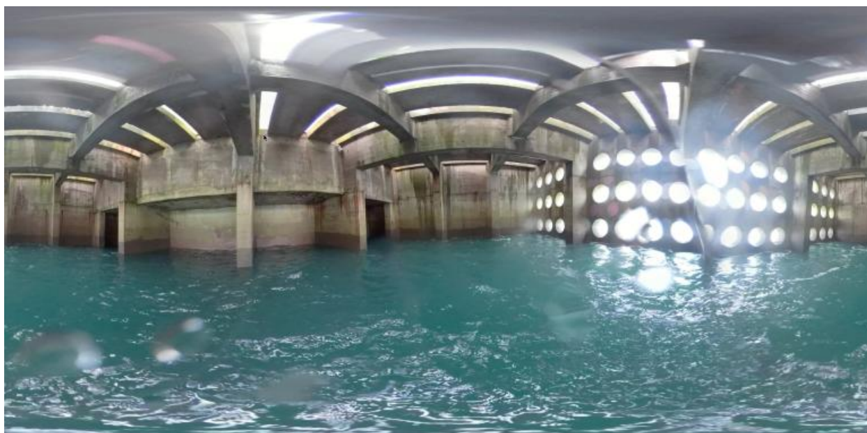
Digue Jarlan, caisson 2, vue à 360°
