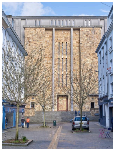
Eglise Saint-Louis, élévation nord Phot. Bernard Bègne IVR53_20202900069NUCA
