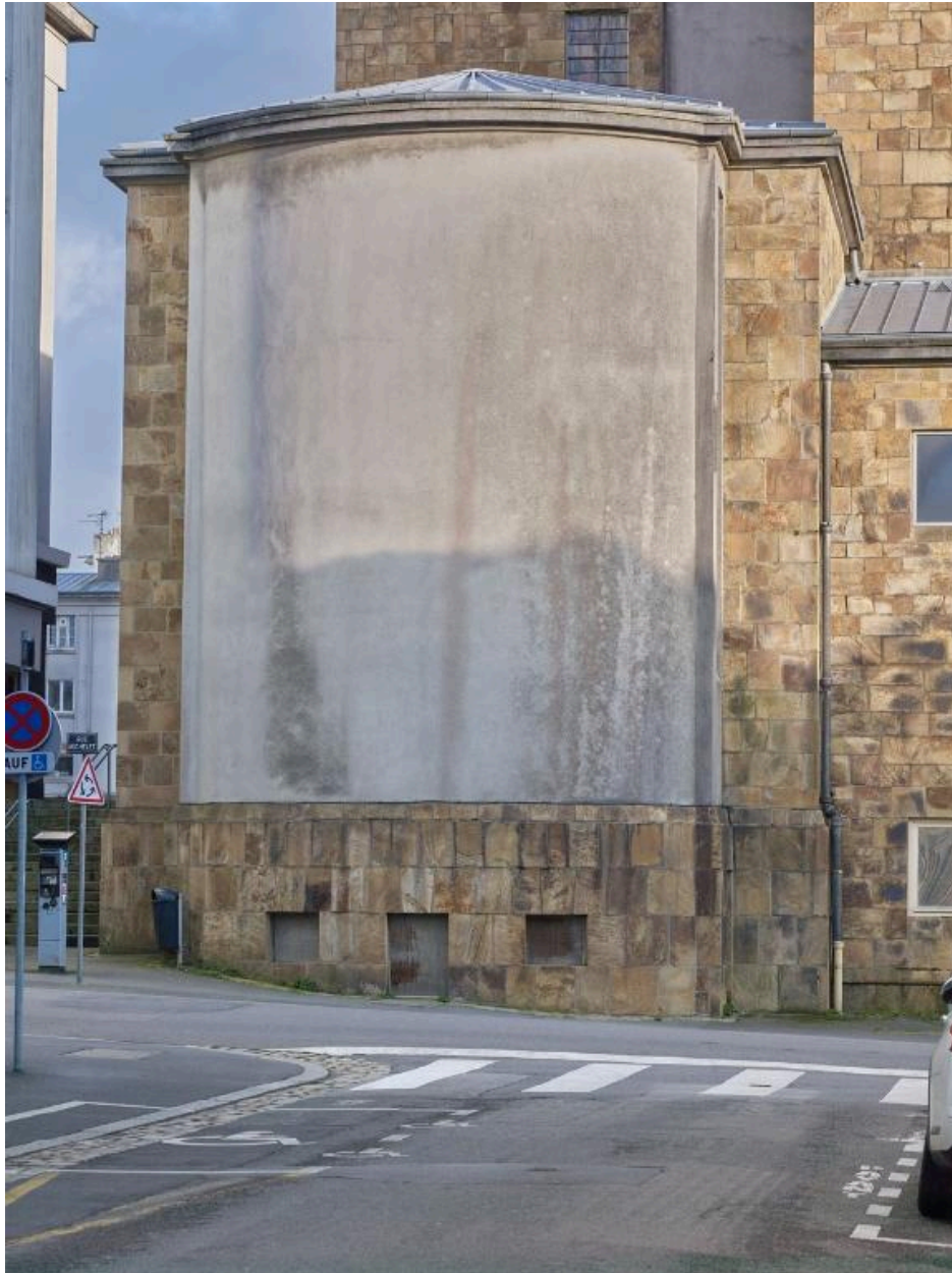
Eglise Saint-Louis, élévation sud, vue rapprochée
