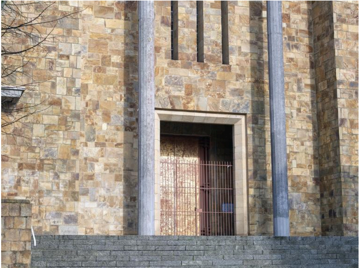
Eglise Saint-Louis, élévation nord
