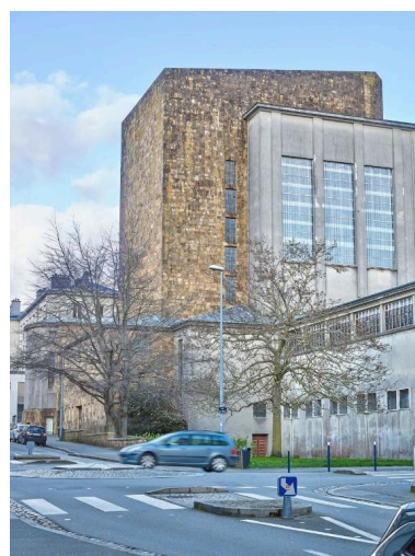
Eglise Saint-Louis, élévation est, matériaux différents (pierre de logonna, béton, verre), fonctions différentes (usage communautaire, fonction religieuse) Phot. Bernard Bègne IVR53_20202900065NUCA
