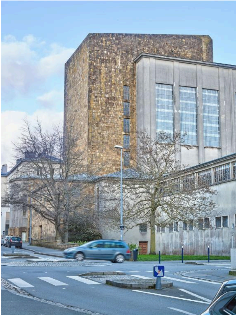
Eglise Saint-Louis, élévation est, matériaux différents (pierre de logonna, béton, verre), fonctions différentes (usage communautaire, fonction religieuse)
