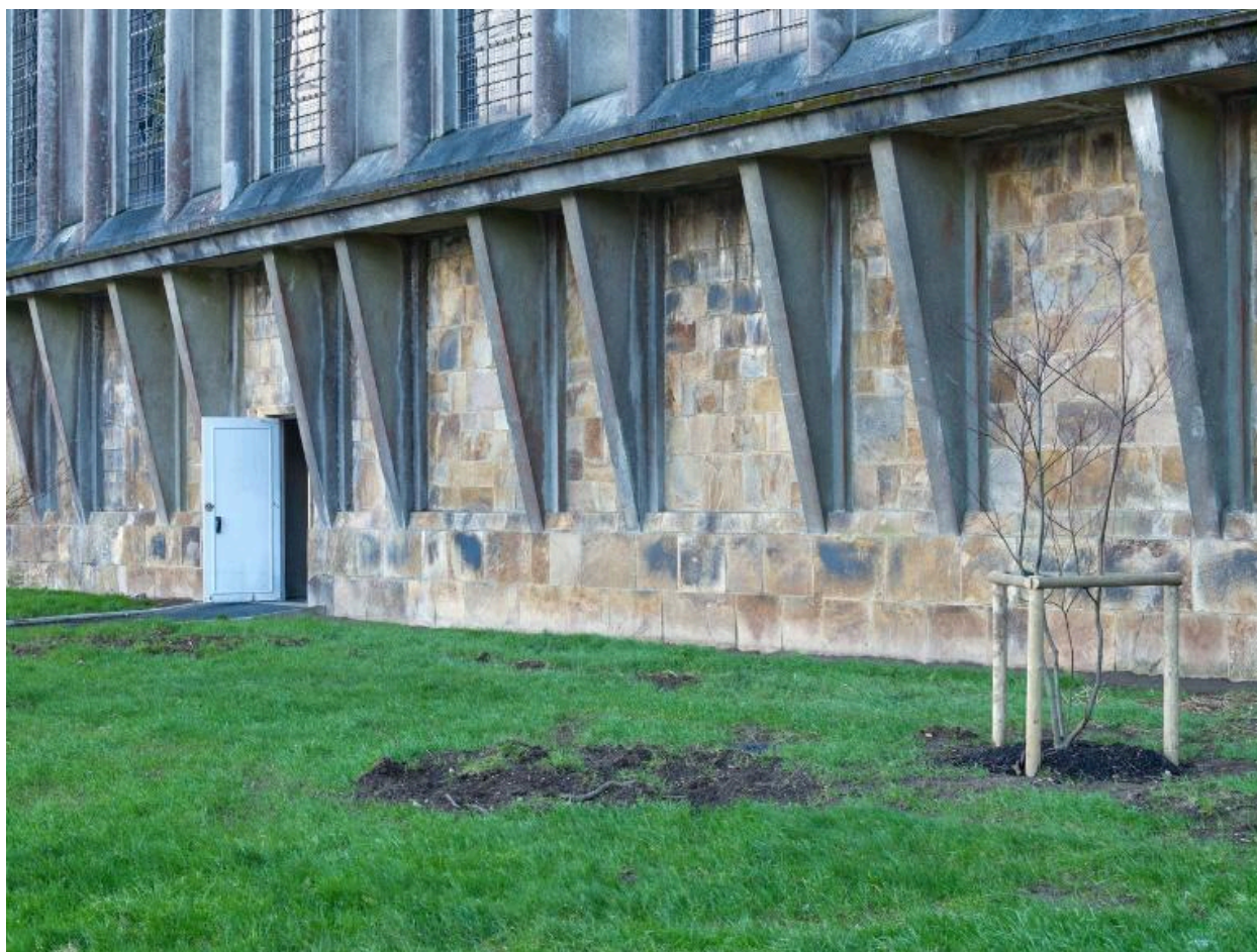
Eglise Saint-Louis, parement en pierre de Logonna, structure béton, mur ouest
