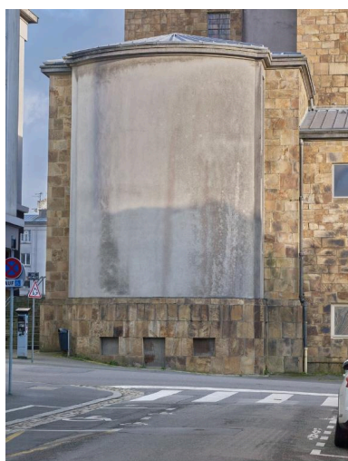
Eglise Saint-Louis, élévation sud, vue rapprochée Phot. Bernard Bègne IVR53_20202900063NUCA
