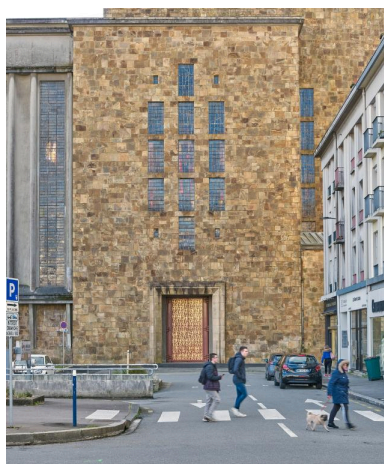
Eglise Saint-Louis, élévation mur ouest, portail ouest Phot. Bernard Bègne IVR53_20202900060NUCA
