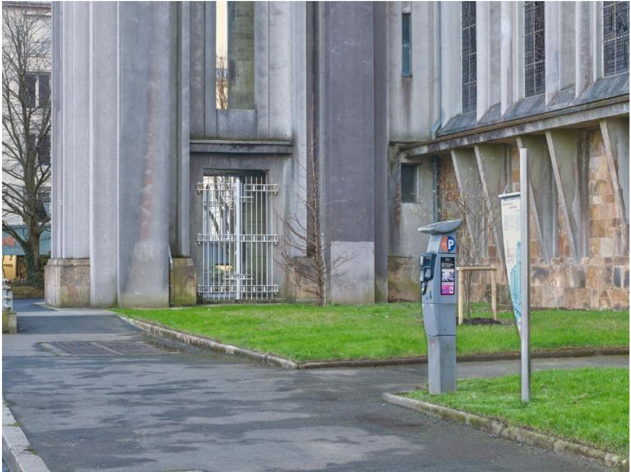
Eglise Saint-Louis, mur ouest
