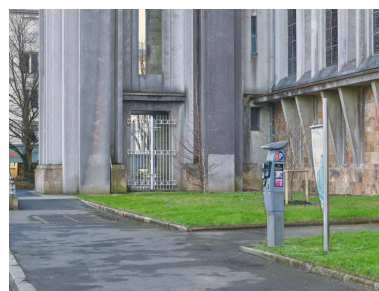
Eglise Saint-Louis, mur ouest Phot. Bernard Bègne IVR53_20202900068NUCA
