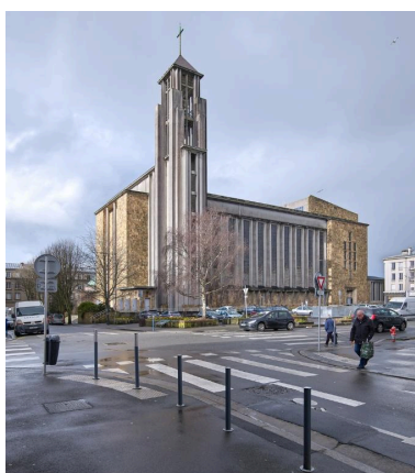
Eglise Saint-Louis, vue générale Phot. Bernard Bègne IVR53_20202900073NUCA
