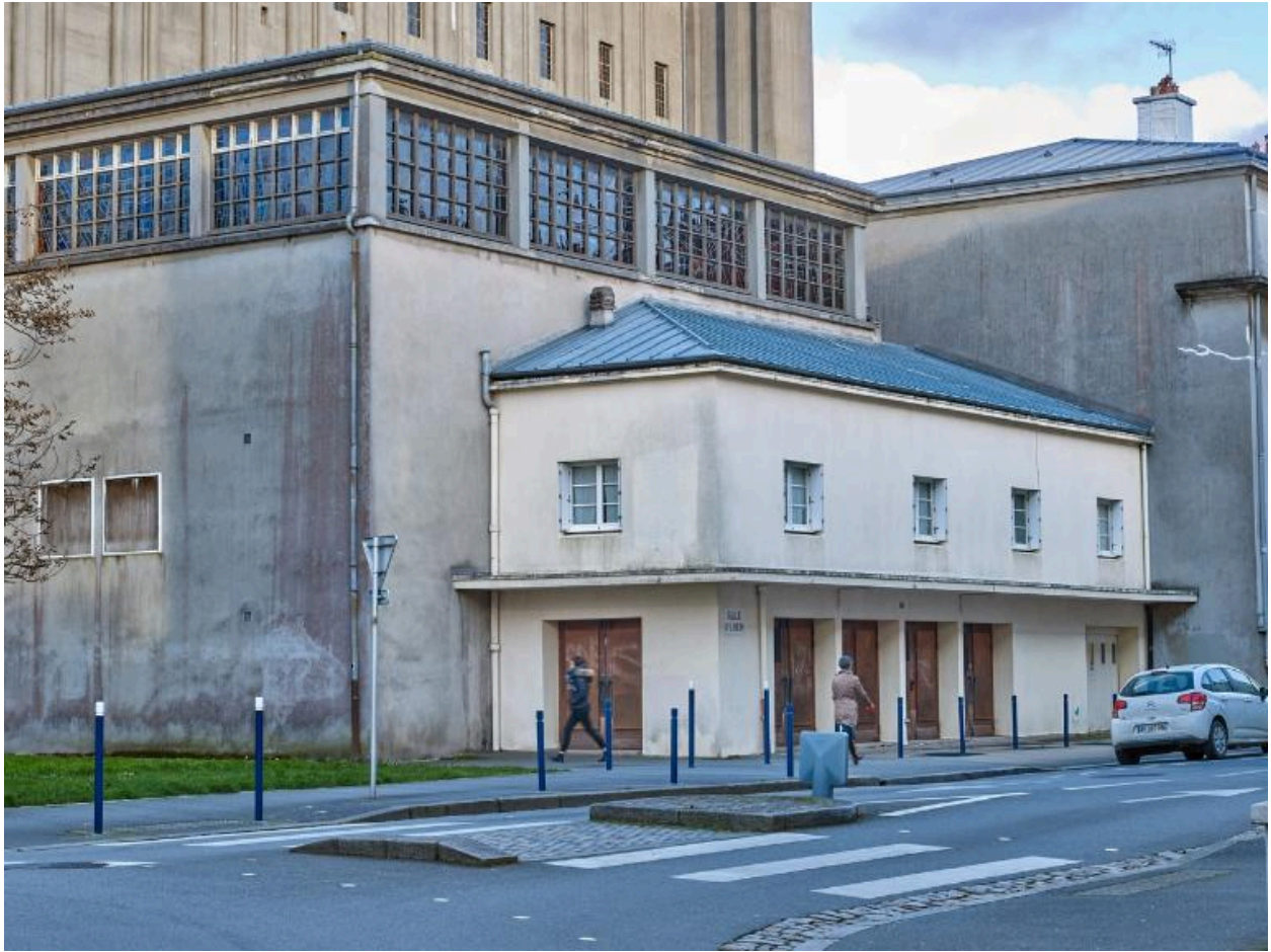
Eglise Saint-Louis, vue depuis l'est, entrée salle paroissiale
