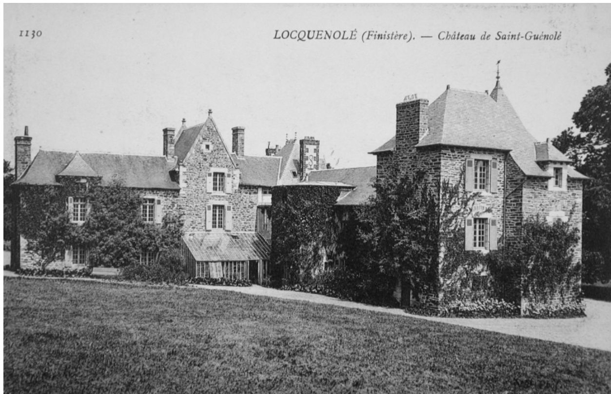
Vue de la façade arrière
