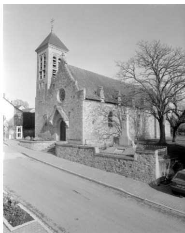
Elévation sud-est : vue générale Phot. Guy Artur, Phot. Norbert Lambart IVR53_19943500770X
