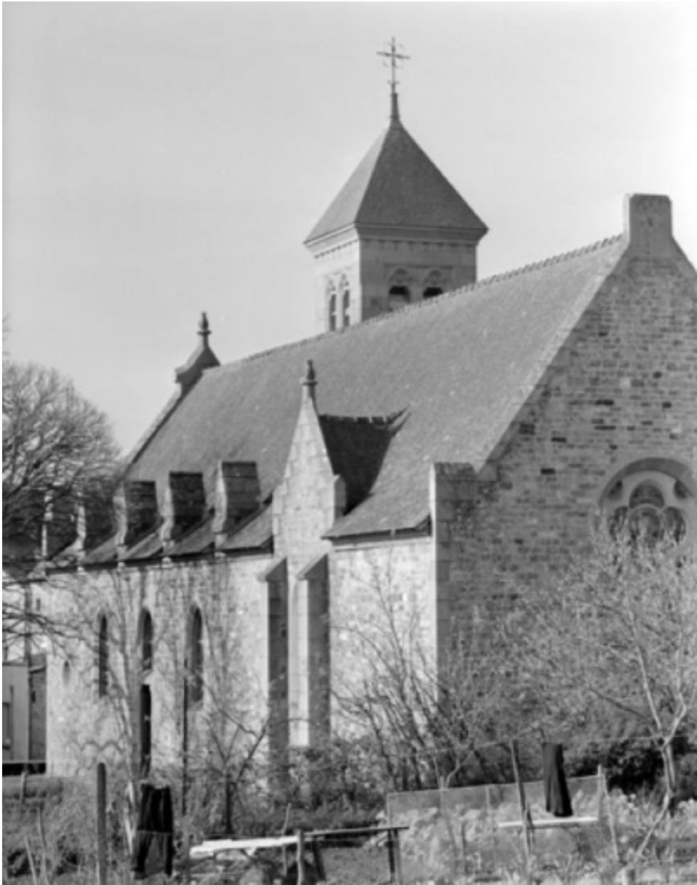
Elévation est : vue générale.
