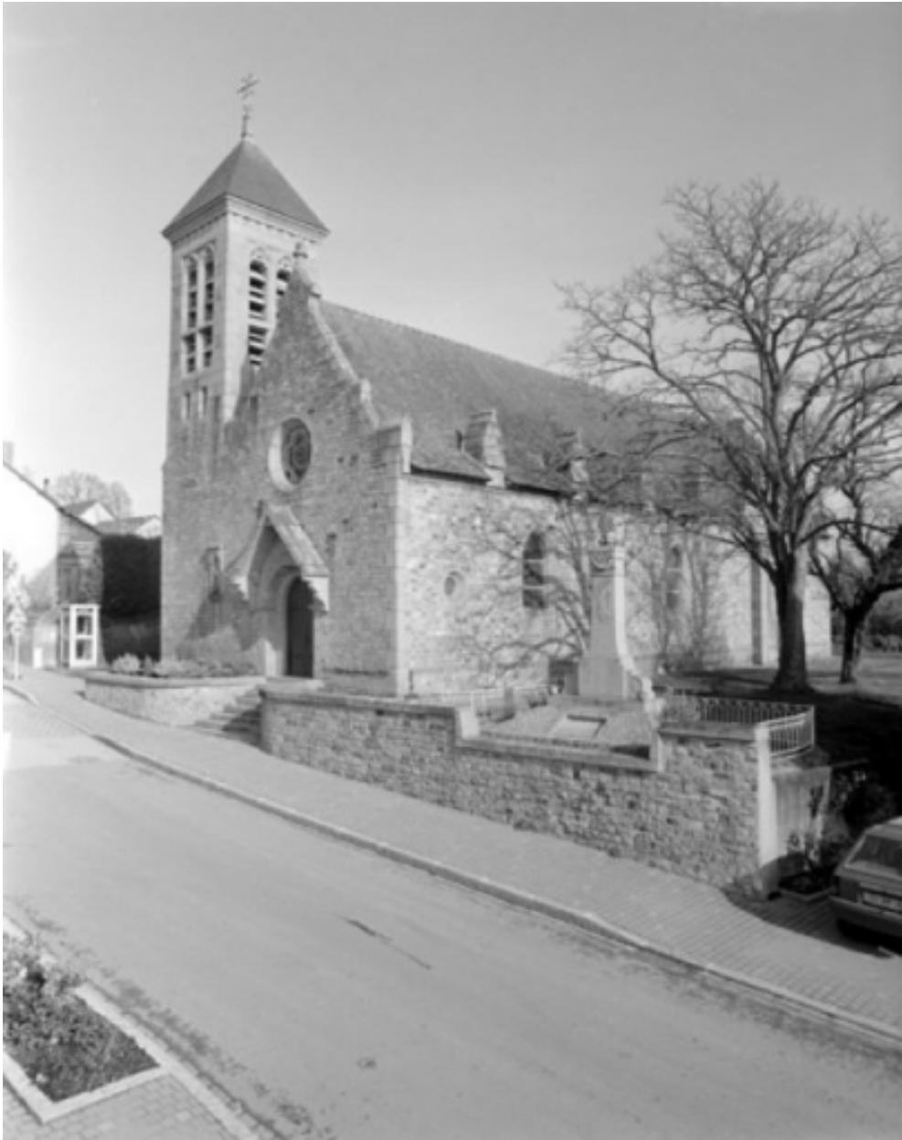
Elévation sud-est : vue générale
