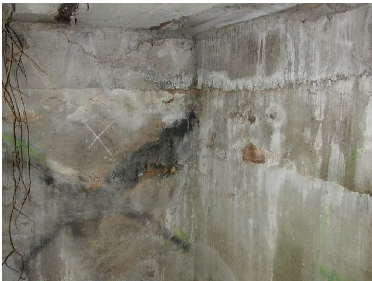
Vue intérieur (état en 2002)
