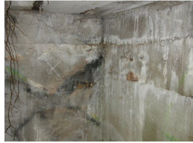
Vue intérieure (état en 2002) Phot. Guillaume Lécuillier IVR53_20022901762NUCA
