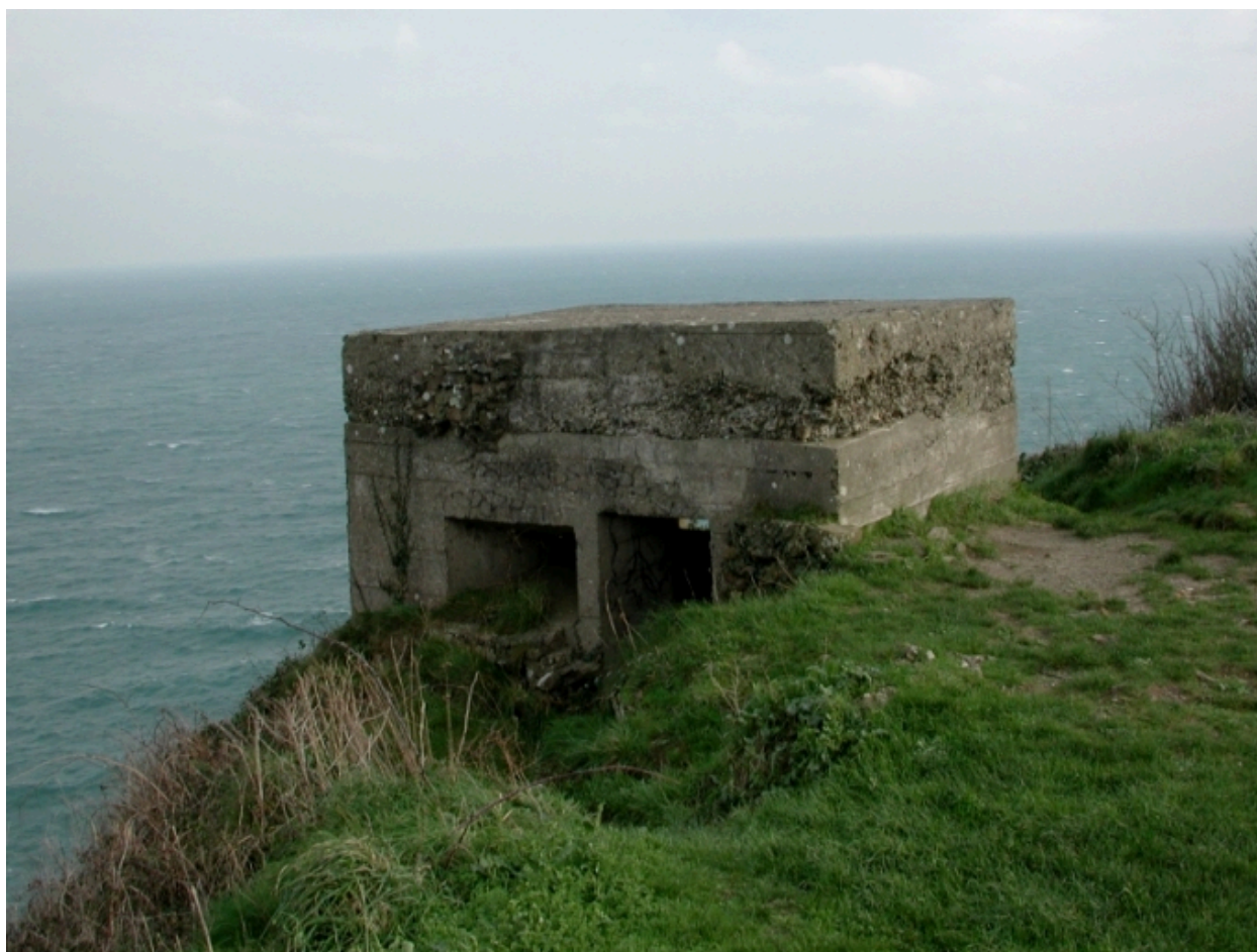
Vue générale du blockhaus côté ouest
