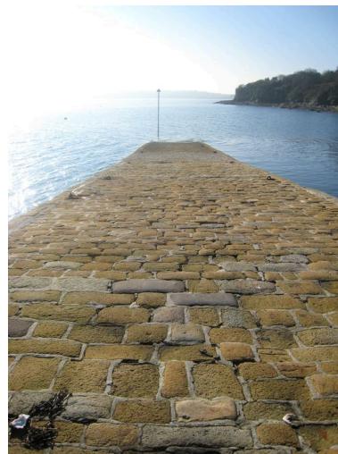
Cale du bourg de Roscanvel Phot. Françoise Péron IVR53_20072908924NUCA
