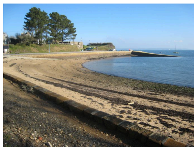
Débarcadère de Roscanvel Phot. Françoise Péron IVR53_20072908926NUCA
