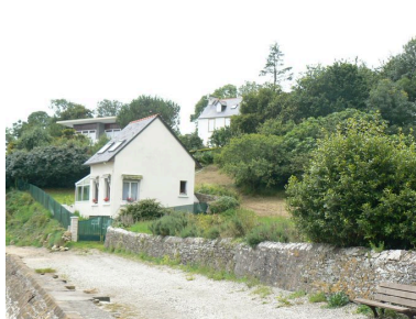
Maison du gardien du four à chaux Phot. Lénaïg L'Aot IVR53_20072908937NUCA
