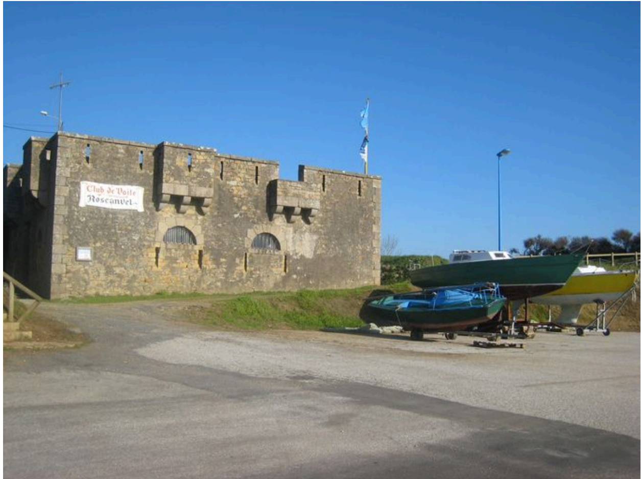
Corps de garde du port
