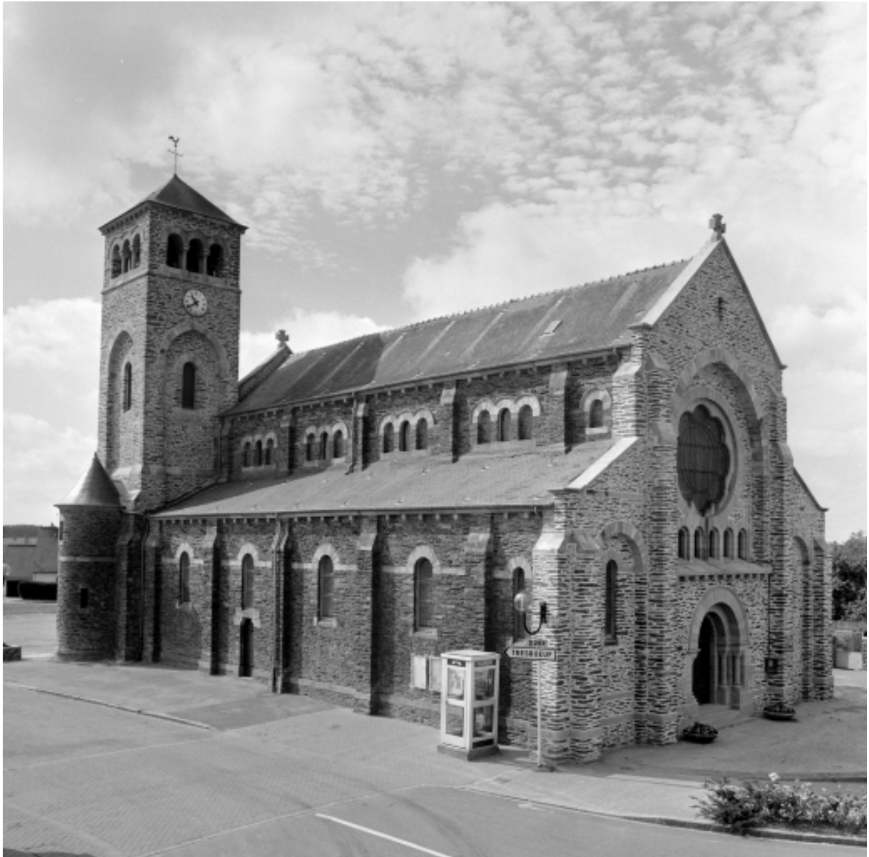
Elévation nord-ouest : vue générale
