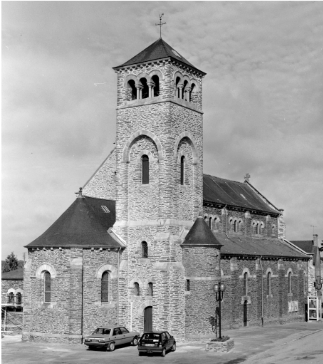
Elévation est : vue générale
